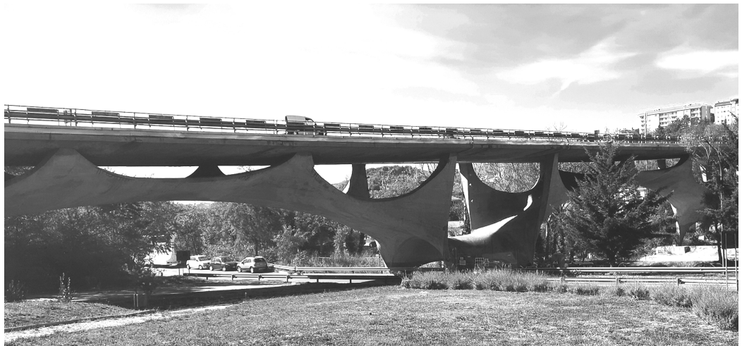
Fig. 3. Il ponte sul Basento progettato da Sergio Musmeci nel 1967.
