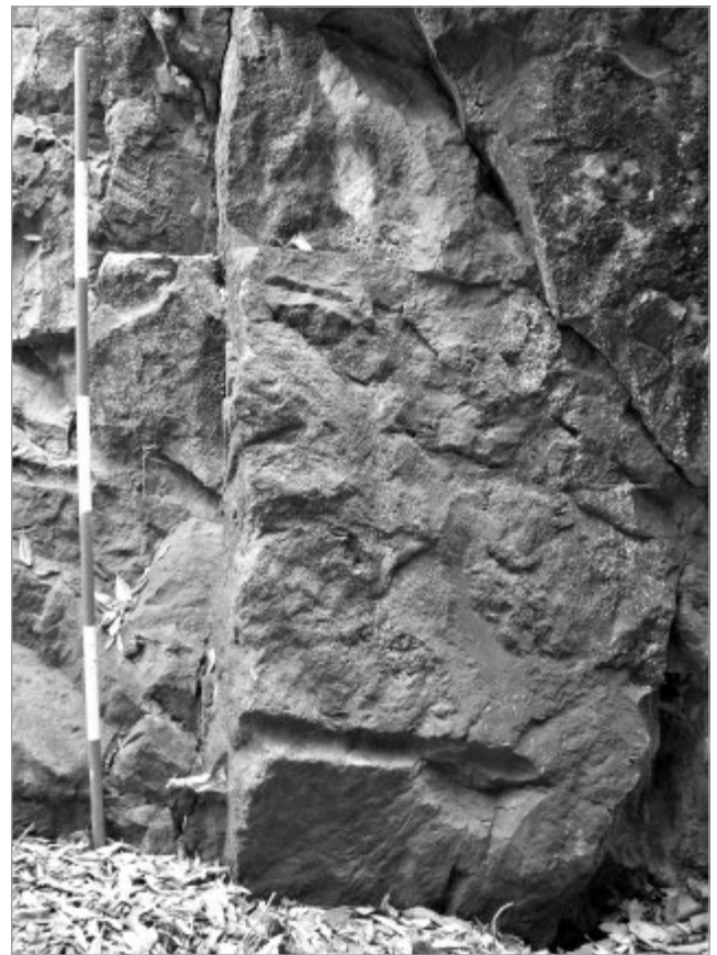
fig. 2 – Traccia di mina in sezione.
