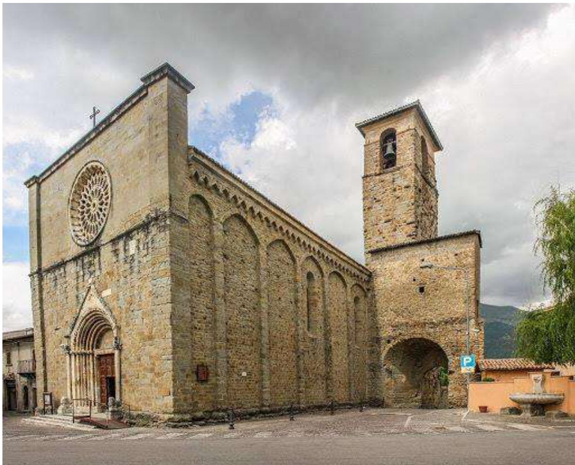
Figura 5.2: Vista laterale della chiesa di Sant'Agostino di Amatrice prima del sisma del 24 agosto 2016. Visibili la Porta Carbonara con il campanile costruito al di sopra. Fonte: meteoweb.eu (data ultima consultazione 23/08/20)
