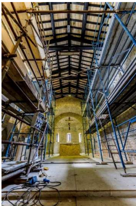
Figura 3.2.15: Opere di messa in sicurezza all'interno della chiesa abbaziale dei Santi Ruffino e Vitale ad Amandola. ( comune.amandola.fm.it )(data ultima consultazione 20/07/20)
