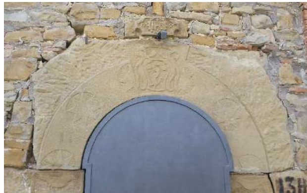
Figura 4.48: Moletano Palazzetto Ruggeri. A sinistra: portale in pietra arenaria scolpita incorniciato da decorazione realizzata in laterizio. Sopra: dettaglio dell'arco in pietra del portale ricavato da un unico blocco monolitico di arenaria
