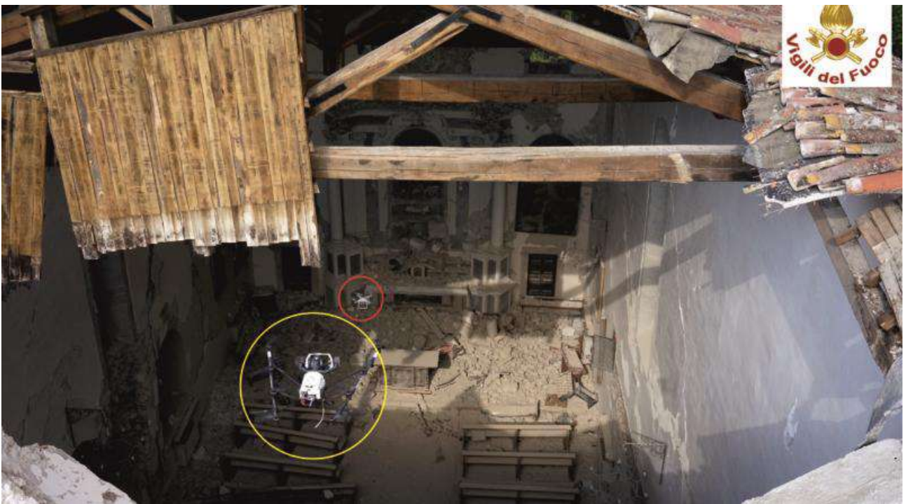
Figura 2.3.4 Ingresso degli UAV TRADR nella chiesa di S. Agostino ad Amatrice. (vigilfuocotv.it)(data ultima consultazione 20/07/20)
