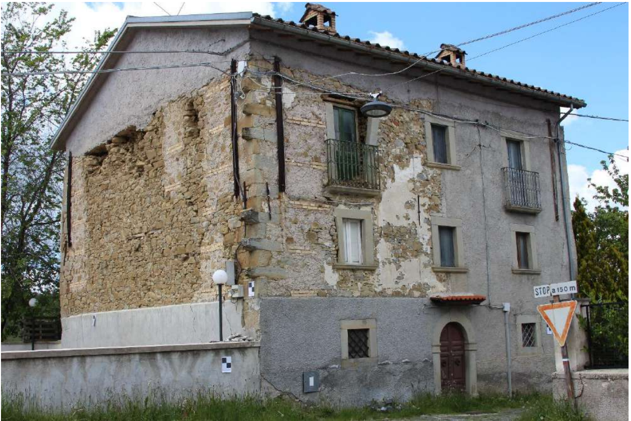
Figura 4.20: Cornillo Nuovo, edificio A, con muratura con ricorsi in laterizio
