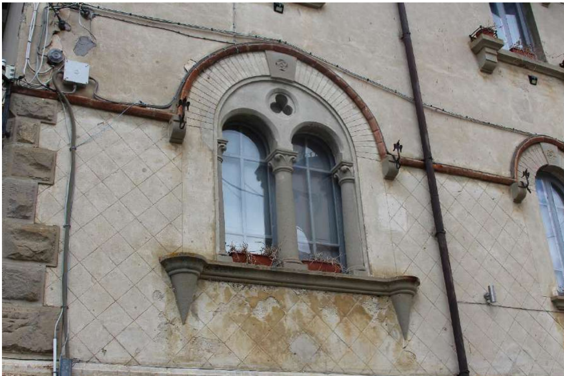
Figura 4.30: Preta, edificio B, dettaglio dell'elaborata lavorazione dell'intonaco e della presenza di numerose decorazioni realizzate con malte cementizie decorative
