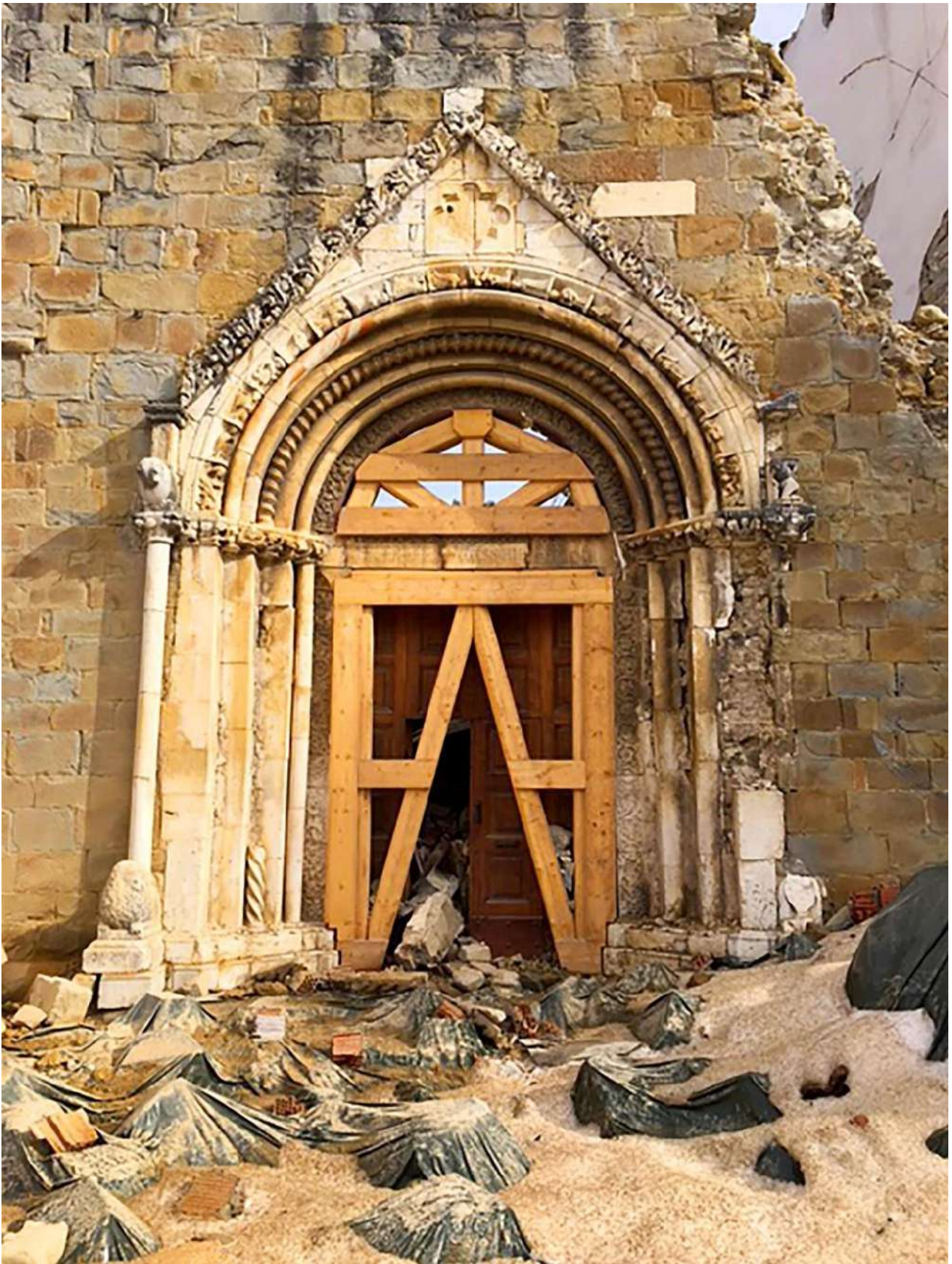
Figura 5.12: Stato del portale di Sant'Agostino di Amatrice dopo il 29/01/2017, prima del trasporto in deposito delle macerie crollate. Le macerie si trovano a terra al di sotto degli appositi teli di protezione, parzialmente ricoperti dalla neve. Gentile concessione del Dott. Alessandro Betori UCCR-Lazio.
