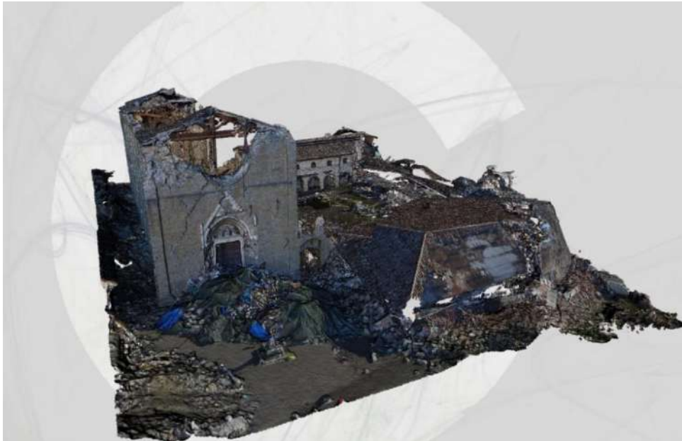
Figura 2.3.1 Modello 3D navigabile online della chiesa di S. Francesco di Amatrice derivante dall'integrazione dei rilievi fotogrammetrici da drone ( https://www.gter.it/3dhosting/rilievi_terremoto ) (data ultima consultazione 20/07/20)
