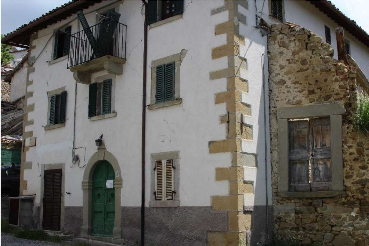
Figura 4.35: Castel Trione, edificio C, dettaglio dei cantonali in blocchi di pietra squadrata a vista.
