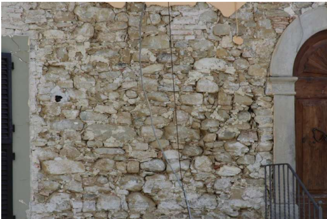
Figura 4.19: Cascello, edificio A, dettaglio muratura con lacune riempite in laterizio
