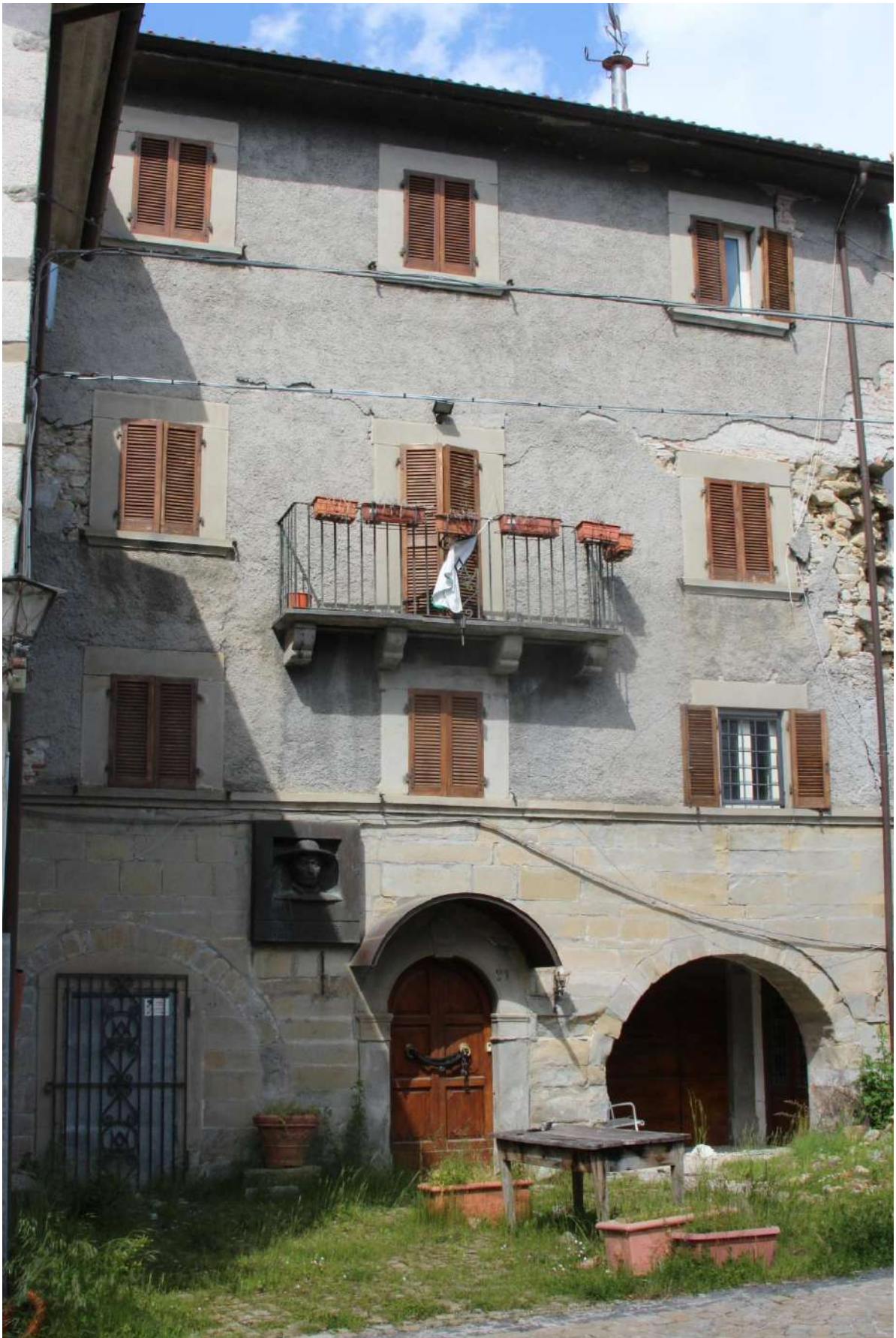
Figura 4.25: Preta, facciata Casa del Padre Don Giovanni Minozzi, piano terra in muratura in pietra squadrata
