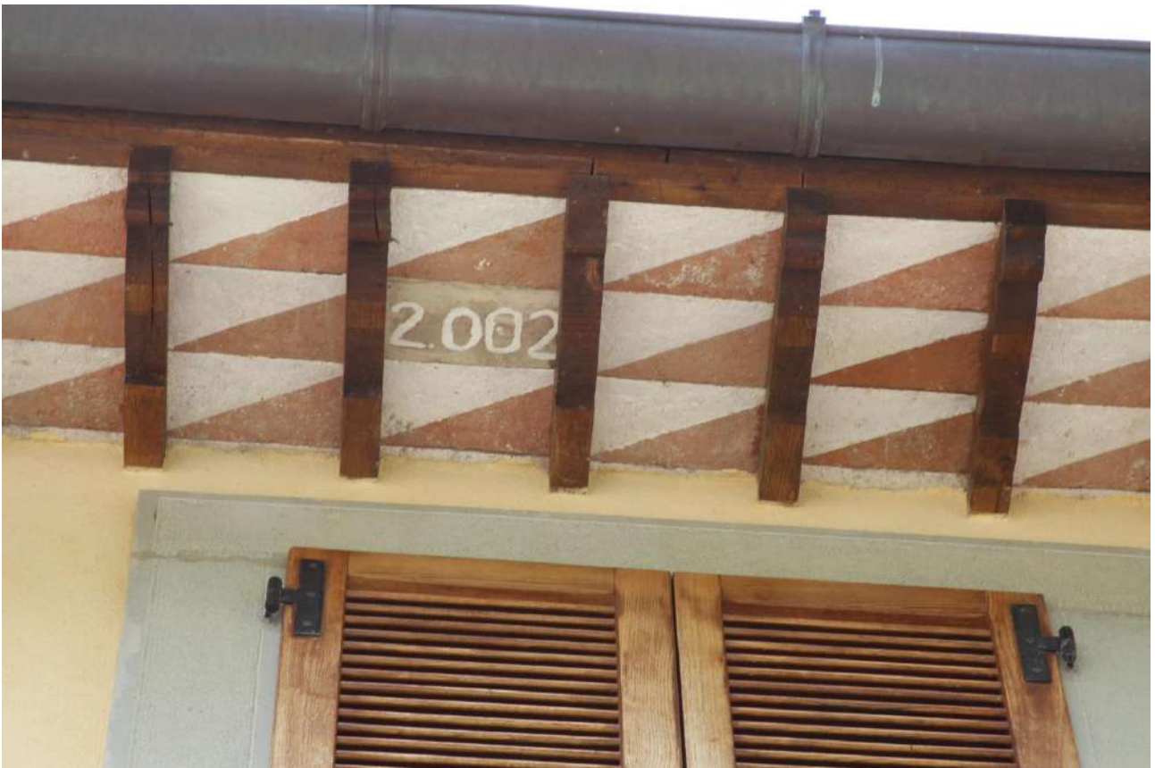
Figura 4.42: Capricchia, edificio N. Particolare della decorazione bicroma in copertura, datata 2002
