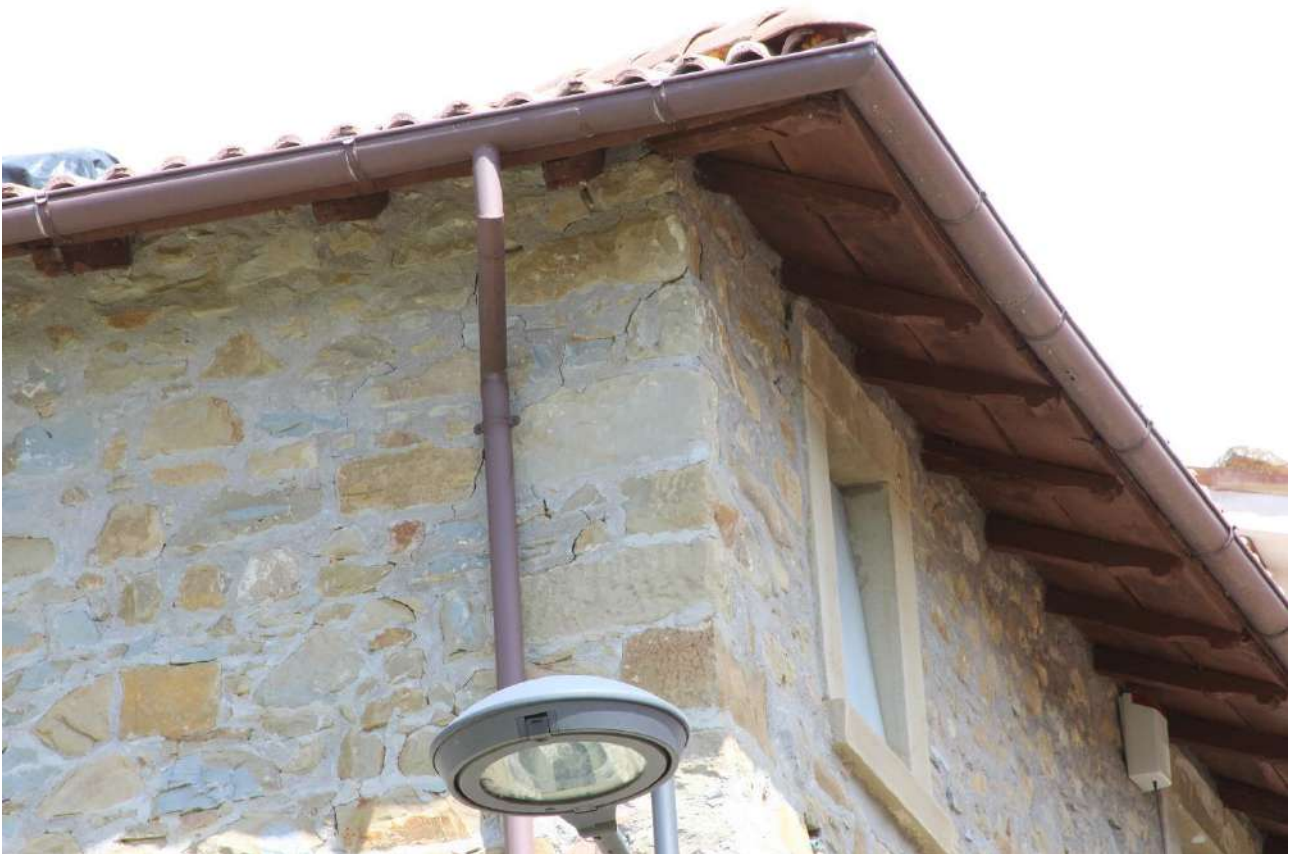
Figura 4.34: Castel Trione, edificio Q, dettaglio della copertura lignea di recente sostituzione
