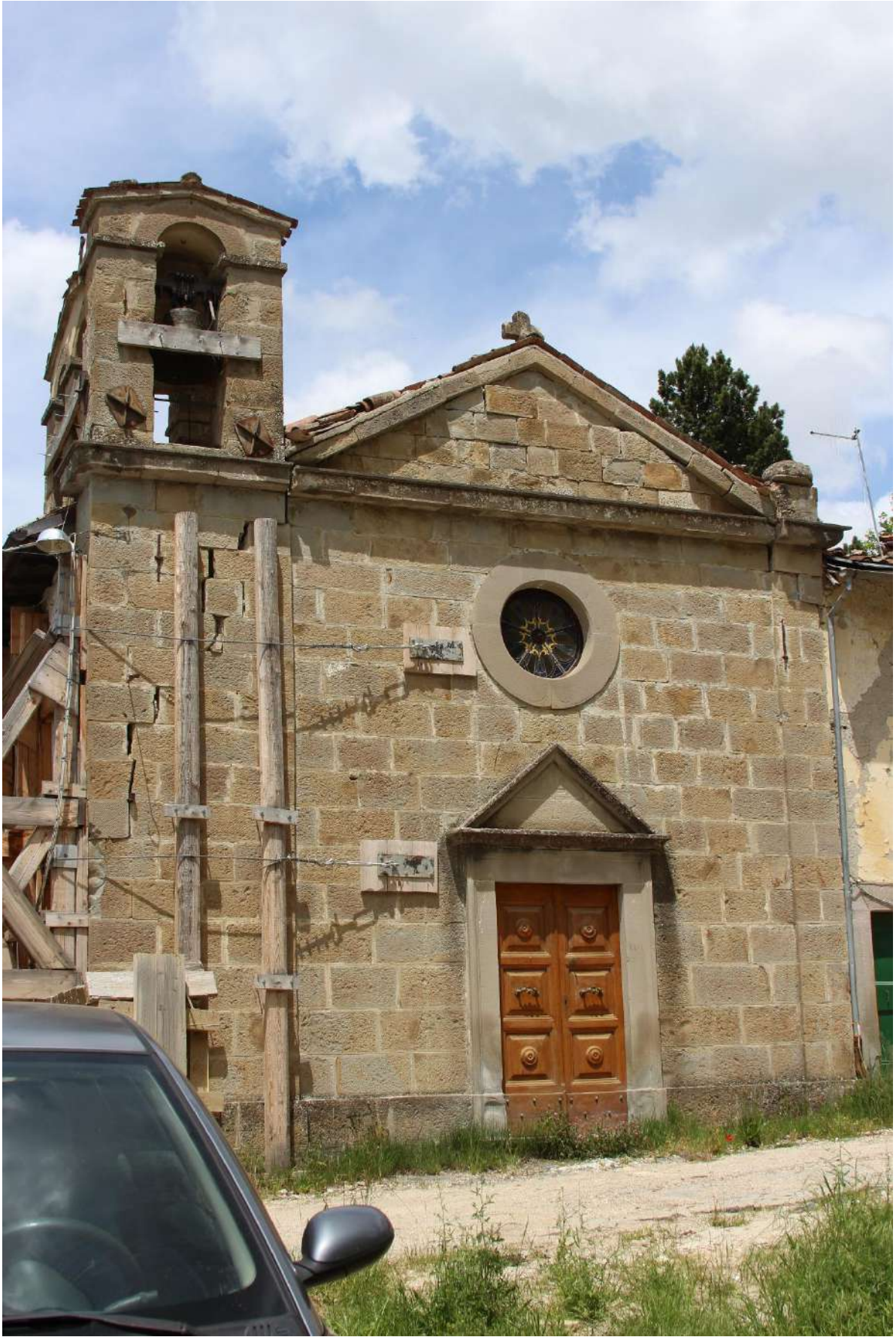
Figura 4.24: Capricchia, facciata Chiesa dell'Annunziata
