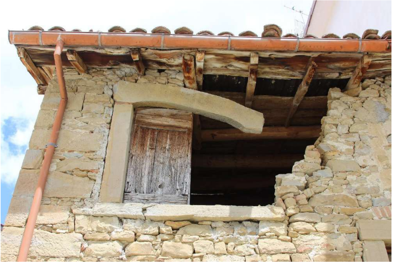
Figura 4.33: Cornillo Nuovo, edificio E, dettaglio di una copertura lignea tradizionale
