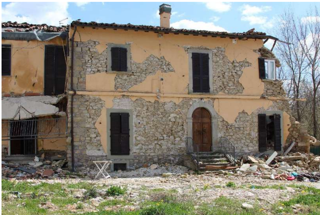
Figura 4.38: Cascello, edificio A, facciata con cornici delle finestre semplici in pietra arenaria
