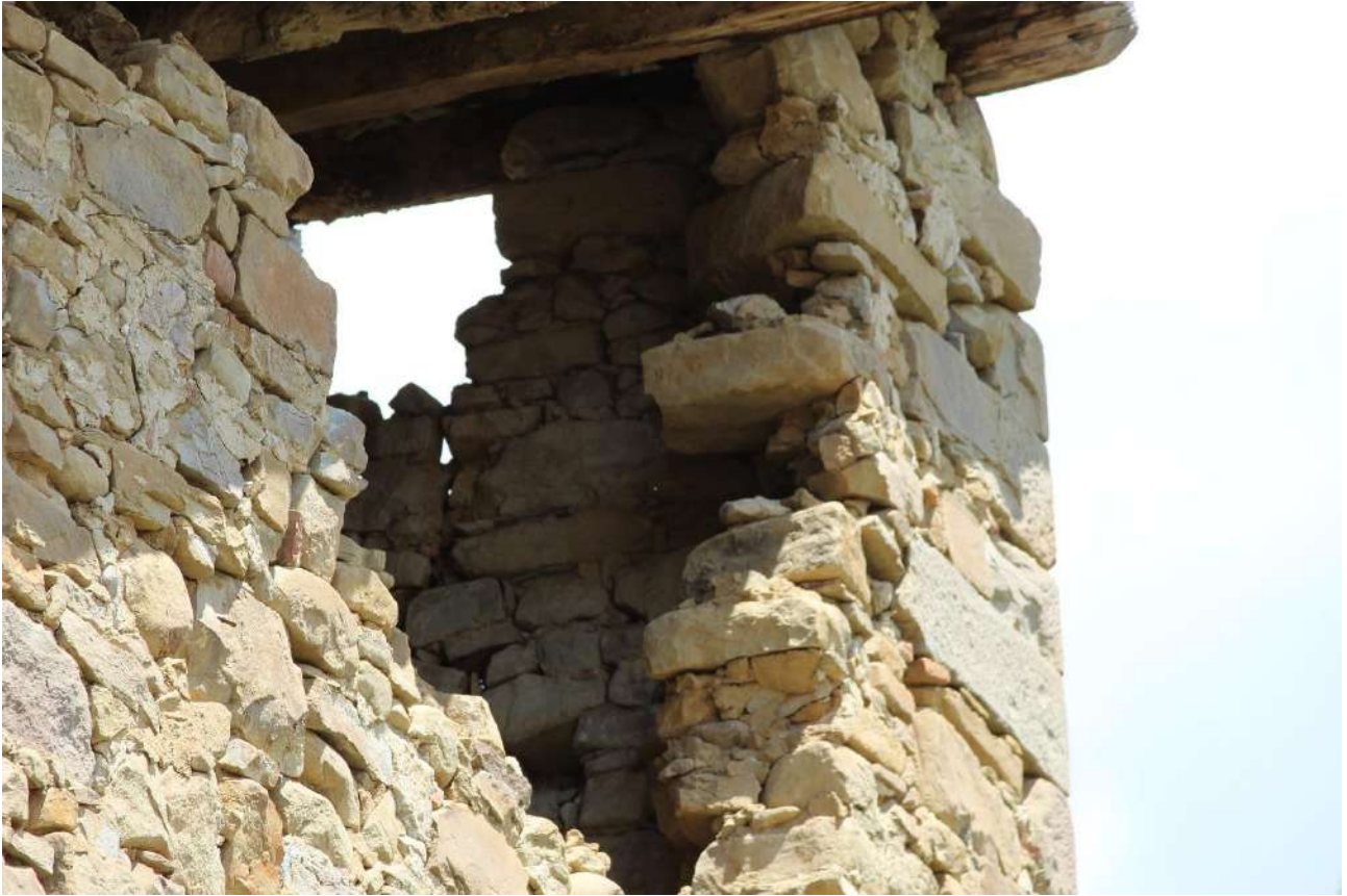
Figura 4.18: Castel Trione, edificio X3, dettaglio sezione muraria
