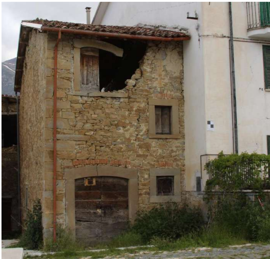
Figura 4.36: Cornillo Nuovo, edificio E, anche negli edifici più semplici sono presenti angolate in pietra squadrata
