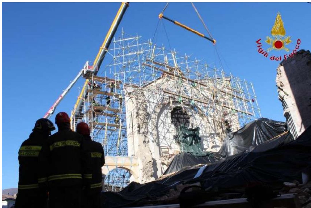
Figura 3.2.21: Opere di messa in sicurezza della facciata della Basilica di San Benedetto a Norcia, rimasta isolata a seguito del crollo totale del corpo centrale della chiesa. ( vigilfuocotv.it )(data ultima consultazione 20/07/20)
