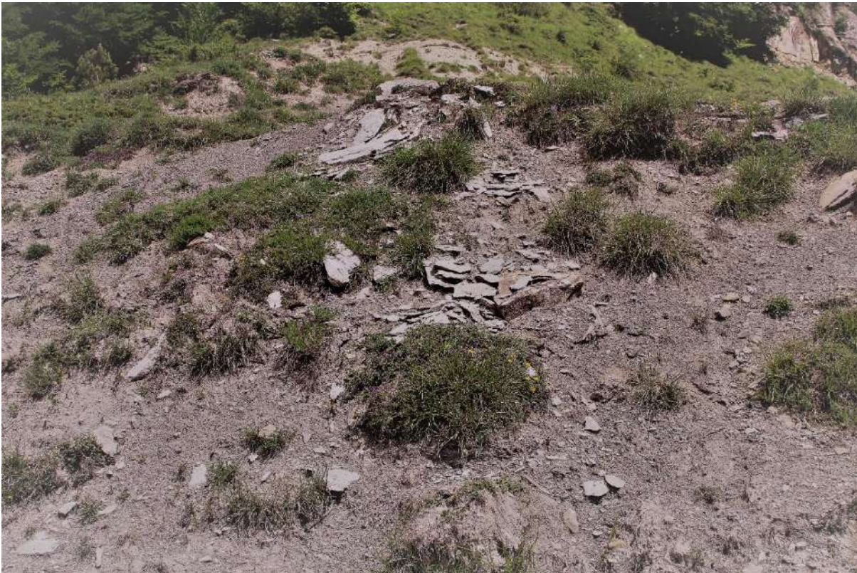
Figura 3.4.5: Detriti di degradazione dei banconi arenacei.
