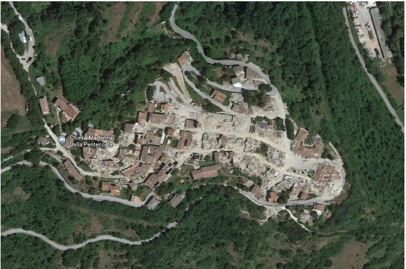
Figura 3.2.4: Immagine satellitare del centro storico di Accumoli, quasi del tutto distrutto. Dati Google Earth, 2018.
