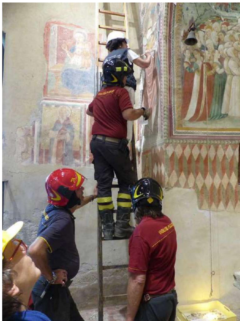
Figura 3.2.12: Messa in sicurezza degli affreschi nel Santuario della Madonna della Filetta ad Amatrice. (vigilfuocotv.it)(data ultima consultazione 20/07/20)
