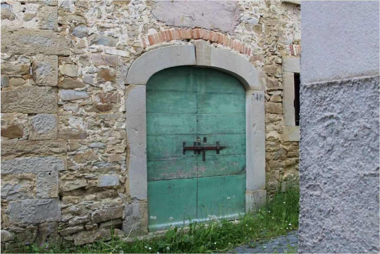
Figura 4.49: Cornillo Nuovo, edificio T. Dettaglio della piattabanda realizzata in laterizi
