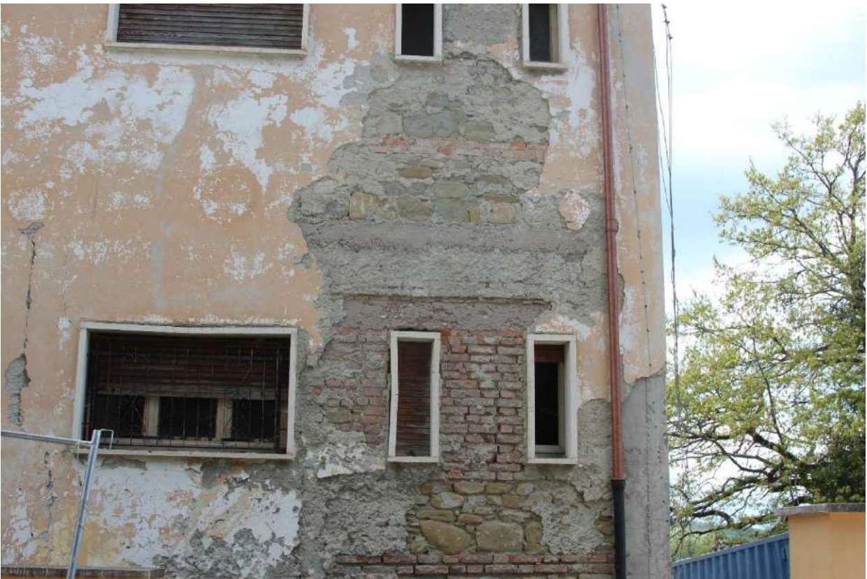
Figura 4.23: Preta, istituto scolastico professionale Don Giovanni Minozzi, dettaglio tecnica mista muratura e c.a.
