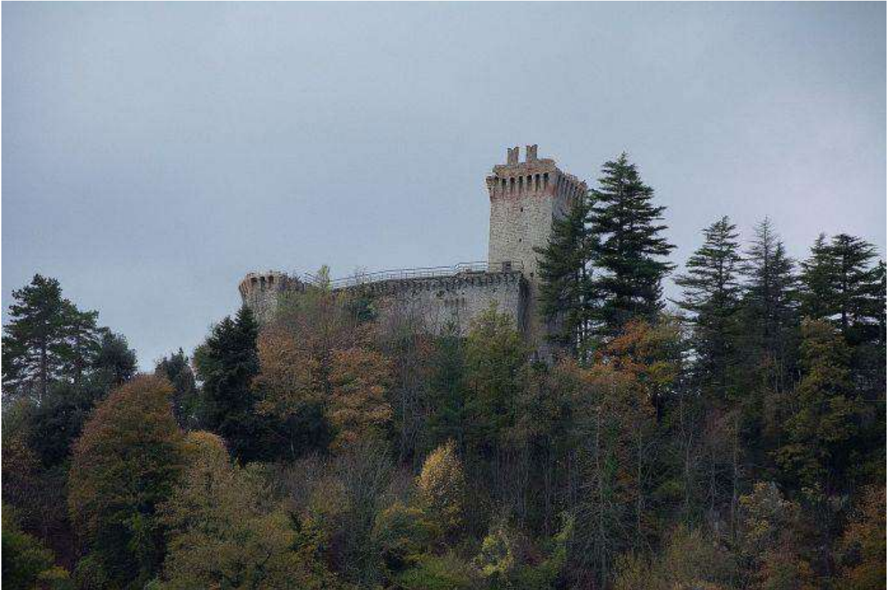
Figura 3.2.18: Rocca di Arquata del Tronto, visibili i danni in sommità della torre, con i merli quasi del tutto crollati. (www.comune.arquatadeltronto.ap.it)(data ultima consultazione 20/07/20)
