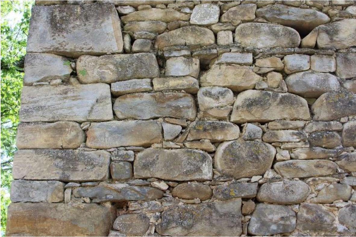
Figura 4.16: Retrosi, edificio B, dettaglio muratura
