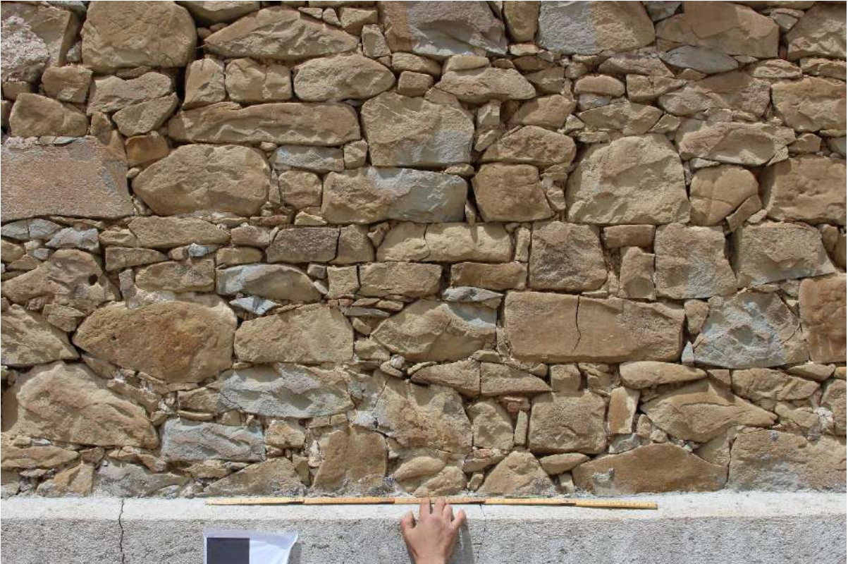
Figura 4.14: Cornillo Nuovo, edificio A, dettaglio muratura
