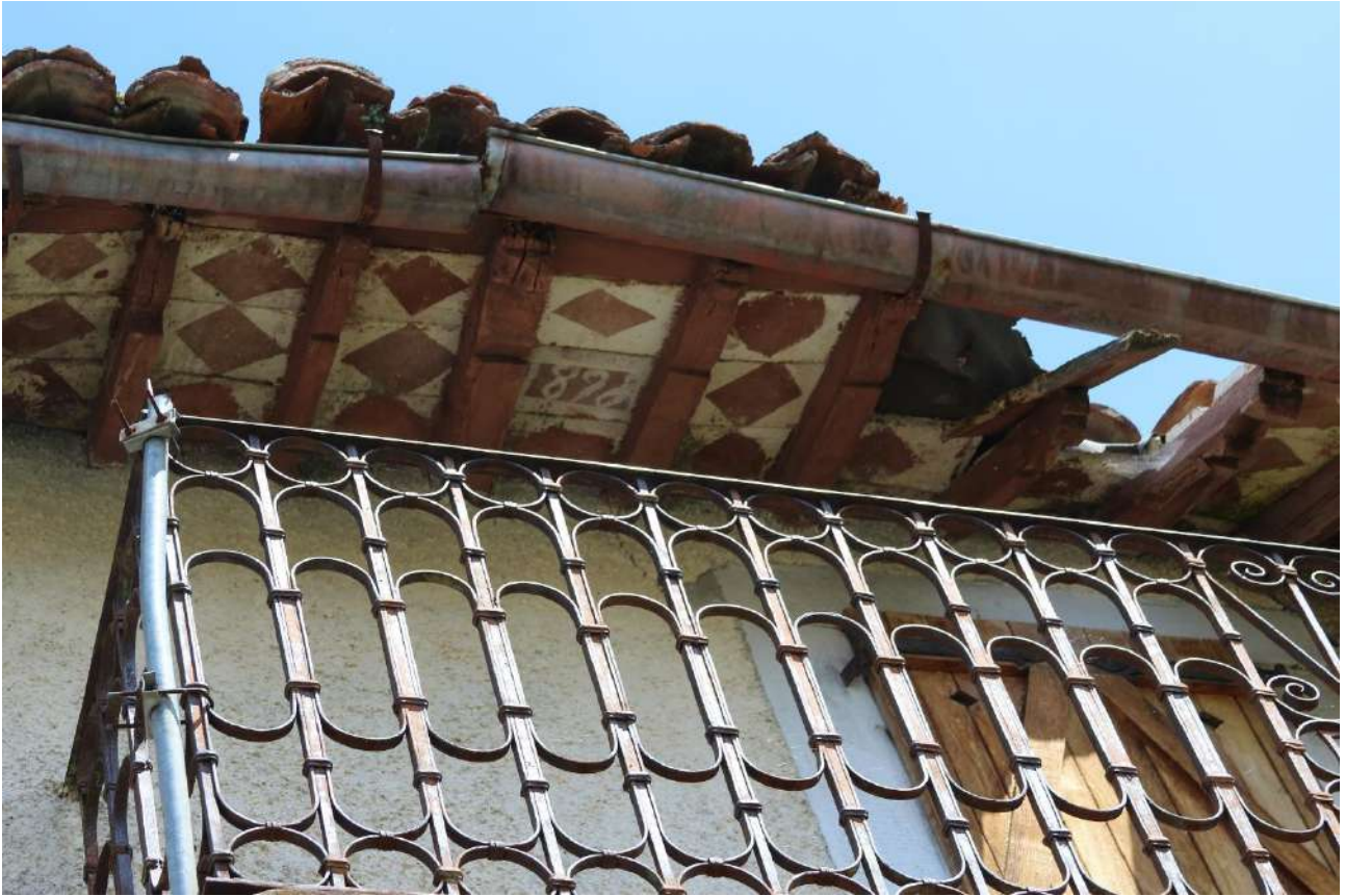
Figura 4.41: Castel Trione, edificio D. Particolare della decorazione bicroma a losanghe in copertura, datata 1898
