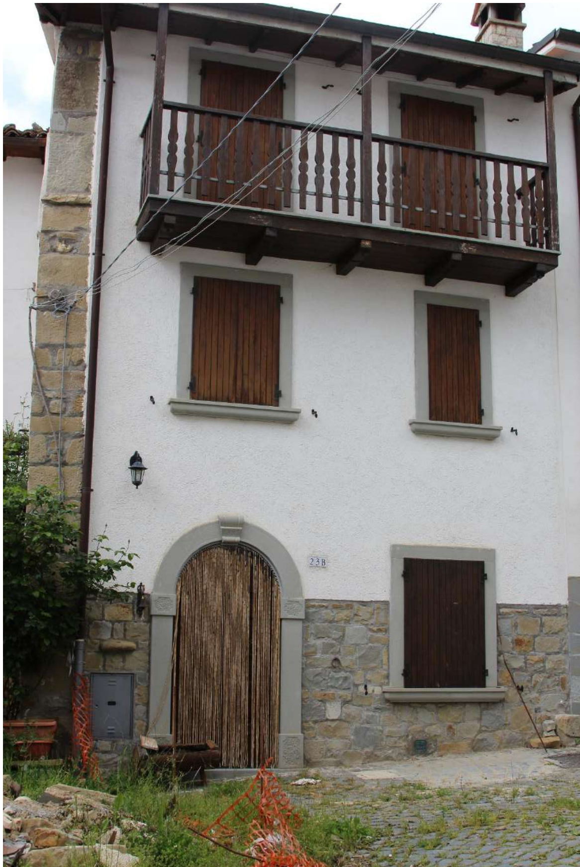
Figura 4.39: Capricchia, edificio V, facciata con balcone tradizionale in legno
