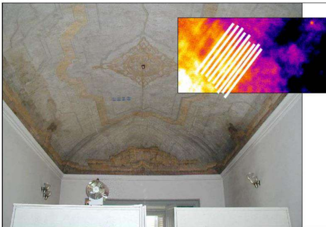
Figura 2.1.3: Volta dell'ex refettorio di Villa Litta Modignani a Milano. La termografia IR mette in evidenza la tessitura muraria al di sotto dell'intonaco e il piano d'imposta dei mattoni. Fonte (LUALDI ET AL. 2003)
