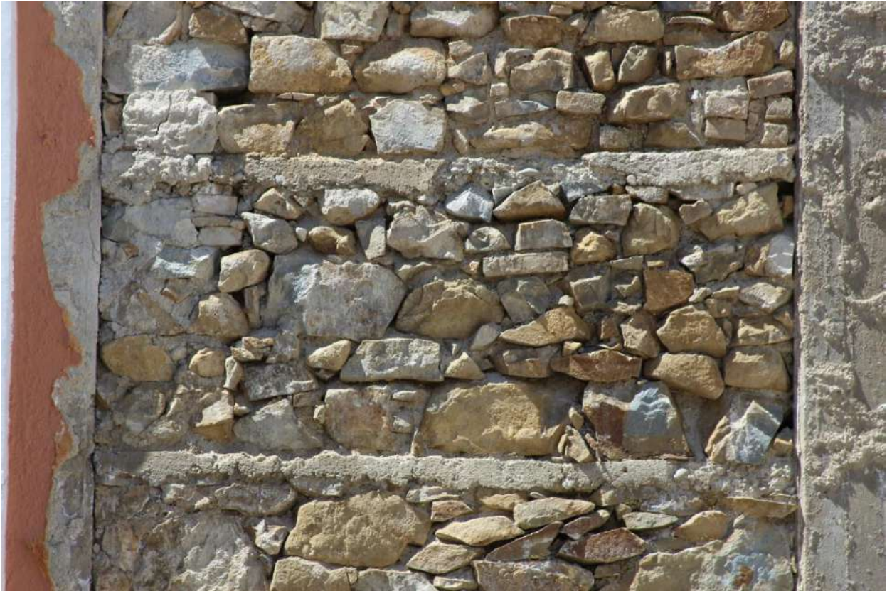
Figura 4.22: Amatrice, orfanotrofio Don Giovanni Minozzi, dettaglio tecnica mista muratura e c.a.
