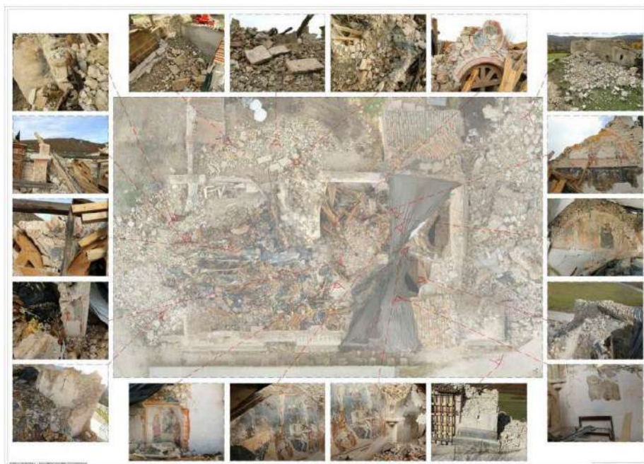
Figura 2.3.2 Documentazione fotografica dello stato di crollo e distribuzione delle macerie a terra della chiesa di San Salvatore in Campi di Norcia, riferita a rilievo in pianta da drone (visione d'insieme). ( sansalvatoreincampi.beniculturali.it ) (data ultima consultazione 20/07/20)
