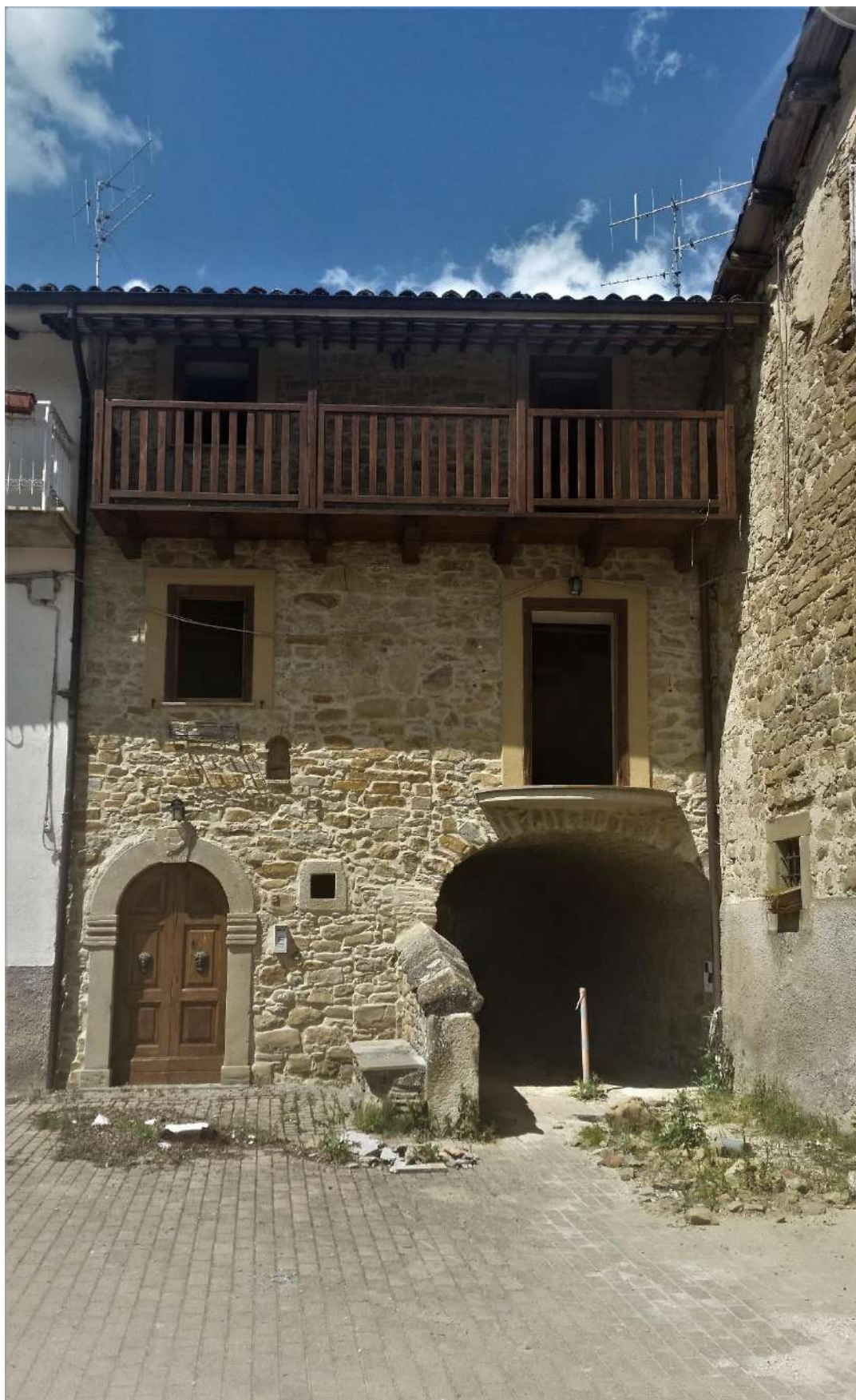
Figura 4.40: Collocreta, edificio H, facciata con balcone tradizionale in legno
