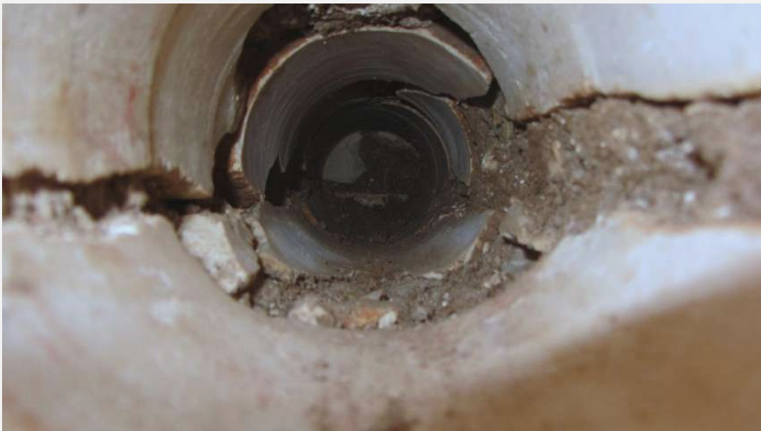
Figura 1.2.2 Ripresa fotografica endoscopica di una muratura in mattoni pieni.
