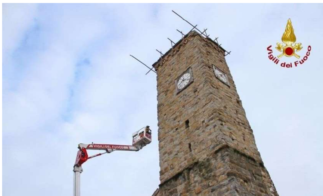
Figura 3.2.13: Messa in sicurezza della Torre Civica di Amatrice. (vigilfuocotv.it)(data ultima consultazione 20/07/20)
