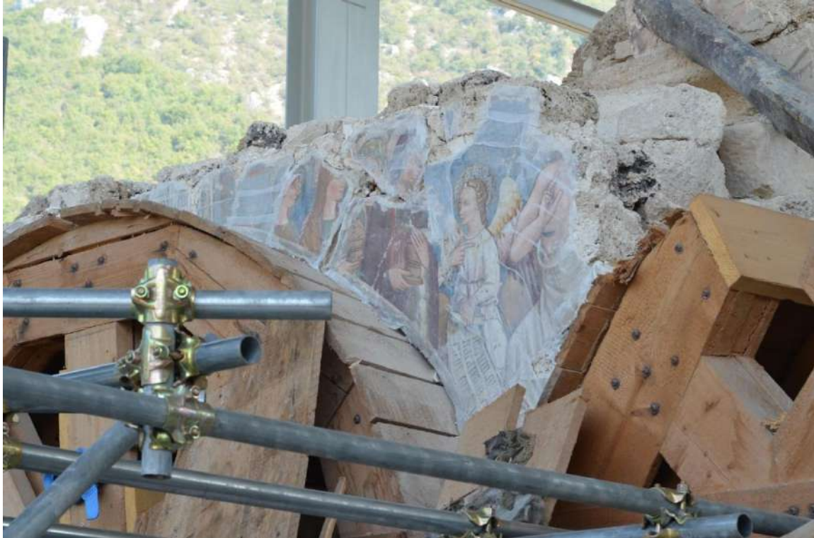
Figura 3.2.24: Messa in sicurezza dei pochi lacerti di affresco rimasti sui resti della chiesa di San Salvatore in Campi di Norcia. ( sansalvatoreincampi.beniculturali.it )(data ultima consultazione 20/07/20)
