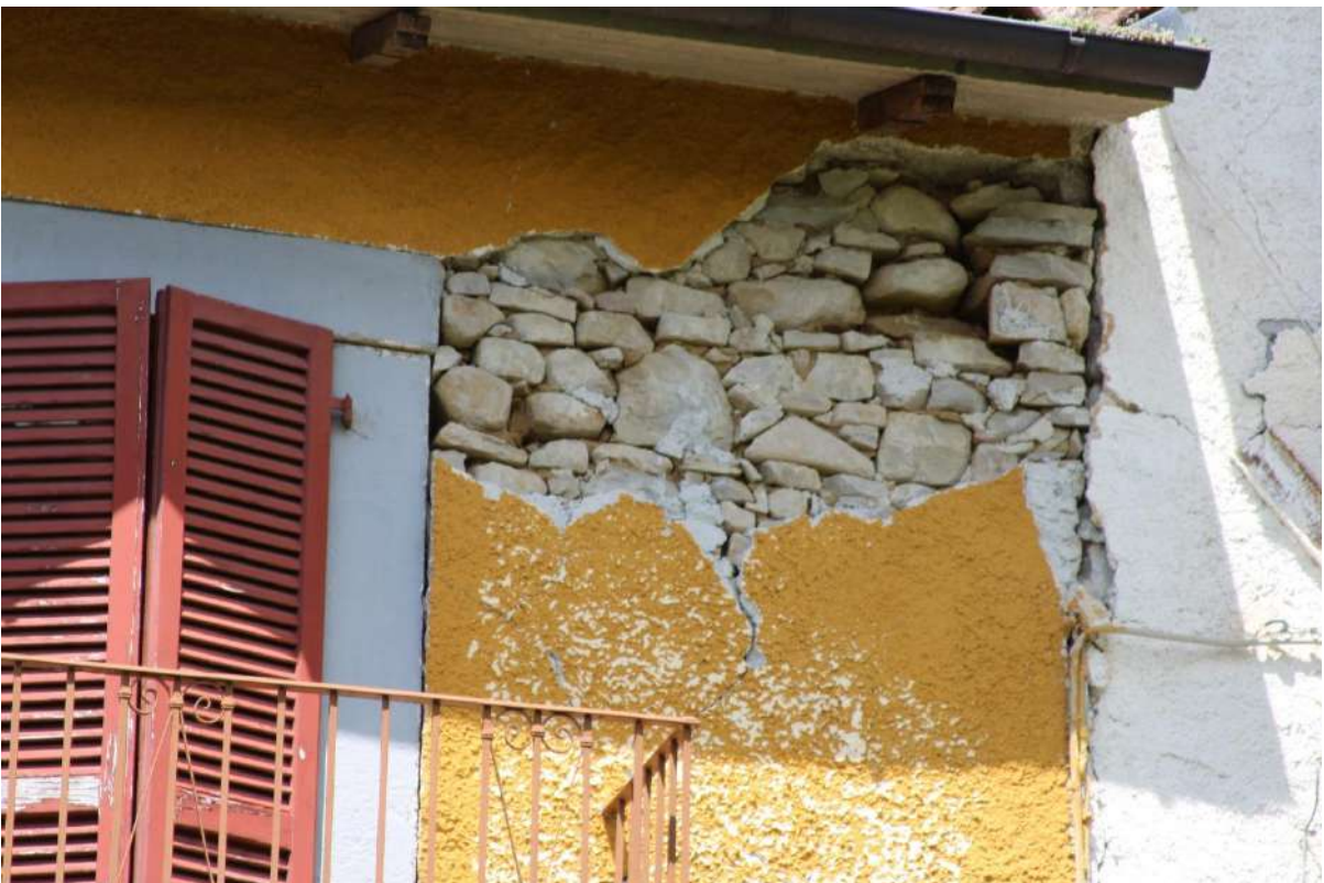
Figura 4.15: Castel Trione, edificio I, dettaglio muratura
