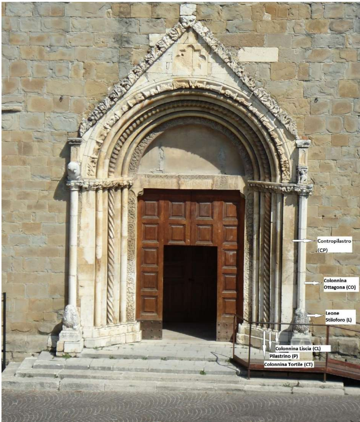
Figura 5.11: Codificazione degli elementi interessati dai crolli prodotti nella sequenza sismica del 2016-2017 su documentazione fotografica precedente al sisma. CL – Colonnina Liscia: Sono presenti cinque colonnine lisce: due per ogni lato e una più esterna a sinistra. CO – Colonnina Ottagona: è presente una sola colonnina ottagonale, esterna alla destra del portale. CT – Colonnina Tortile: sono presenti due colonnine tortili, una per ogni lato. L – Leone Stilofo: sono presenti due leoni stilofo alla base delle colonnine esterne (a sinistra liscia, a destra ottagonale). P – Pilastrino: sono presenti due pilastrini per ogni lato. CP – Contropilastrino: sono presenti due contropilastrini ai due lati del portale. Il numero di componenti per ogni elemento a sinistra dall'interno verso l'esterno segue lo schema:
