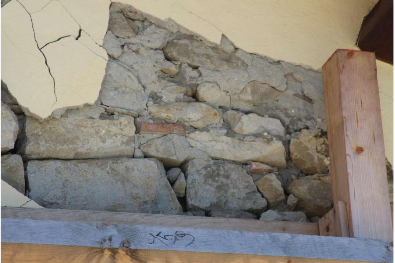
Figura 4.28: Ferrazza, Santuario dell'Icona Passatora, dettaglio della muratura della parete absidale
