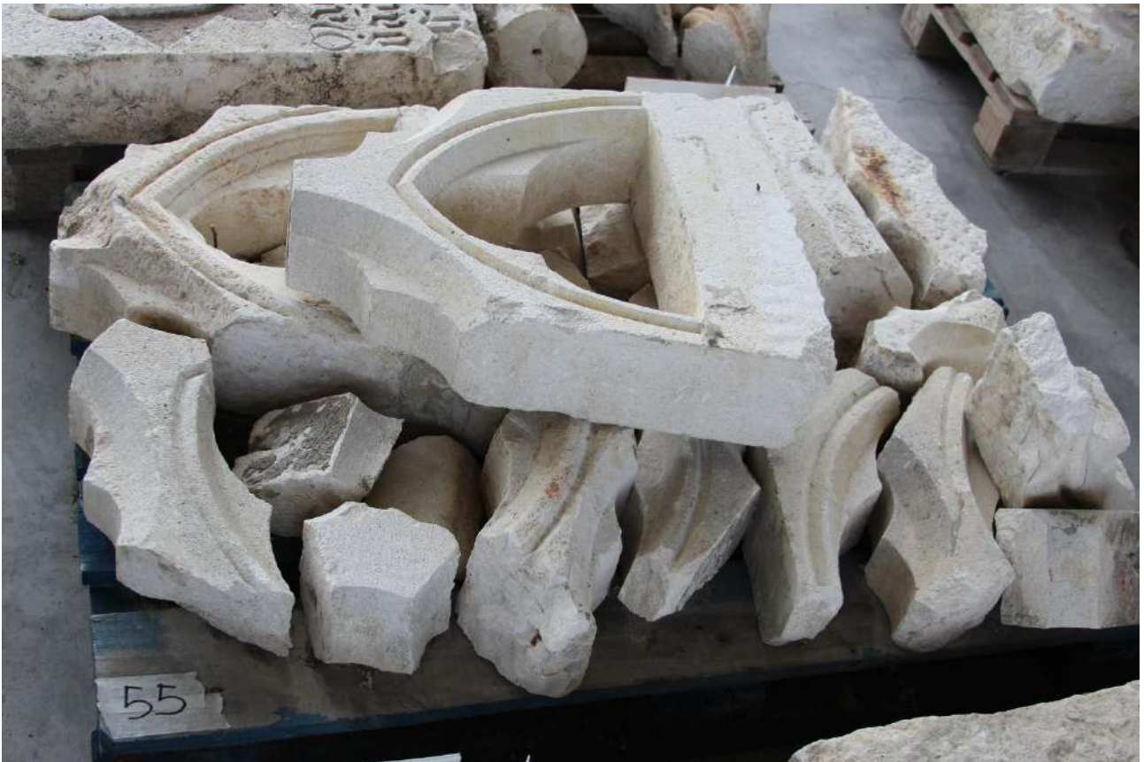
Figura 5.17: Bancale 55 su cui sono disposte macerie del rosone della chiesa di Sant'Agostino di Amatrice. Si noti come i due elementi di tipo D scolpiti con motivi decorativi trilobati siano evidentemente diversi dal punto di vista materico. Quello sovrastante è realizzato in biocalcare (BCA), quello sottostante è in marmo (MA). Si noti come anche i dettagli delle modanature e zone scolpite risultino molto più semplificate e piatte sull'elemento in biocalcare.
