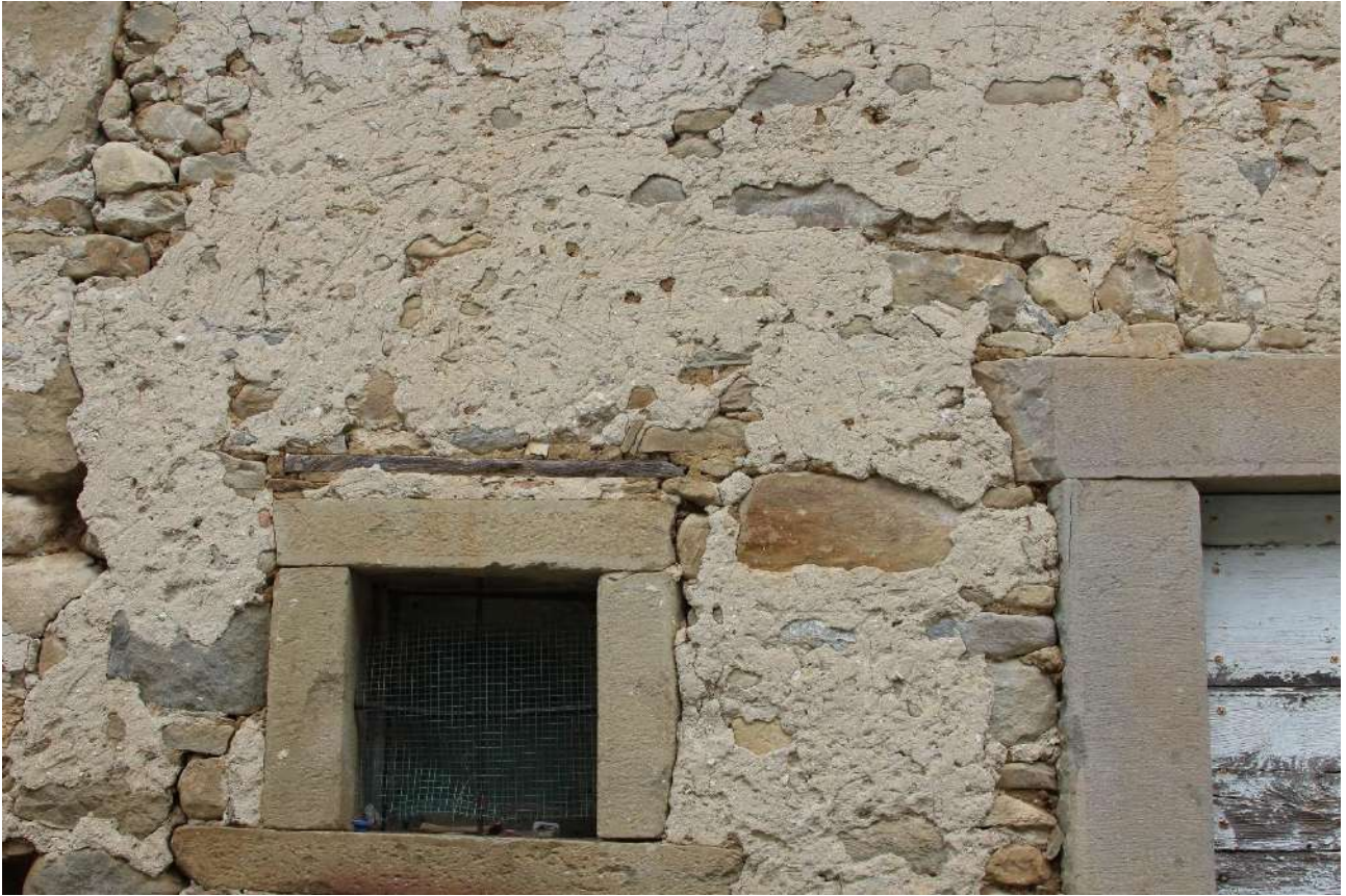
Figura 4.32: Capricchia, edificio I, dettaglio della finitura superficiale di tipo tradizionale diffusa nel territorio
