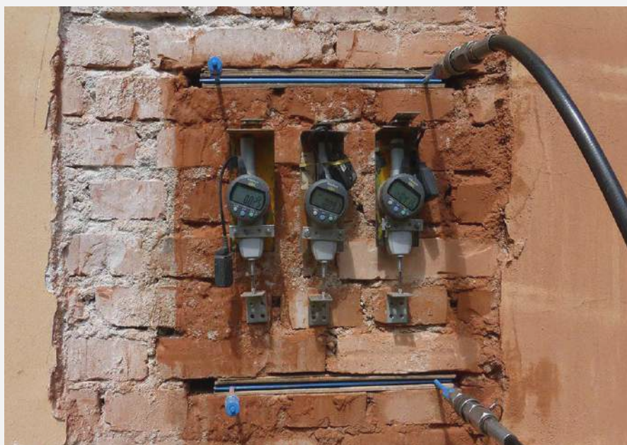
Figura 1.2.6 Esecuzione di una prova con martinetto piatto doppio.
