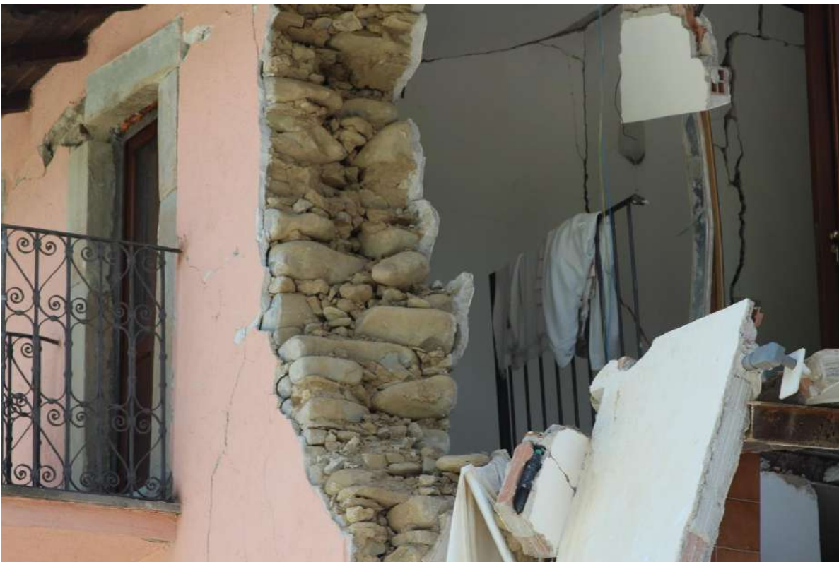
Figura 4.17: Retrosi, edificio F, dettaglio sezione muraria
