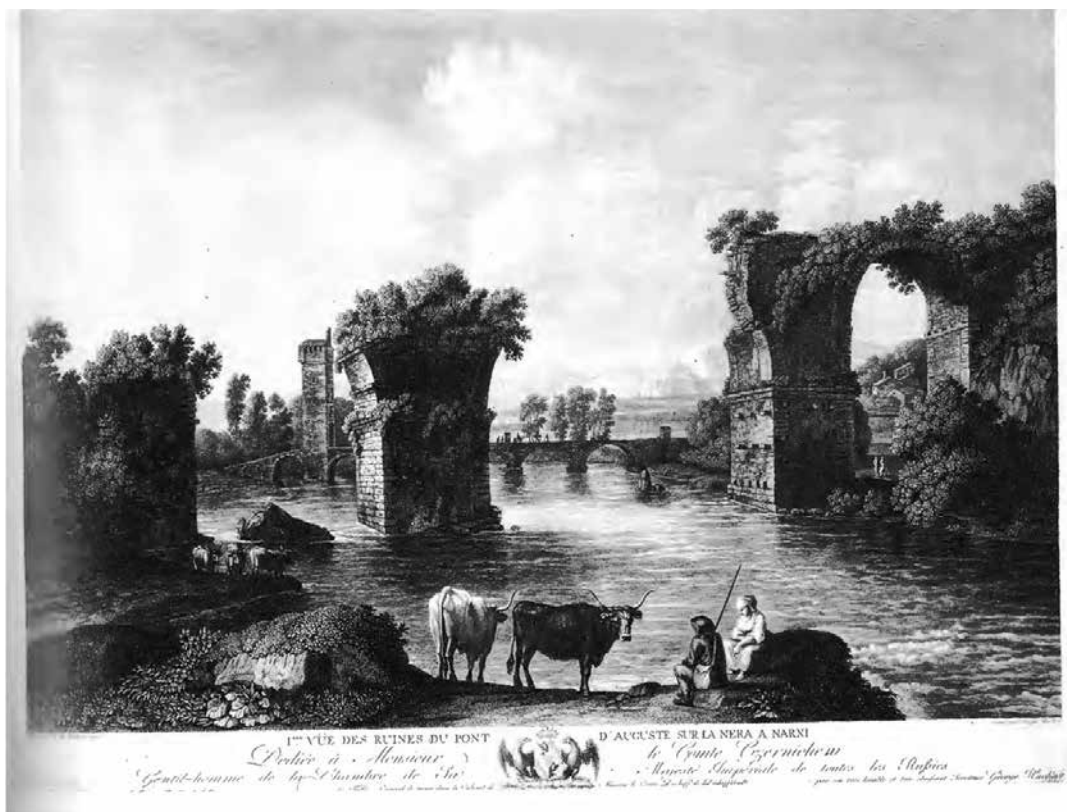
Fig. 5. Incisione di Hackert, 1779. E' visibile l'allargamento dell'alveo del fiume, la pendenza del pilone crollato nel 1885, l'antico ponte medievale che consentiva l'attraversamento del fiume Nera (da Tattoli 2000)
