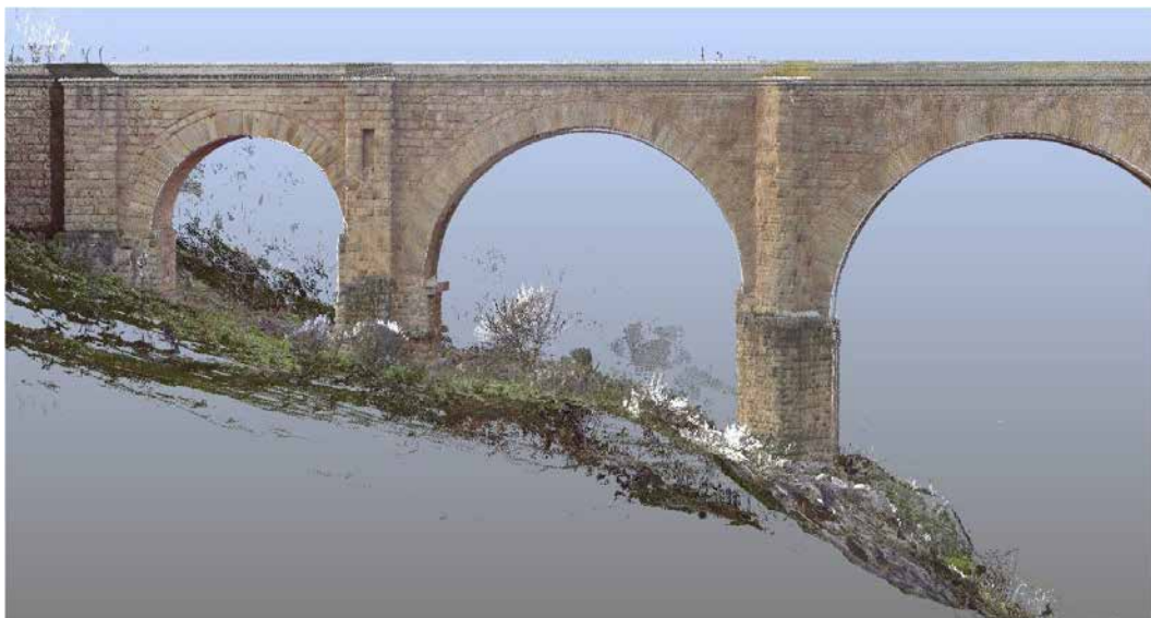
Fig. 2. Ponte romano ad Alcantara. Vista della points-cloud (Inglese C.)
