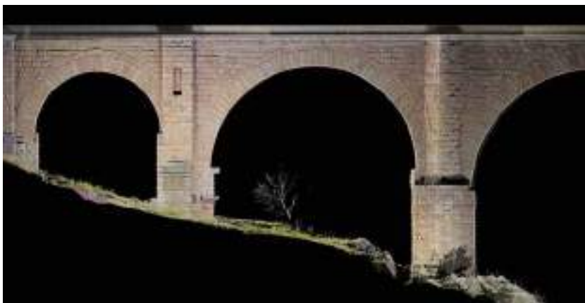
Fig. 7. Ponte di Alcántara. Modello numerico, nuvola di punti. Particolare prospetto nord-est (elaborazione di Carlo Inglese).
