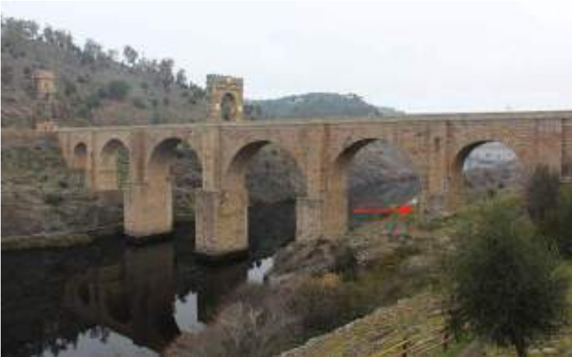
Fig. 4. Vista generale del ponte di Alcántara con indicazione del pilastro in cui si conserva la prima fase costruttiva del monumento (da PIZZO 2016, 8, fig. 5).
