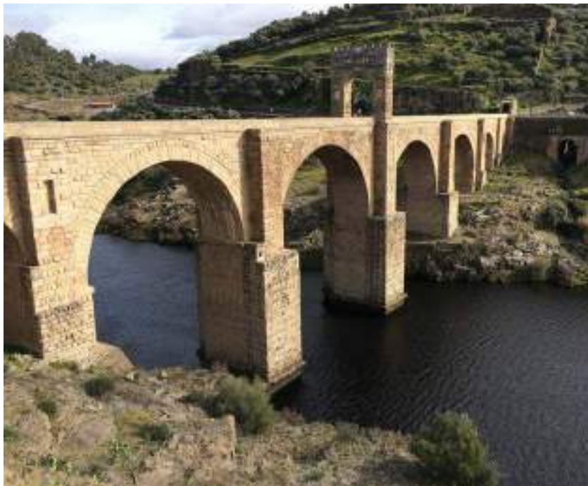
Fig. 1. Ponte di Alcántara, veduta generale prospetto sud-ovest (foto di Carlo Inglese, 2015).
