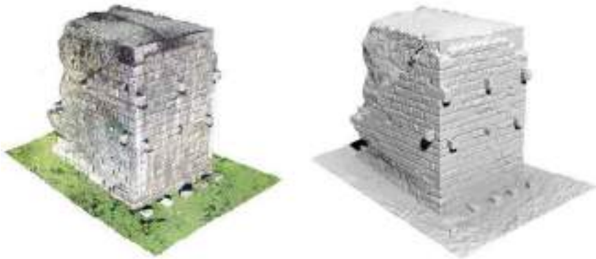
Fig. 4. Conversione di un modello per punti in mesh: pilone del Ponte di Augusto a Narni (elaborazione di Wissam Wabbeh).
