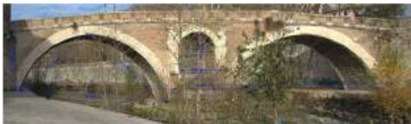
Fig. 11. Prospetto attuale a valle. Fotoraddrizzamento e misurazione delle superfici rettificcate (elaborazione di Daniele Maiorino).
