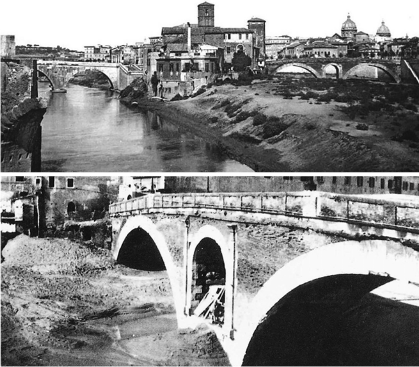
Fig. 6. In alto: vista dell'Isola Tiberina, estremità est, con il ramo destro del fiume insabbiato, 1899 (foto Berthaud; riproduzione su gentile concessione di Bruno Leoni, dal sito < http://www.isolatiberina.com >). In basso: interrimento del Tevere a Ponte Fabricio (da RAMIERI 2003).
