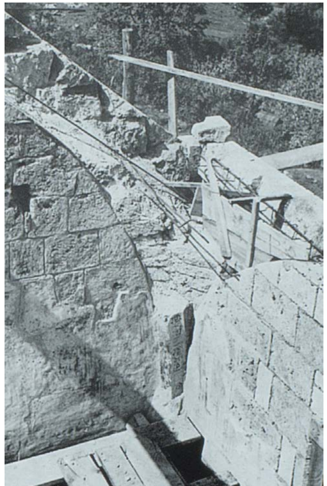
123-125. Galatsi, Omorphieklisia: volte a crociera nervate del nartece (123-124), volta a crociera "semplice" della campata sud-ovest del naos (125) 126. Gradac (Serbia), monastero: le volte a crociera nervate del nartece durante la ricostruzione
