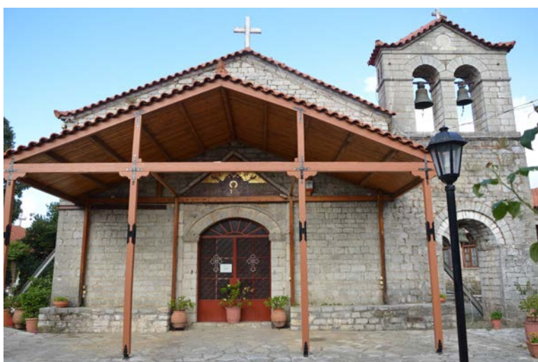
23. Monastero di Varnakova: facciata occidentale (situazione attuale dopo l'ultimo terremoto)
