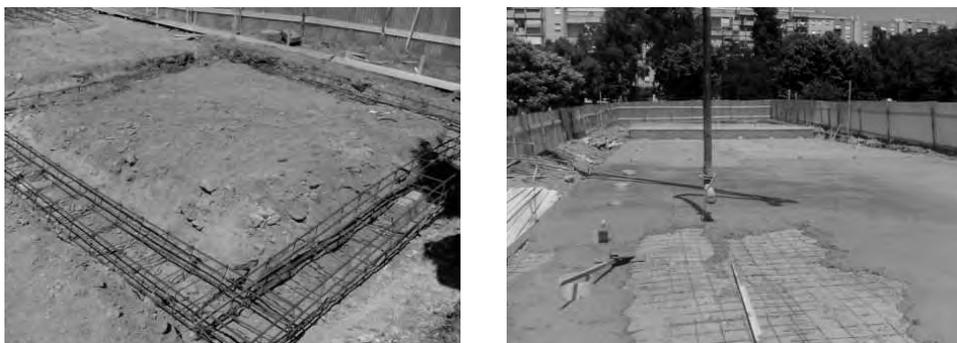
Fig. 6.20 Fase di realizzazione delle fondazioni
