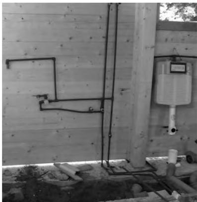
Fig. 6.23 Particolare della tubazione di collegamento tra lo scarico e l'impianto di fitodepurazione
