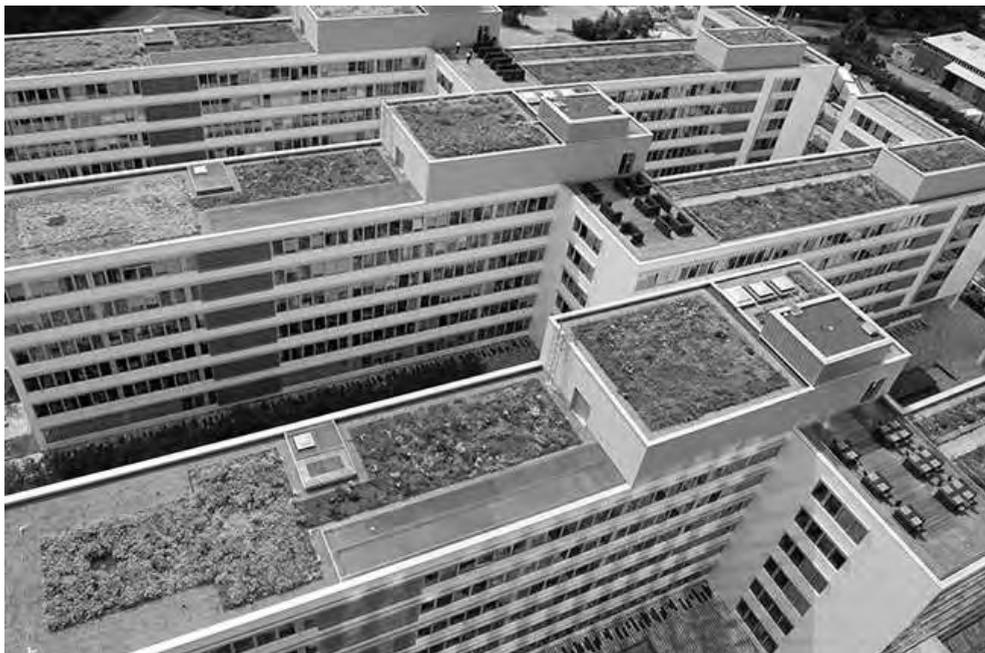
*Fig. 6.13 Esempio di tetto verde*
