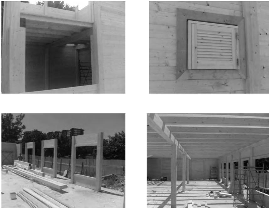
*Fig. 6.19 Inserimento della finestra preassemblata in stabilimento*
