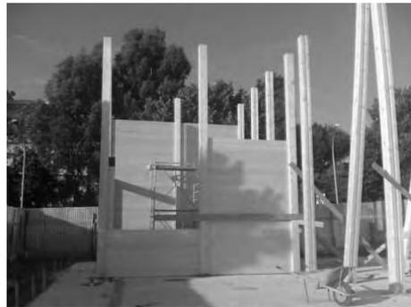
Fig. 6.11 Fase di montaggio delle chiusure verticali esterne
