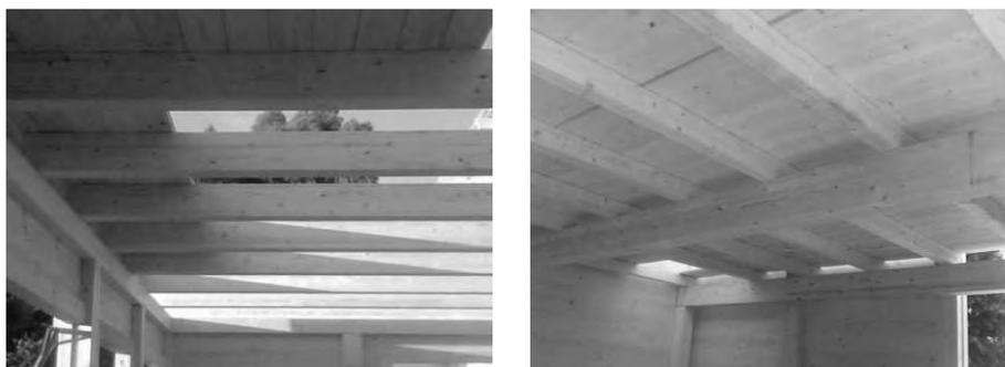
Fig. 6.16 Realizzazione del solaio di copertura
