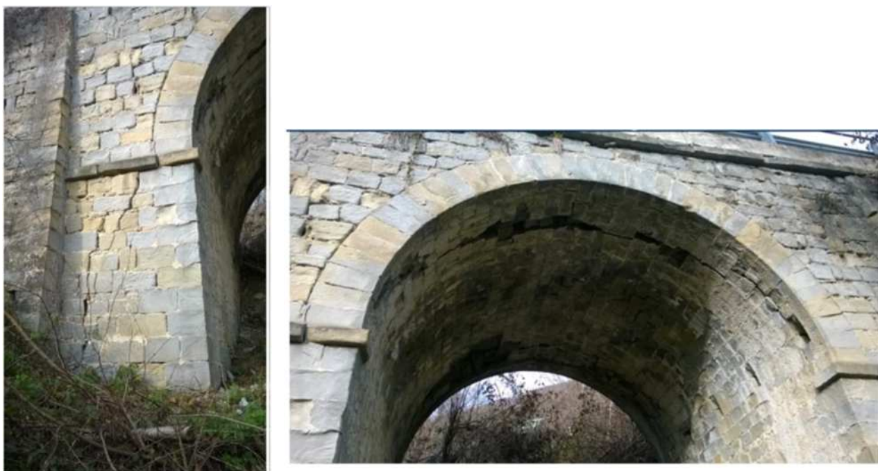
Figura 79 Ponte sulla Sp129 Km 0+900
