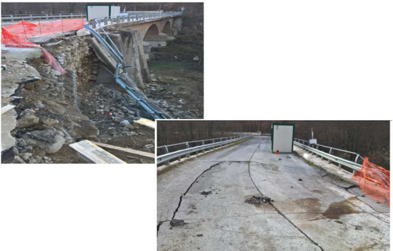
Figura 77 Ponte Tre Occhi - SR 260
