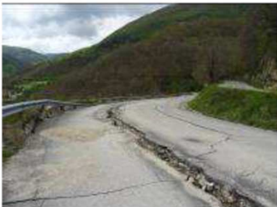
Figura 81 Dissesti corpo stradale SP129
