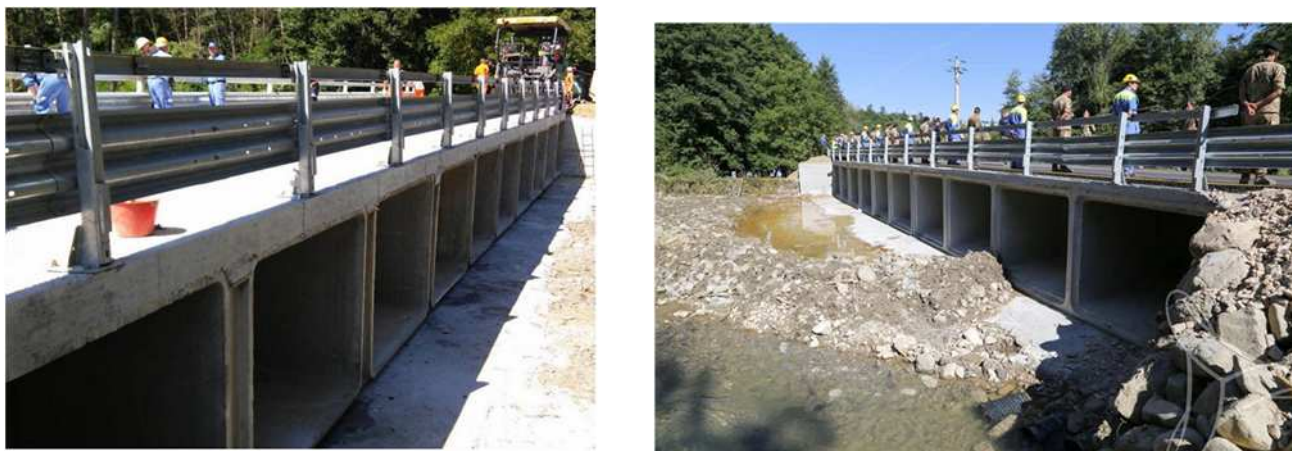
Figura 78 Ponte Tre Occhi - SR 260 Picente realizzazione by-pass provvisorio per ripristino viabilità
