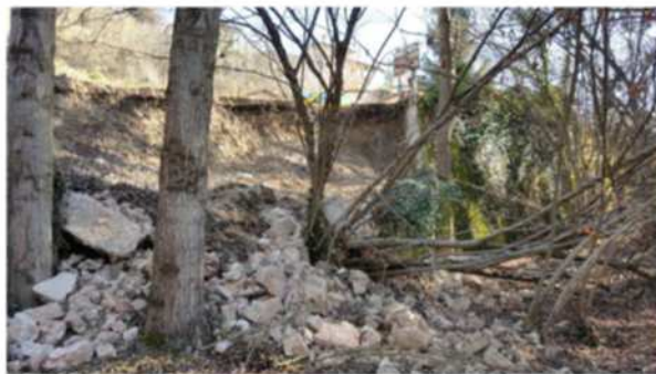
Figura 82 Dissesto muro di sostegno SP476
