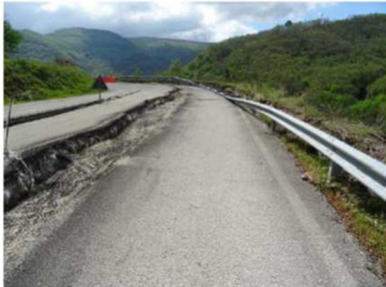
Figura 81 Dissesti corpo stradale SP129
