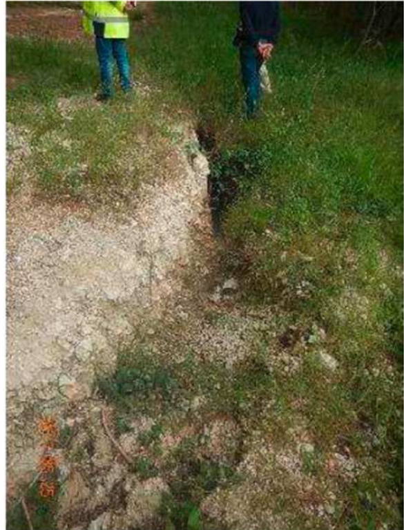
Figura 75 Lesioni sul terreno in prossimità di alcune fondazioni
