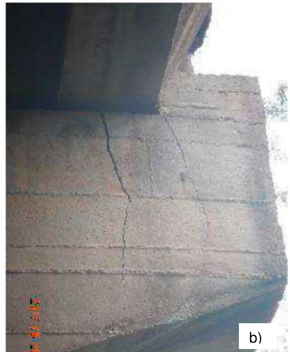
Figura 74 a) schiacciamento dei giunti di dilatazione con rottura del muro paraghiaia sulla spalla b) fessure sul pulvino in corrispondenza del ritegno sismico laterale
