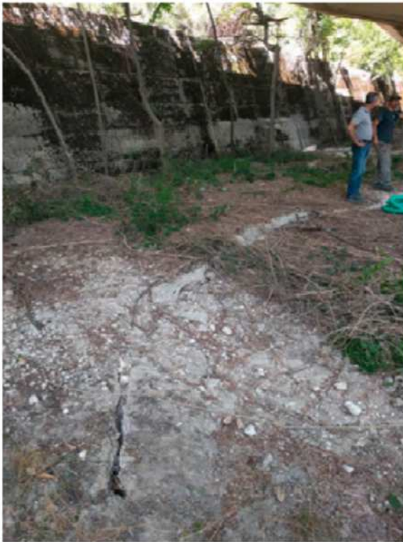
Figura 75 Lesioni sul terreno in prossimità di alcune fondazioni
