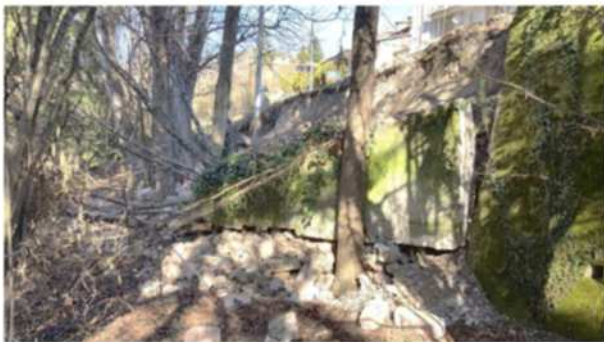
Figura 82 Dissesto muro di sostegno SP476
