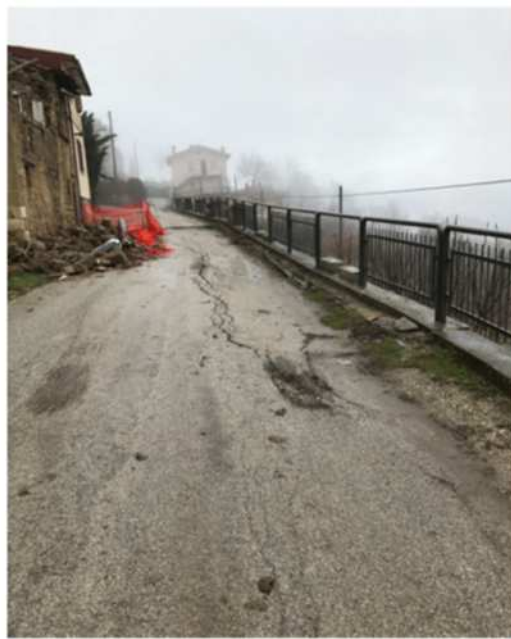
Figura 83 Danneggiamento muro di sostegno in CA sulla strada comunale Olibra
