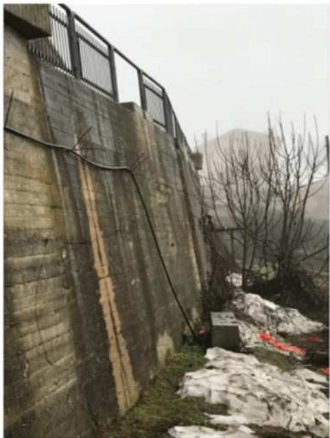
Figura 83 Danneggiamento muro di sostegno in CA sulla strada comunale Olibra
