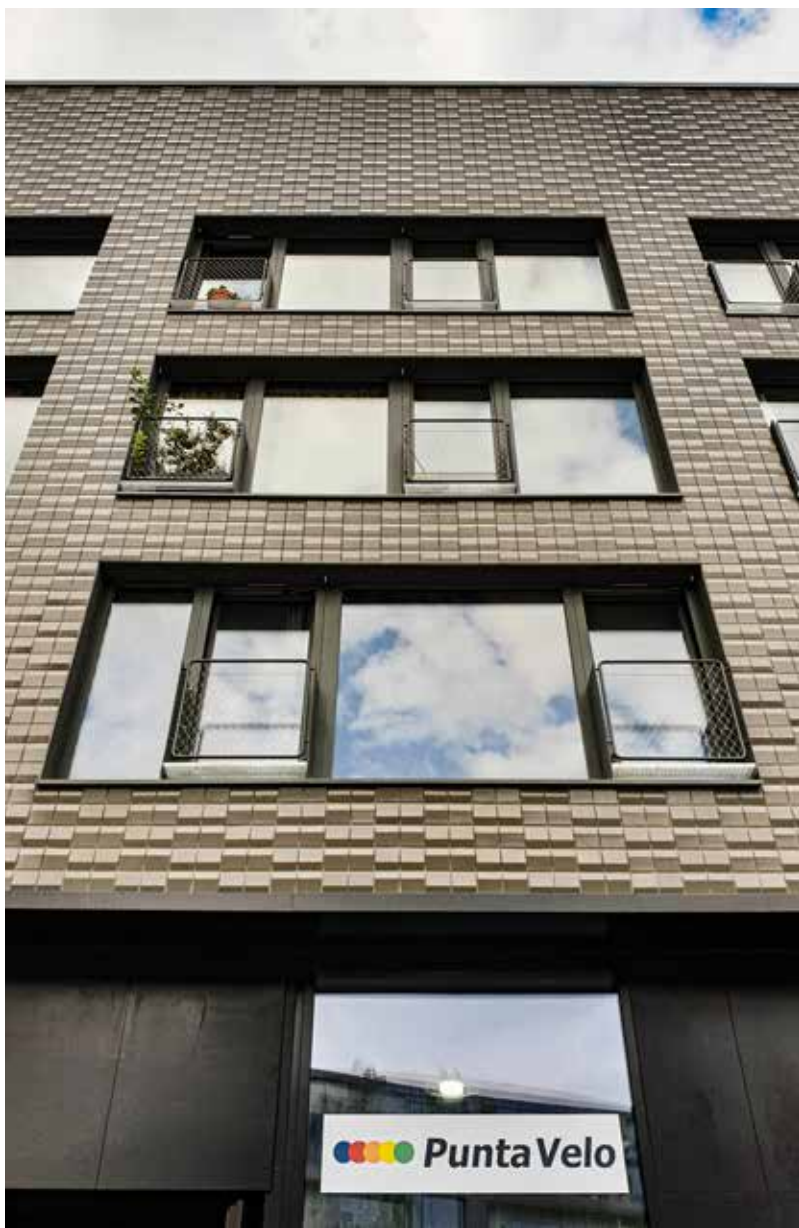
Fig. 12. Vista dell'area comune in copertura
