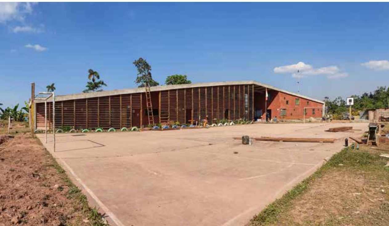
Fig. 18. Il prospetto della scuola che affaccia sul cortile
