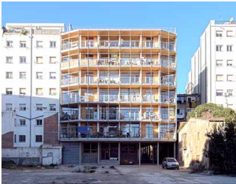
Fig. 5. Il prospetto verso l'interno dell'isolato Foto: Lacol
