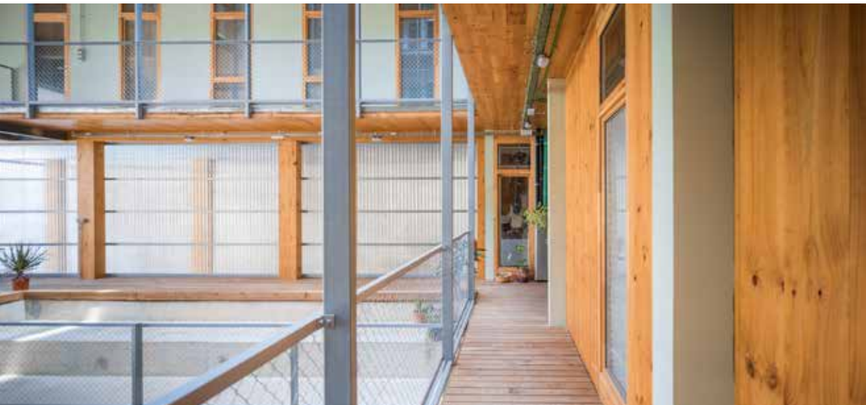
Fig. 7. Vista del primo livello dei ballatoi Foto: Lluc Miralles
