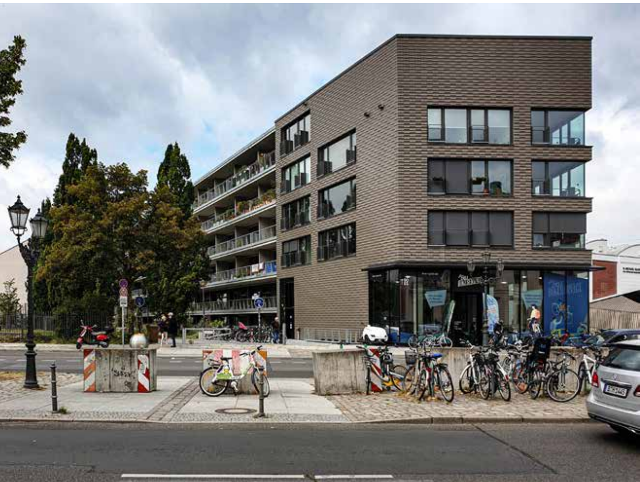
Fig. 9. Vista dell'edificio dalla strada
