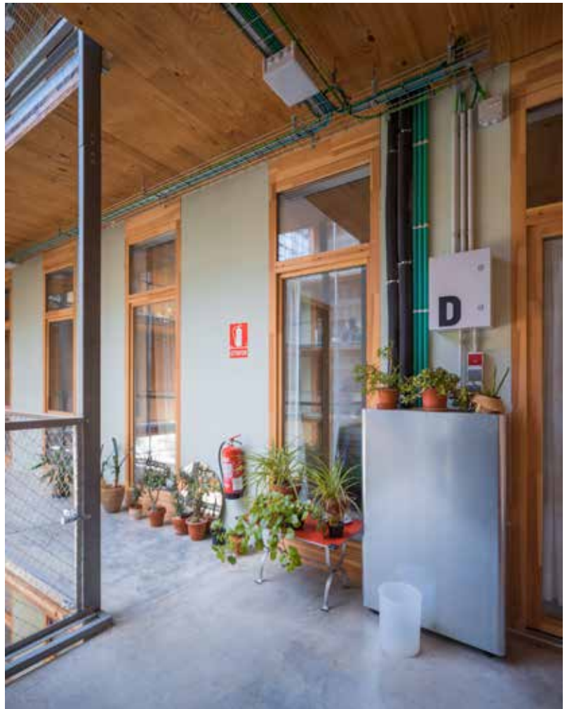
Fig. 4. Vista di un ballatoio. Foto: Lluç Miralles
