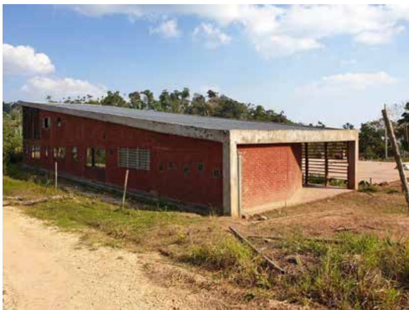
Fig. 20. Il lato della scuola che affaccia su strada
