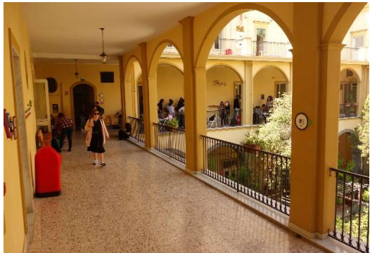
Foto 4 Ballatorio primo piano cortile nord
