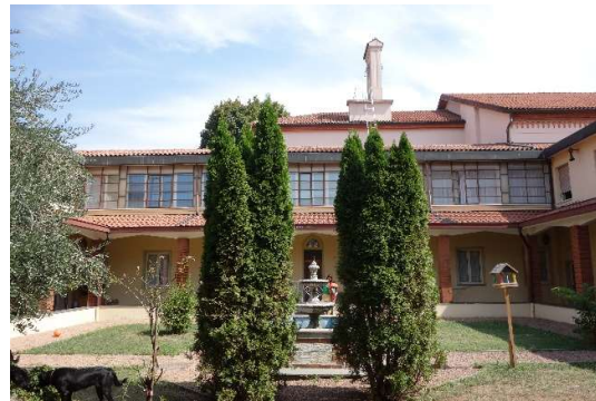
Foto 1 Il chiostro interno
