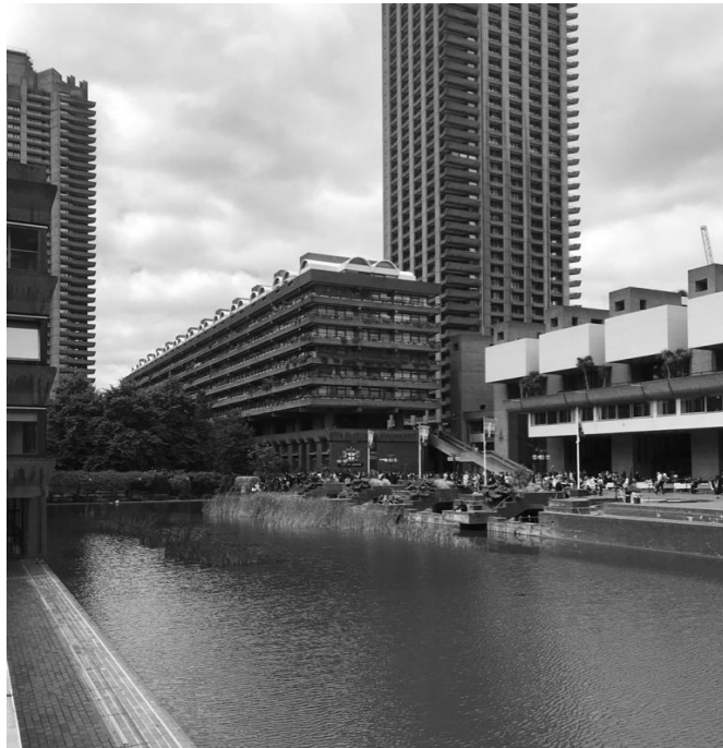
4.7 Vista d'insieme del laghetto, degli spazi esterni, del centro culturale e delle parti residenziali
