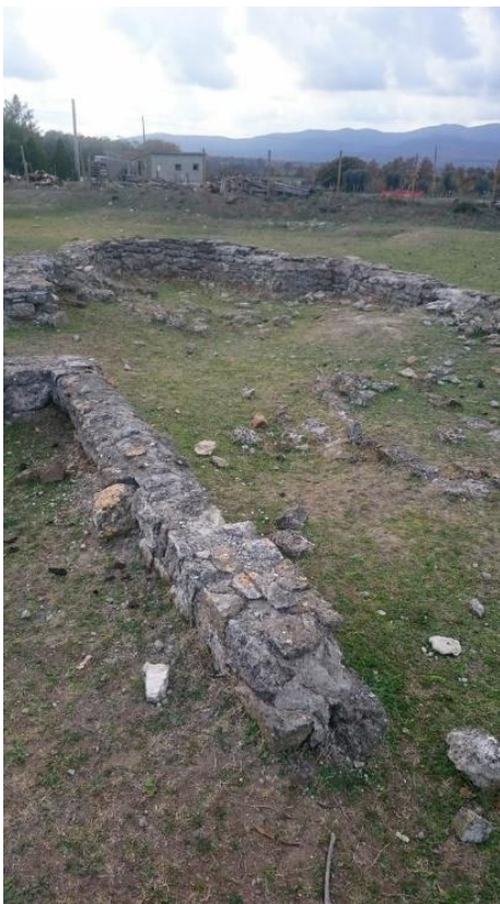
Foto della chiesa in direzione Sud-Ovest. Dalla foto è possibile apprezzare la tipologia della struttura muraria.
