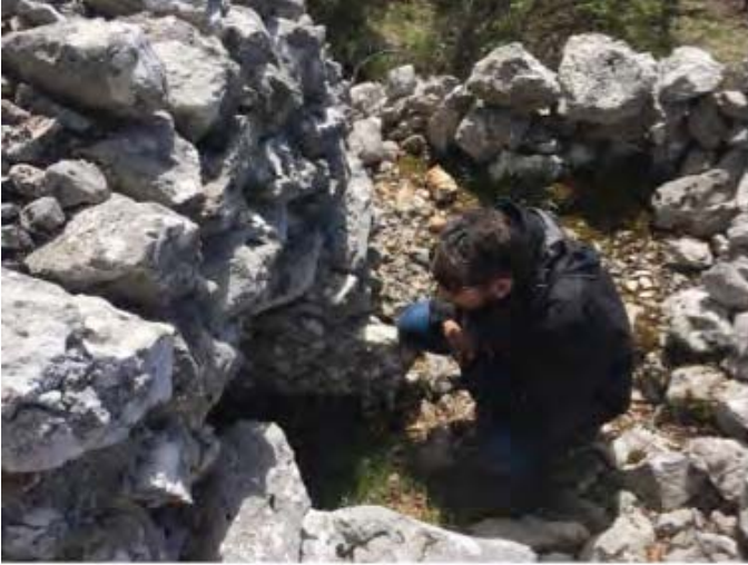
Fig.12 Ingresso ad una delle capanna in pietra
