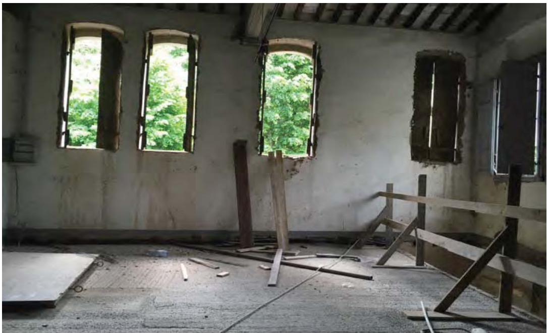
Fig. 4 Edificio del nuovo museo in restauro – ex-Cartiera le Carte interno
