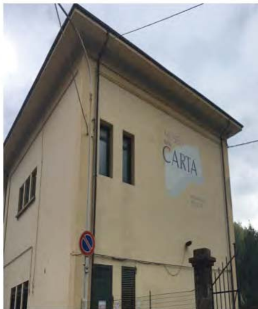
Fig. 2 Edificio dell'attuale museo/centro di documentazione
