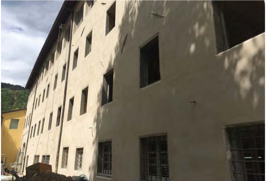
Fig. 3 Edificio del nuovo museo in restauro – ex-Cartiera le Carte esterno
