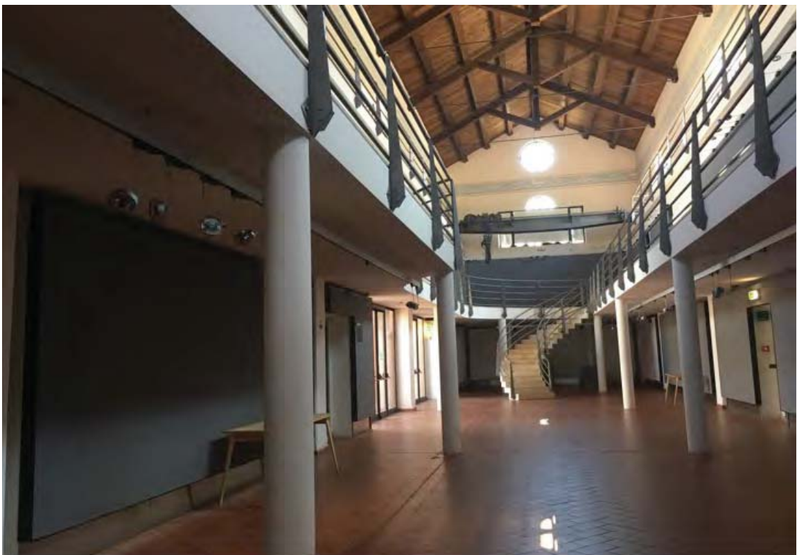
Fig. 16 Spazio espositivo per mostre temporanee a piano terra – carroponete e struttura architettonica originaria dell'ex opificio
