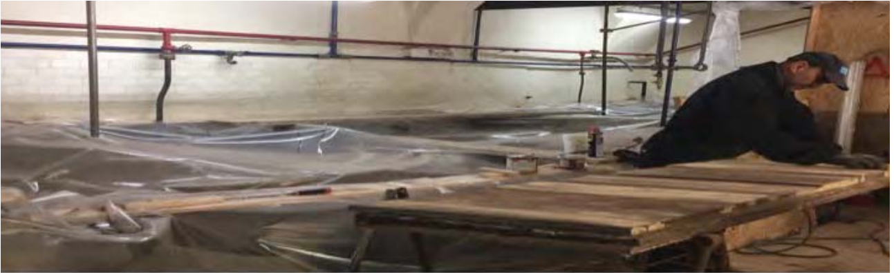
Fig. 14 Lavori in corso nell'edificio ex Cartiera le Carte in restauro
