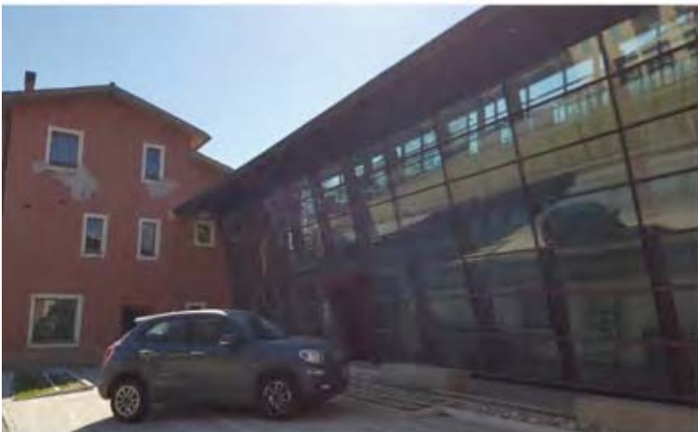
Fig. 2 Vista del museo dall'esterno – una delle "Casermette" e il nuovo edificio
