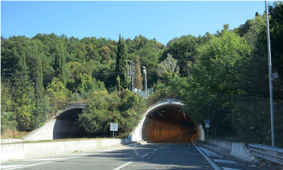
Figura 31 - Strada Statale 4 Via Salaria - galleria Colle Giardino, nel comune di Rieti - imbocco nord della canna in direzione sud (Roma)
