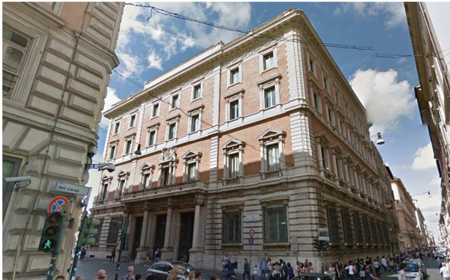
FIGURE 1. View of the corner of the Ex Banco di Napoli building between Via del Corso and Via del Parlamento.
