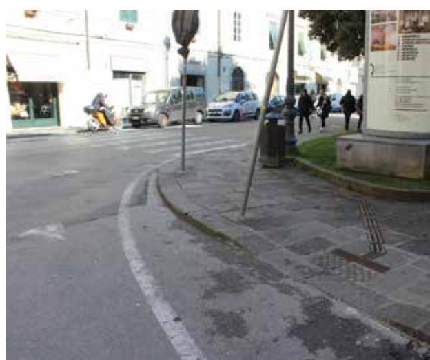
Fig. 381 Dettaglio di uno scivolo in prossimità di un attraversamento pedonale dotato di sistema LOGES
