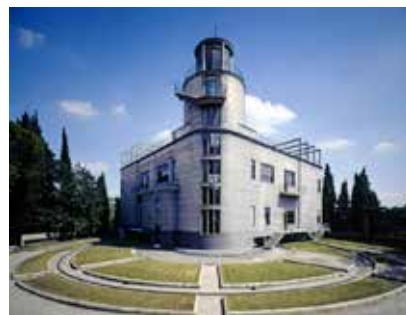
Fig. 269-270 La Villa Girasole, in provincia di Verona di Carlo Invernizzi, ripropone il concetto di Machine à habiter teorizzato da Le Corbusier: la struttura è dotata di un motore che innesci il meccanismo dei carrelli di sostegno che le permettono di ruotare su se stessa.
