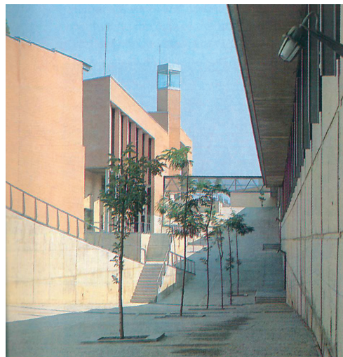
5.89 Foto dell'asse di connessione principale
