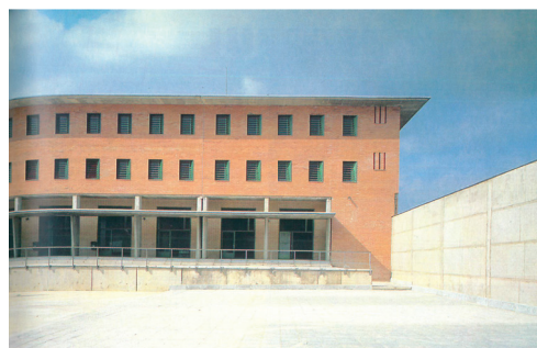
5.90 Foto della corte interna alla sezione detentiva
