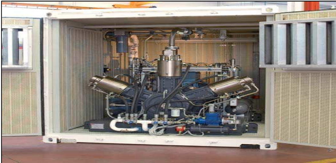
Figura 8.146: Un compressore per una stazione di rifornimento di gas metano per il deposito di un operatore TPL
