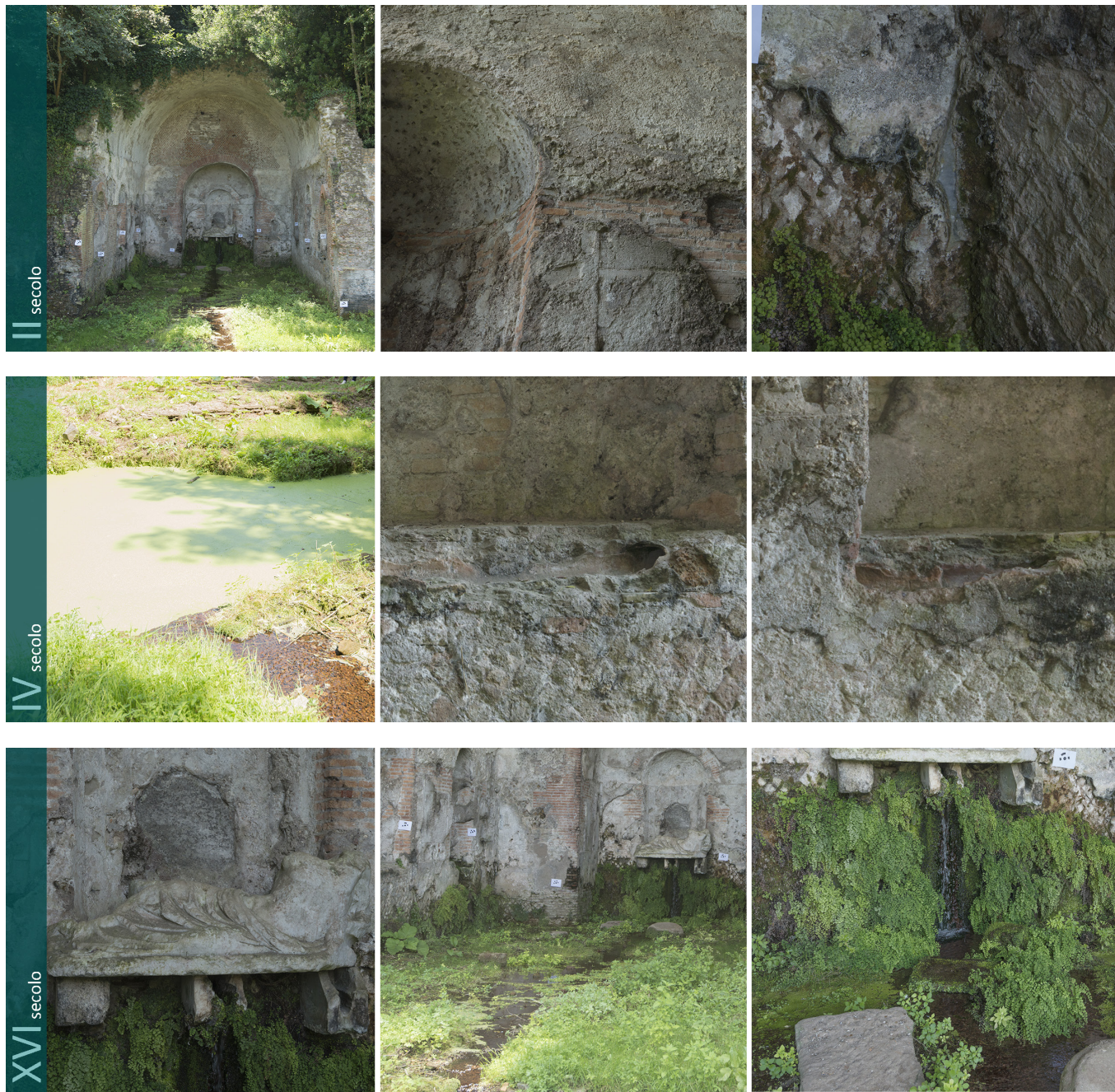
Fig. 4.16 Le fasi costruttive del ninfeo. II secolo (in alto): impianto costruttivo e dettagli delle tracce di rivestimento marmoreo. IV secolo (al centro): vasca centrale e sistema di canalizzazione delle acque. XVI secolo (in basso): statuaria e canale d'acqua centrale
