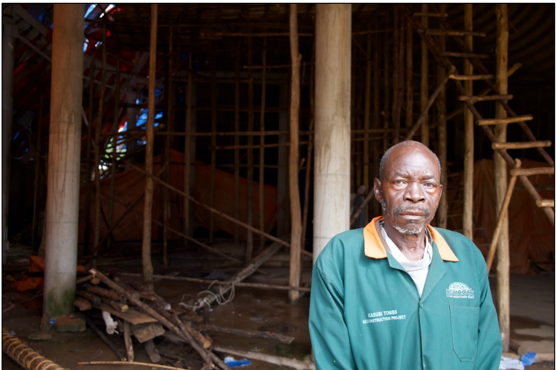
Figura 20. Christopher Kawoya, del clan Ngeye , supervisiona i lavori di Kasubi.
