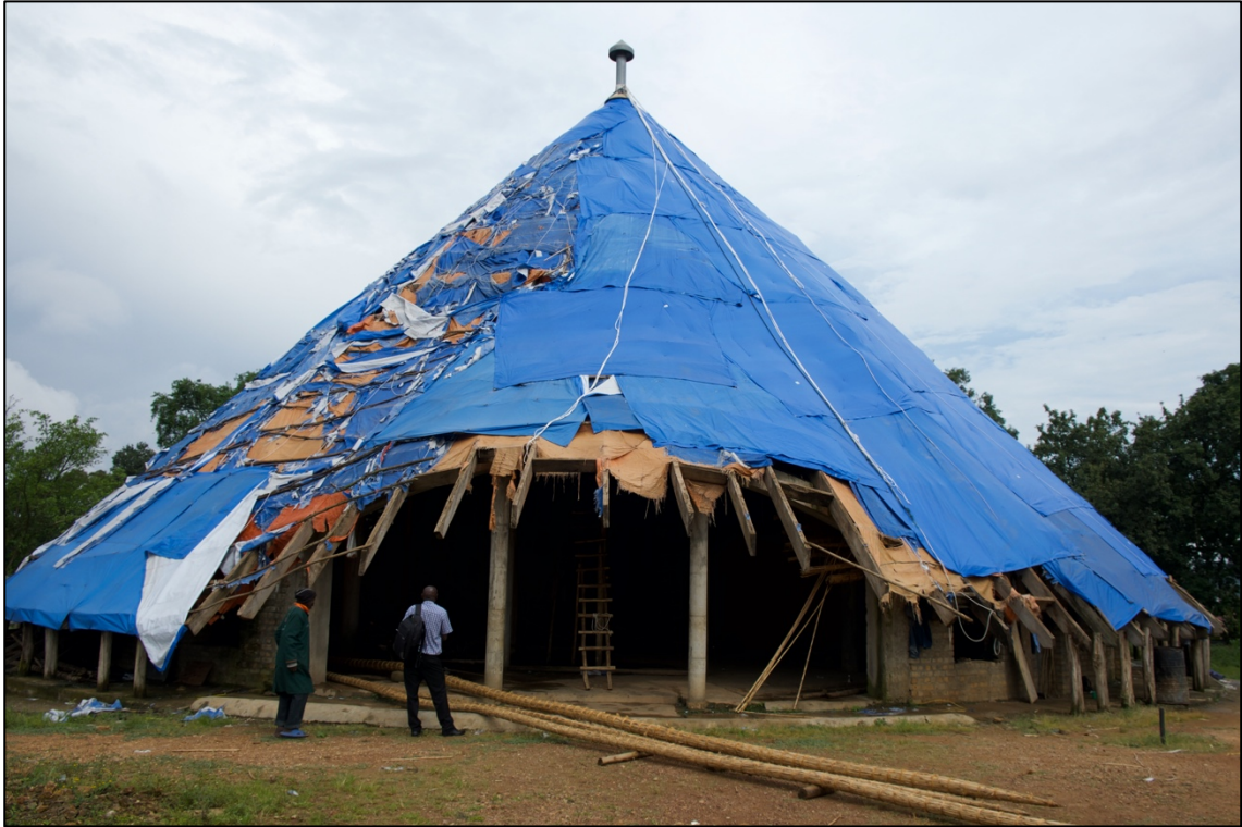
Figura 15. Stato dei lavori del Muzibu-Azaala-Mpanga, giugno 2018 (foto dell'autore).
