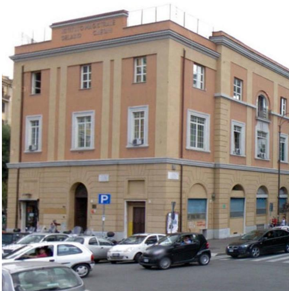
Foto 25. El edificio sede principal del liceo Caetani.
