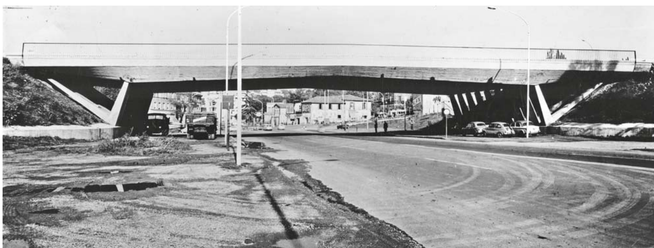
Fig. 4. Cavalcavia della via del foro Italico su Corso Francia (1958-1960), Roma. Progetto di Riccardo Morandi. (Foto fondo R. Morandi, Archivio centrale dello Stato, Roma).
