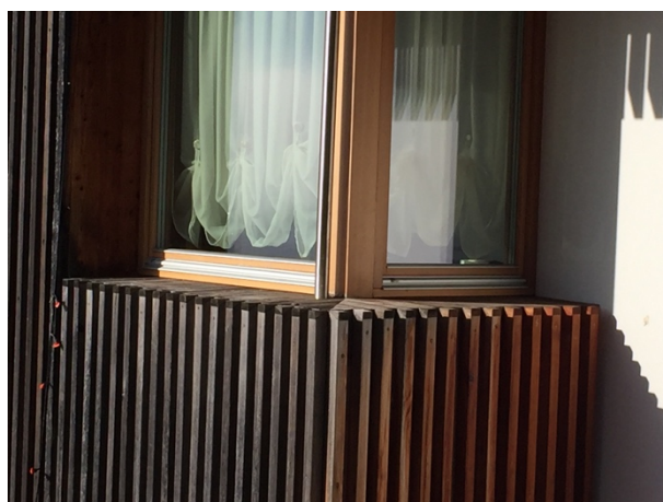
Immagine 40(sinistra) Dettaglio dell'imbotte della porta finestra di terra, leggermente rialzato rispetto al terreno e con la possibilità di far defluire l'acqua ed asciugare il legno
