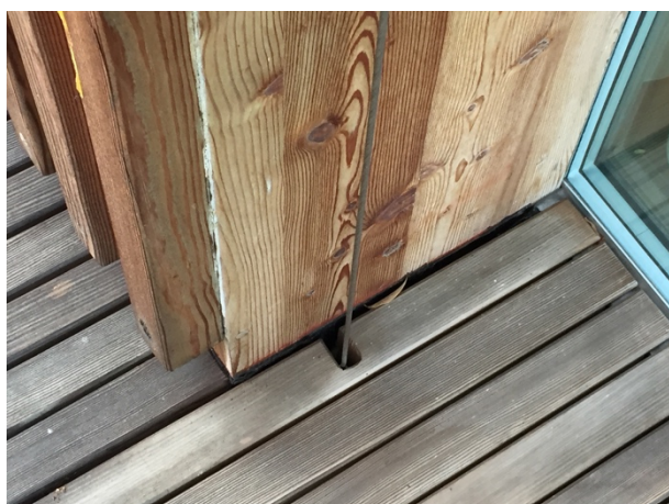
Immagine 40(sinistra) Dettaglio dell'imbotte della porta finestra di terra, leggermente rialzato rispetto al terreno e con la possibilità di far defluire l'acqua ed asciugare il legno
