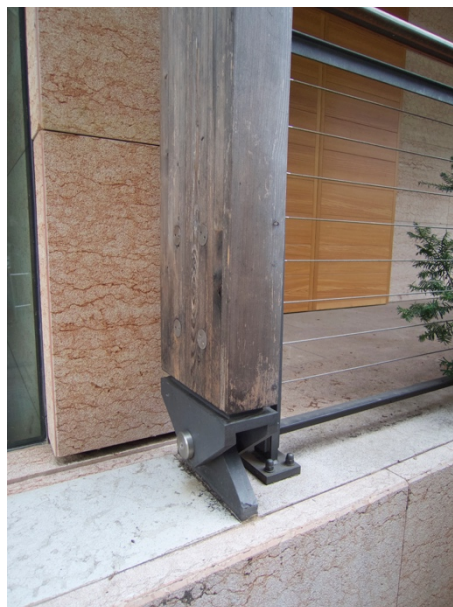
Immagine 96 (sinistra) I nodi a terra dei montanti verticali sono pensati con delle cerniere al piede e la superficie di contatto tra i due oggetti è ventilata, permettendo la naturale asciugatura del legno Immagine 97 (destra) I nodi a terra dei montanti verticali sono pensati con delle cerniere al piede e la superficie di contatto tra i due oggetti è ventilata, permettendo la naturale asciugatura del legno
