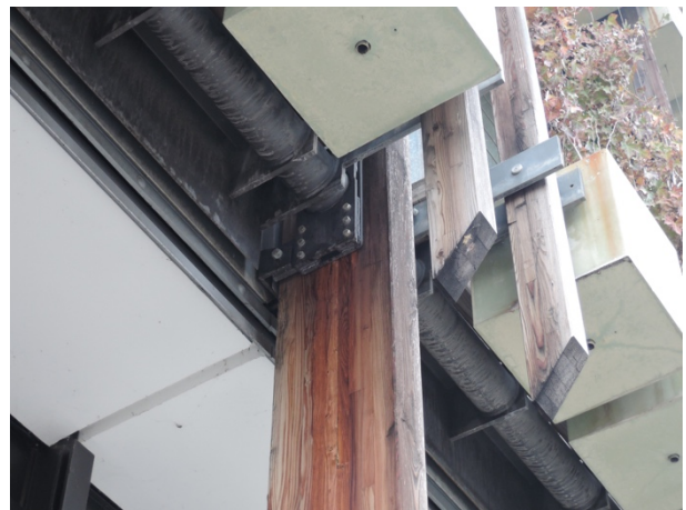
Figura 125 (sinistra) Dettaglio del nodo del davanzale con i componenti verticali che sono incastrati per impedire che la testa del listello sia esposta alle intemperie
