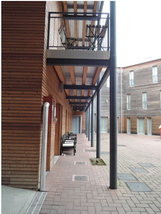
Immagine 15 (sinistra) Dettaglio dell'intradosso delle pensiline in acciaio e legno che non risultano avere alcuna problematica di degrado
