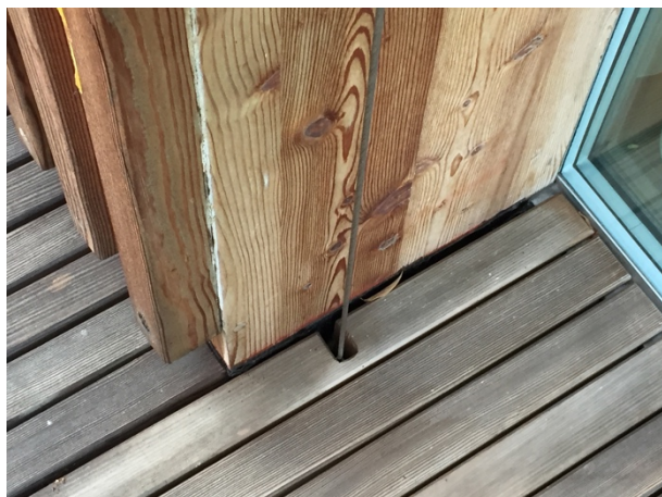
Figura 129 (sinistra) Rivestimento esterna rialzato rispetto alla pavimentazione. Anche la pavimentazione è rialzata rispetto allo scorrimento delle acque, assicurando così la giusta distanza rispetto a eventuali masse d'acqua ristagnanti.
