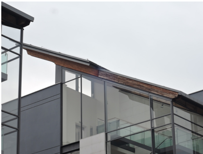
Figura 119 Trave di copertura superiore a sostegno dei pannelli solari.
