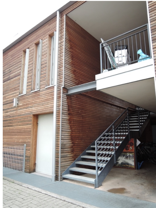
Immagine 15 (sinistra) Dettaglio dell'intradosso delle pensiline in acciaio e legno che non risultano avere alcuna problematica di degrado
