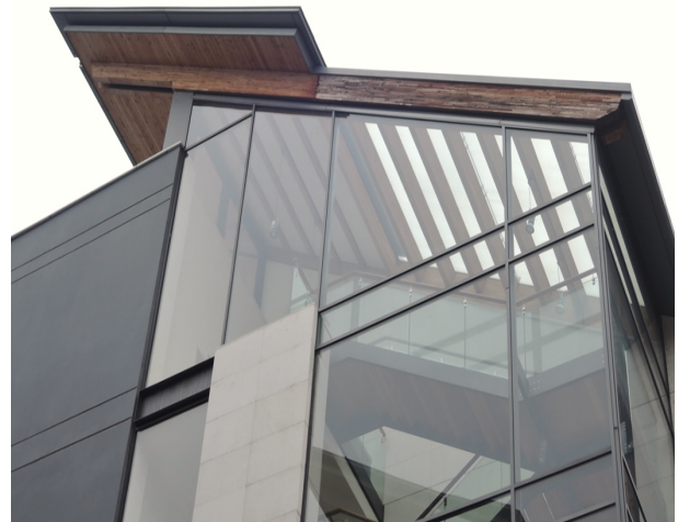
Figura 133 (sinistra) Raccordo tra due tipologie di copertura. L'elemento inclinato non indirizza correttamente le acque sulla copertura, che colano lungo il rivestimento
