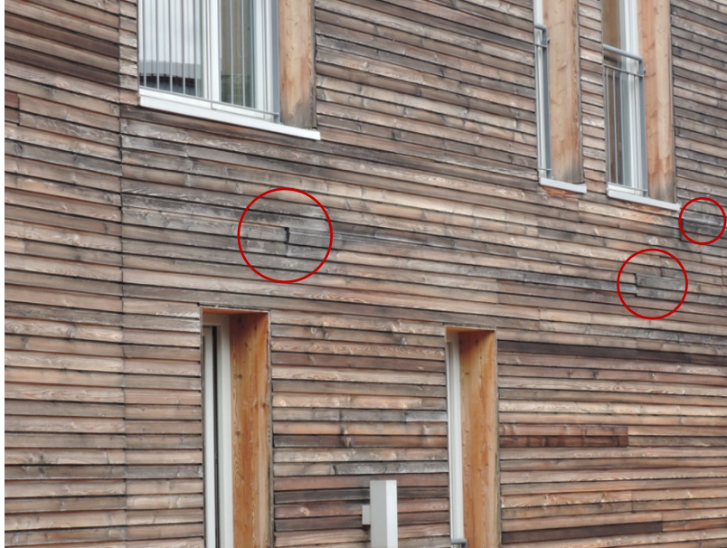
Figura 110 Rivestimento esterno del caso studio 3
