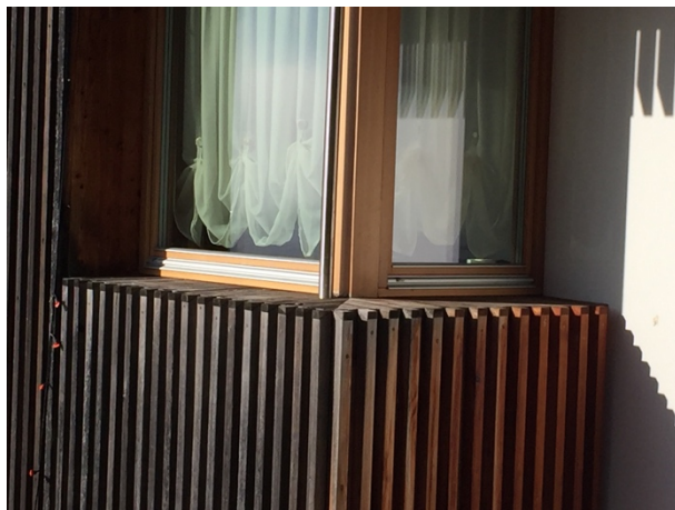
Figura 125 (sinistra) Dettaglio del nodo del davanzale con i componenti verticali che sono incastrati per impedire che la testa del listello sia esposta alle intemperie
