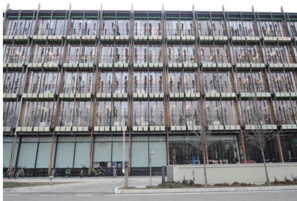
Immagine 92 (sinistra) Facciata con componenti esterni in legno. Non si rilevano particolari avarie di componenti Immagine 93 (destra) Noto di dettaglio di aggancio pareti esterne in acciaio – montanti verticali in legno. Non si rilevano problemi di dilavamento dei componenti in acciaio, che sono correttamente arretrati rispetto al filo dei montanti.
