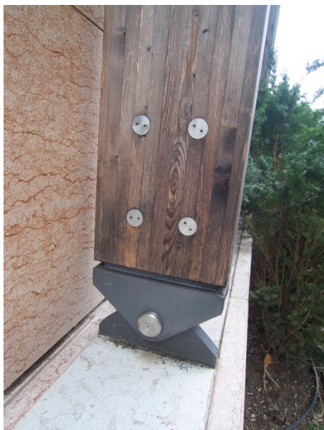
Immagine 96 (sinistra) I nodi a terra dei montanti verticali sono pensati con delle cerniere al piede e la superficie di contatto tra i due oggetti è ventilata, permettendo la naturale asciugatura del legno Immagine 97 (destra) I nodi a terra dei montanti verticali sono pensati con delle cerniere al piede e la superficie di contatto tra i due oggetti è ventilata, permettendo la naturale asciugatura del legno
