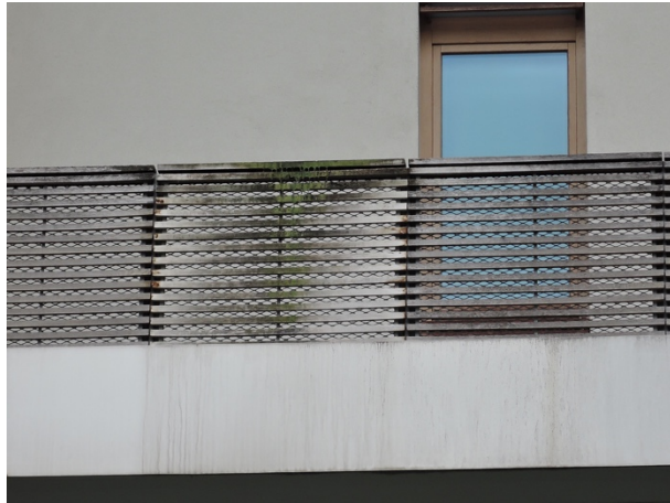
Figura 139 (sinistra) Componente di protezione della facciata ventilata correttamente progettato Figura 140 (destra) Componenti di parapetto in evidente degrado.
