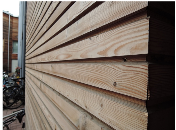
Figura 141 (sinistra) Facciata con rivestimento in doghe di larice maschiato e incollato. Alcuni componenti hanno perso la planarità originale e questo potrebbe essere un punto di degrado futuro. Figura 142 (destra) Dettaglio del rivestimento esterno e dei fissaggi.
