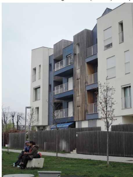
Immagine 104 (sinistra) Dettaglio di uno dei prospetti interni con diverso invecchiamento superficiale, senza alcuna conseguenza in termini di durabilità
