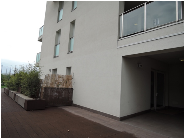
Immagine 54 (sinistra) La non corretta posa in opera di rompigoccia dei punti di contatto balconi-parete, comporta infiltrazioni d'acqua nel rivestimento esterno e quindi problemi legati al deterioramento dello stesso. Il pannello isolante posteriore non desta preoccupazioni essendo in materiale plastico.
