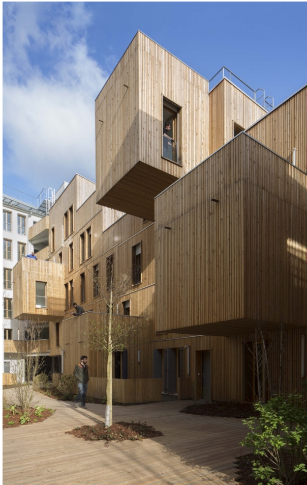
Immagine 47 Prospetto verso la corte interna
