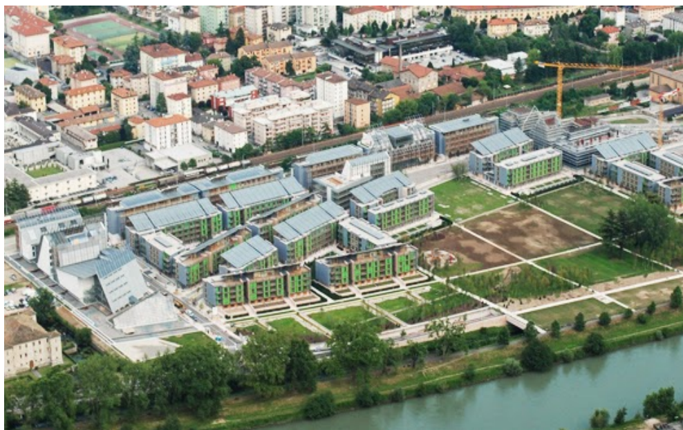
Immagine 88 Vista dall'alto dell'interno quartiere
