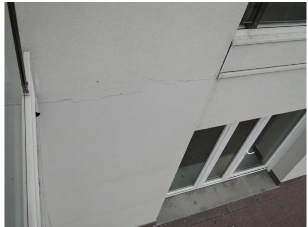
Immagine 54 (sinistra) La non corretta posa in opera di rompigoccia dei punti di contatto balconi-parete, comporta infiltrazioni d'acqua nel rivestimento esterno e quindi problemi legati al deterioramento dello stesso. Il pannello isolante posteriore non desta preoccupazioni essendo in materiale plastico.
