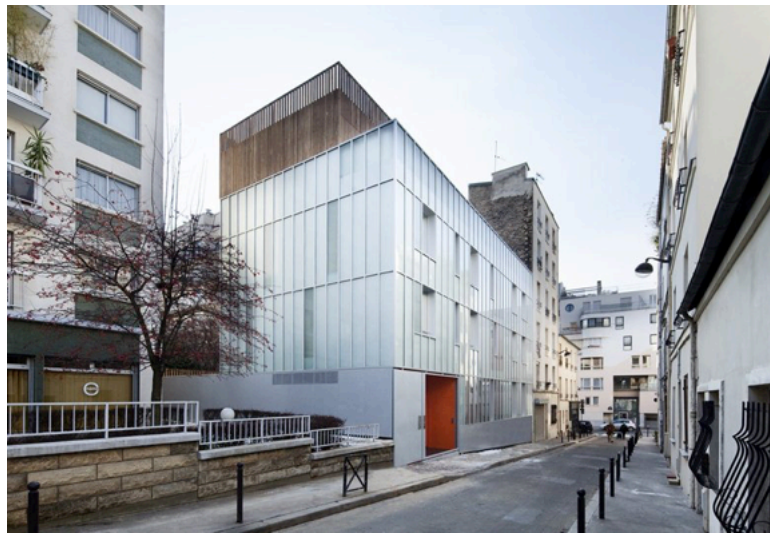
Immagine 86 Prospetto lungo la strada
