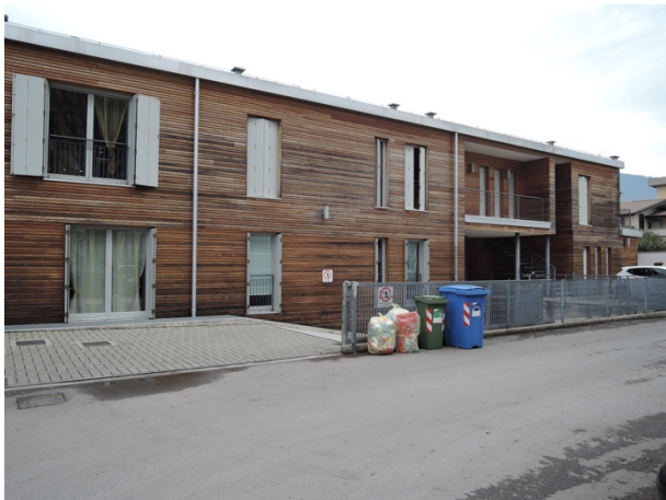
Immagine 21 Prospetto su strada. La facciata non evidenzia particolari problemi né di ingrigimento parziale né di tavole degradate.
