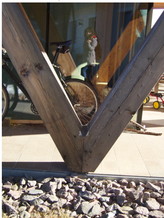
Figura 131 (sinistra) Nodo di collegamento delle travi di sostegno dell'edificio con la fondazione. Correttamente ventilato e nodo a pettine nel legno correttamente distanziato
