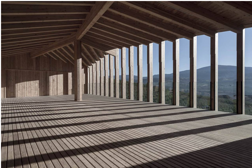
Immagine 26 Terrazza panoramica del primo piano
