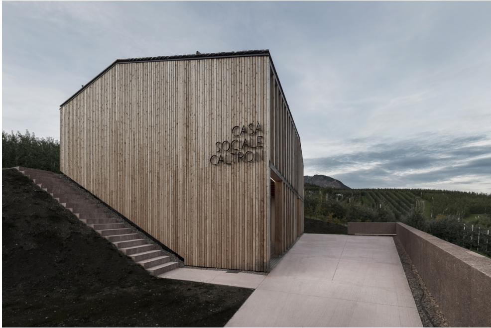
Immagine 25 Fronte principale dell'impianto con rivestimento in doghe verticali
