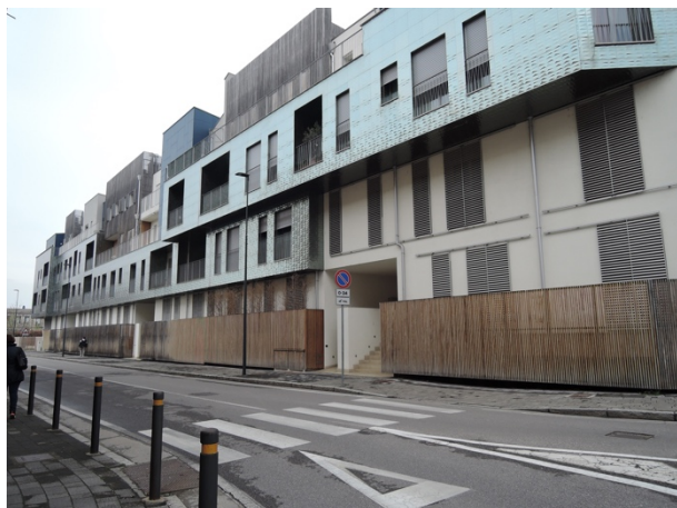
Figura 122 (sinistra) Caso studio localizzato a Brescia. Per la recinzione esterna è stato scelto un listello termo-trattato di Okoumè essenza molto durevole
