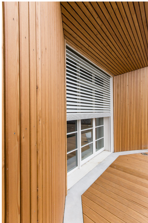
Immagine 31 Dettaglio del rivestimento di facciata
