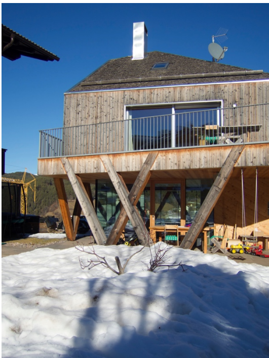
Immagine 71 (sinistra) Gli elementi a protezione del legno dall'acqua di scolo del balcone. Immagine 72 (destra) A coronamento della facciata la scossalina metallica permette una buona protezione della facciata ed evita macchie superiori. Lieve dilavamento intorno alle bucaure delle finestre
