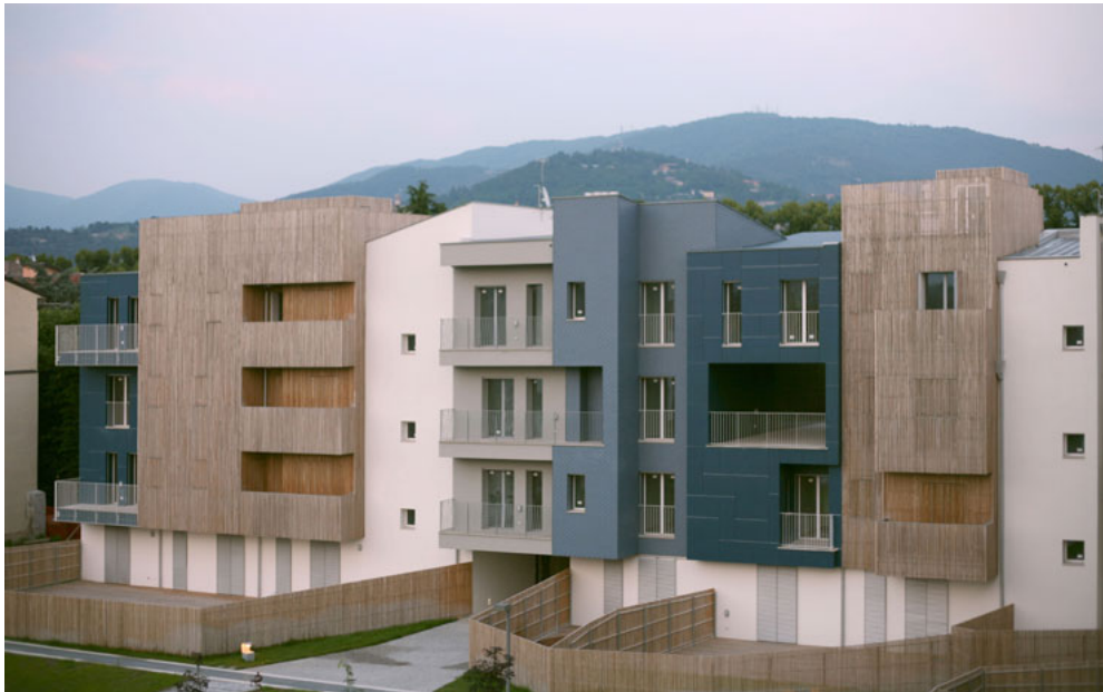
Immagine 100 Fronte della corte interna, con rivestimenti esterni alternati (intonaco-doghe di okoumè=
