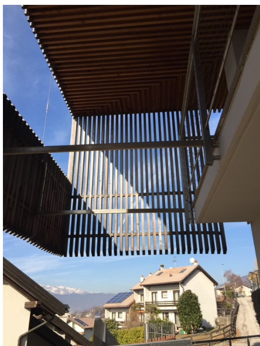
Immagine 42 (sinistra) Listelli verticali 'sospesi' mediante telaio. Non si sono riscontrati fenomeni di instabilità dimensionale o fessurazioni particolari.
