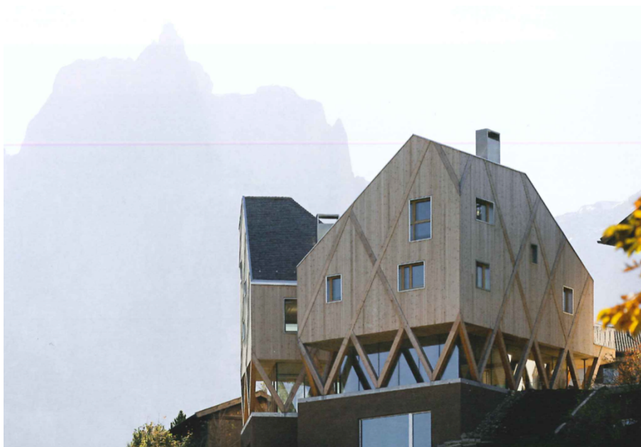
Immagine 67 Prospetto lato verso la vallata
