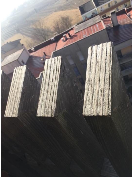
Figura 127 La parte superiore del componente è protetta grazie all'incollaggio di un tassello, dello stesso materiale, incollato con fibratura longitudinale
