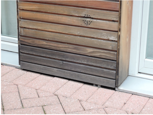
Immagine 17 (sinistra) Foto di dettaglio di attacco a terra correttamente progettato e ventilato.
