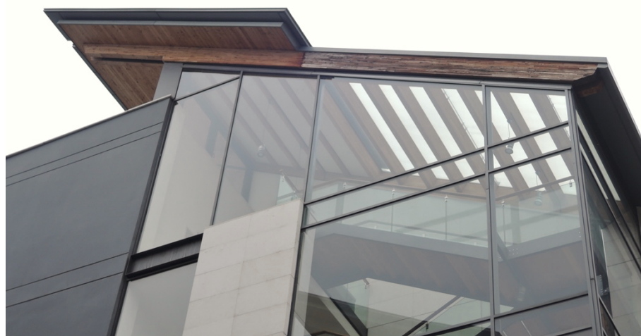
Figura 73 Le albere, Trento. Foto di dettaglio della trave di coronamento in legno lamellare.
