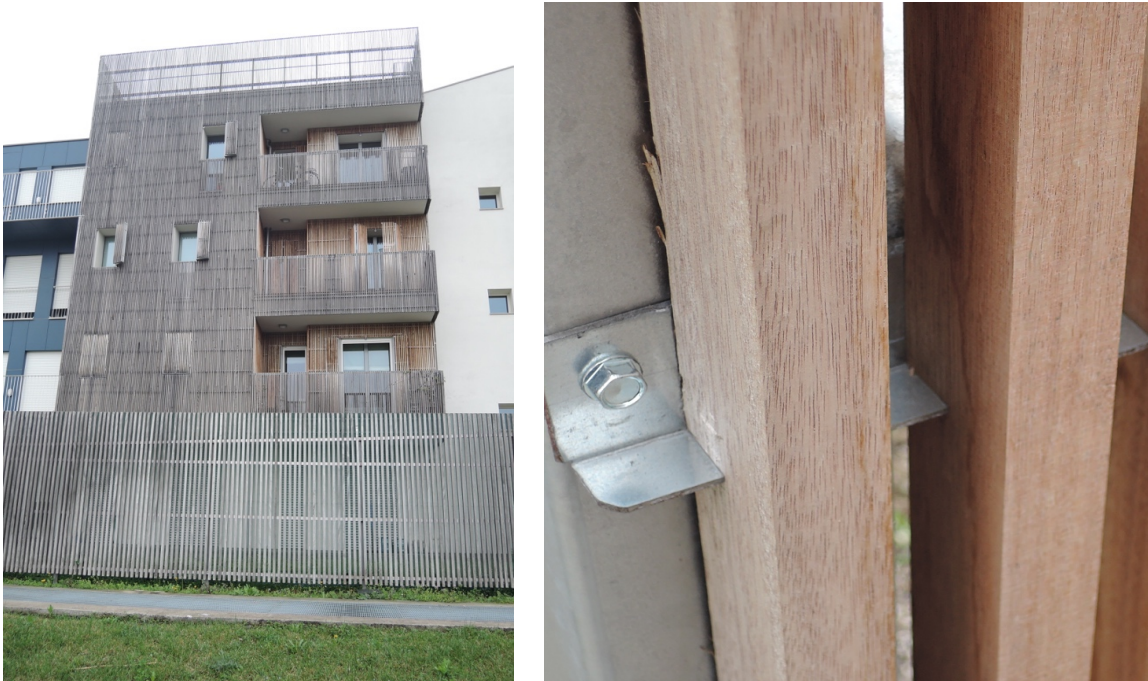
Figura 120 Caso studio numero 14, foto di uno dei prospetti con listelli ad andamento verticale in Okoumé e particolare di un dettaglio di fissaggio.
