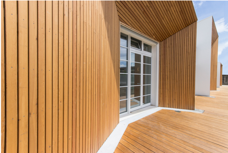
Figura 112 Dettaglio delle strombature di facciata del caso studio 5
