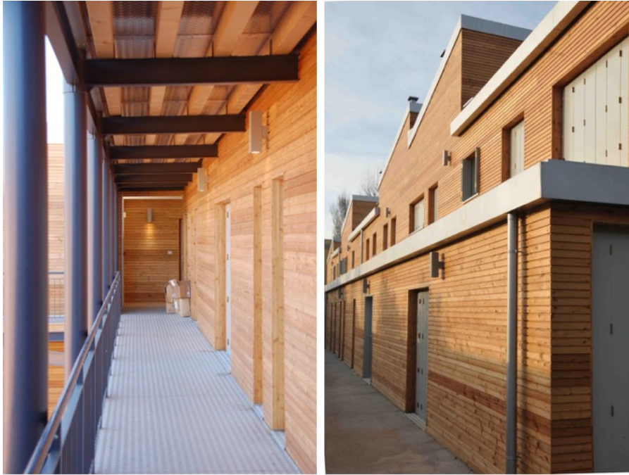
Immagine 10 (sinistra) Ballatoio del primo piano che collega le residenze Immagine 11 (destra) Doghe in larice del prospetto posteriore
