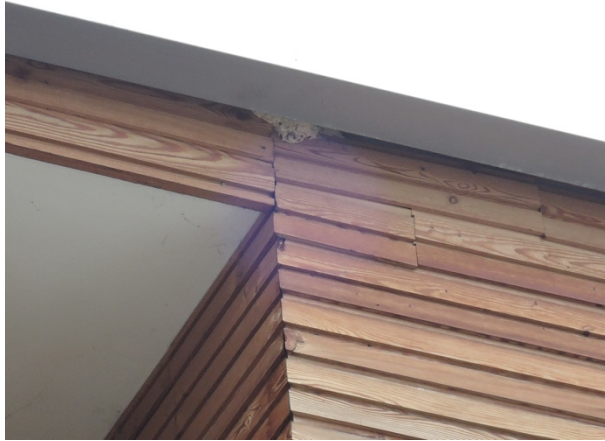
Immagine 23 (sinistra) Dettaglio di facciata con incollaggio delle doghe superiori
