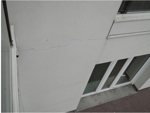
Figura 137 (sinistra) Problemi di fessurazione del rivestimento a causa della cattiva gestione dell'allontanamento delle acque
