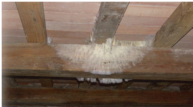
Figura 77 Attacco di funghi cromatogeni su trave in rovere (Zanuttini, 2014)
