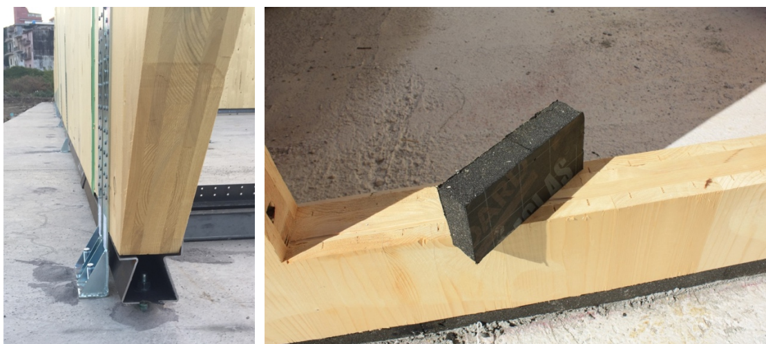
Figura 91 (sinistra) Dispositivo di collegamento pannello Xlam-fondazione in acciaio, cavo, ventilato ed ispezionabile.
