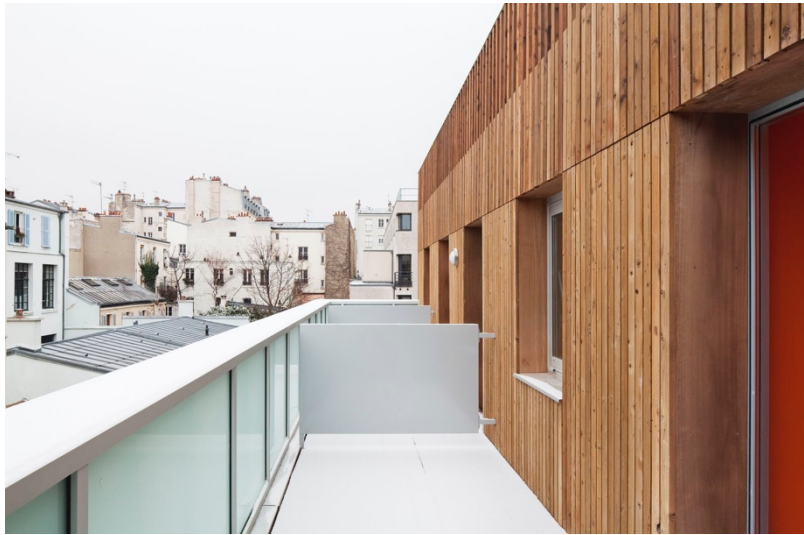
Immagine 85 Fronte interno con rivestimento in doghe di pino
