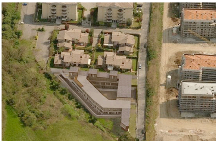
Immagine 9 Foto del nuovo edificio visto dall'alto
