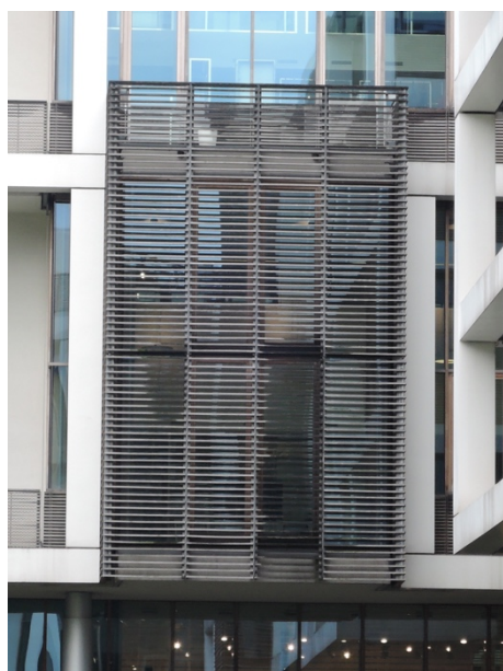
Figura 124 Caso studio Via Tortona 37, Milano. I componenti esterni sono in e nonostante l'assenza di manutenzione non si riscontrano problemi diffusi di degrado.
