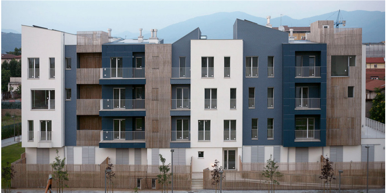
Immagine 99 Fronte della corte interna, con rivestimenti esterni alternati (intonaco-doghe di okoumè=
