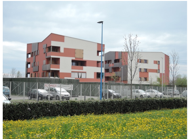
Immagine 61 (sinistra) L'intervento si inserisce in un contesto periferico rispetto alla città e le doghe ad andamento verticale in larice rappresentano un rivestimento esterno parziale verso sud per difendere l'involucro dall'eccessivo soleggiamento
