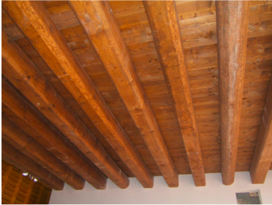
Figura 58 Solaio con travature “Usò Fiume”; ©Rete Usò Fiume ed Usò Trieste
