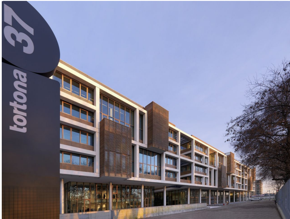
Immagine 109 Fronte lungo strada con schermature di legno
