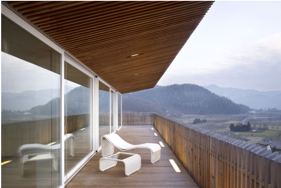
Immagine 34 Rivestimento superiore in listelli di larice
