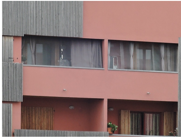
Immagine 65 (destra) Non si evidenziano fessurazioni sull'intonaco né problemi di dilavamento della facciata.
