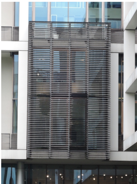
Immagine 114 (sinistra) Box Window interno alla corte. Si rileggono parti di rivestimento esterno con cromature diverse rispetto alle doghe vicine.
