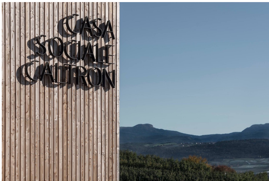
Figura 111 Rivestimento esterno del caso studio 4
