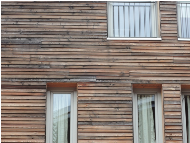
Immagine 19 (sinistra) Dettaglio della parete di involucro. Alcune doghe, a causa della variazione dimensionale data da ciclo caldo-freddo, hanno perso la solidarizzazione con le vicine. Potrebbero prospettarsi problemi di infiltrazione negli strati posteriori e marcescenza locale dell'involucro
