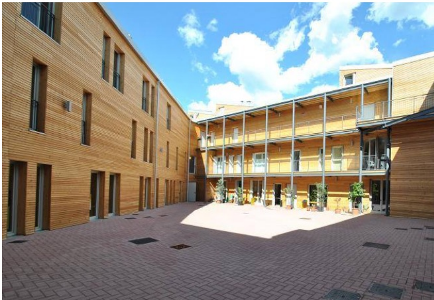
Immagine 12 Corte interna con rivestimento in larice maschiato.
