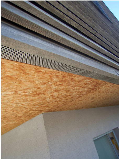
Figura 139 (sinistra) Componente di protezione della facciata ventilata correttamente progettato Figura 140 (destra) Componenti di parapetto in evidente degrado.
