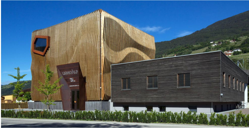
Immagine 75 Fronte lungo la strada provinciale.
