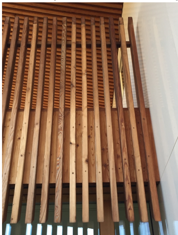
Figura 74 (sinistra) Casa PF. Listelli di larice sotto l'aggetto esterno, protetti, seppure parzialmente, dagli agenti atmosferici esterni
