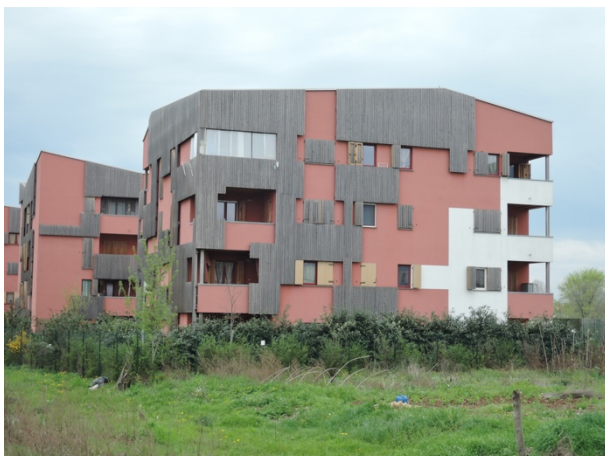
Immagine 63 (sinistra) Le doghe manifestano uno grado di ingrigimento superficiale omogeneo e sono correttamente dimensionate per evitare problematiche di stabilità nel piano. Superiormente la scossalina in acciaio protegge la testa dei listelli da eventuale imbibimento
