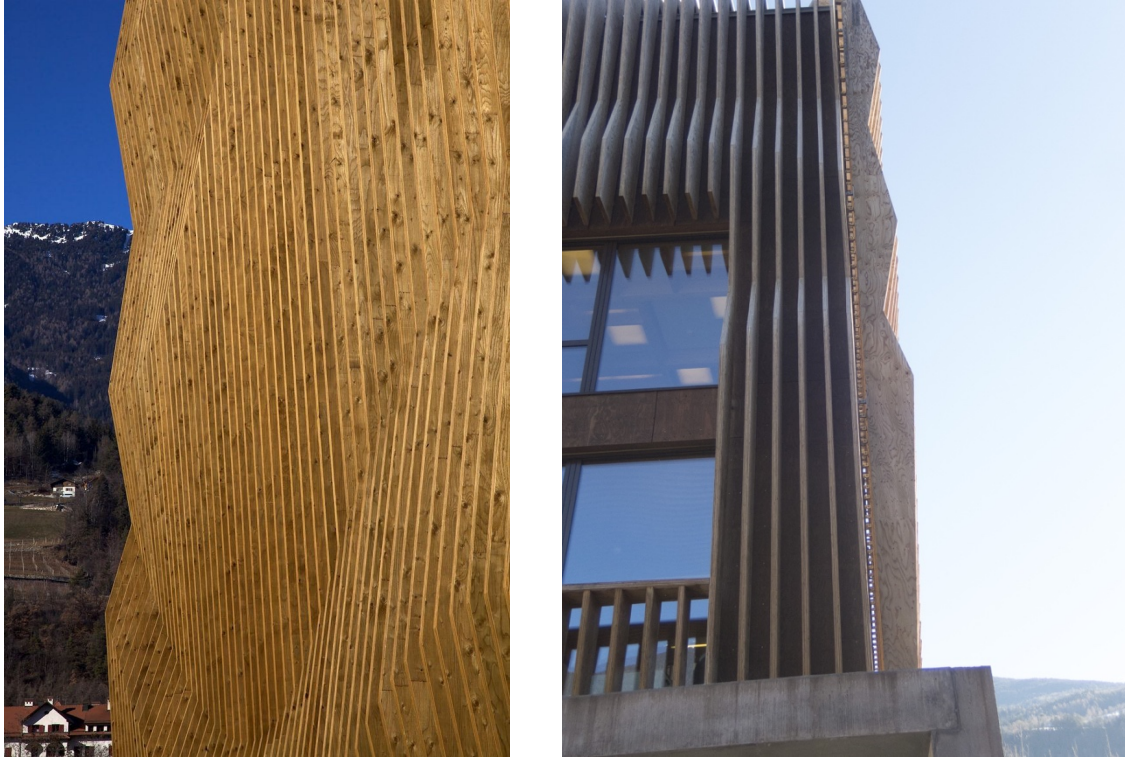
Figura 118 Immagini del caso studio 11, rivestimento esterno in pannelli di Kerto e dettaglio sugli agganci
