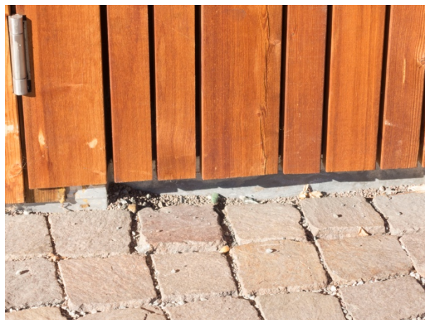
Figura 129 (sinistra) Rivestimento esterna rialzato rispetto alla pavimentazione. Anche la pavimentazione è rialzata rispetto allo scorrimento delle acque, assicurando così la giusta distanza rispetto a eventuali masse d'acqua ristagnanti.
