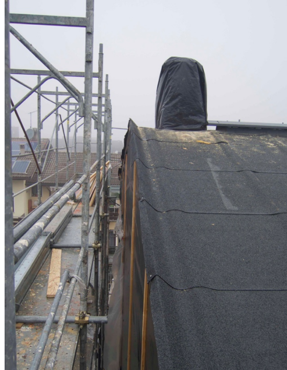
Figura 127 La parte superiore del componente è protetta grazie all'incollaggio di un tassello, dello stesso materiale, incollato con fibratura longitudinale
