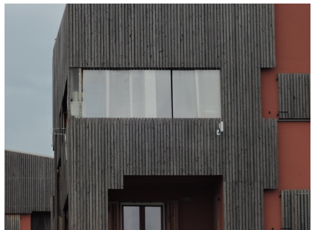
Immagine 63 (sinistra) Le doghe manifestano uno grado di ingrigimento superficiale omogeneo e sono correttamente dimensionate per evitare problematiche di stabilità nel piano. Superiormente la scossalina in acciaio protegge la testa dei listelli da eventuale imbibimento
