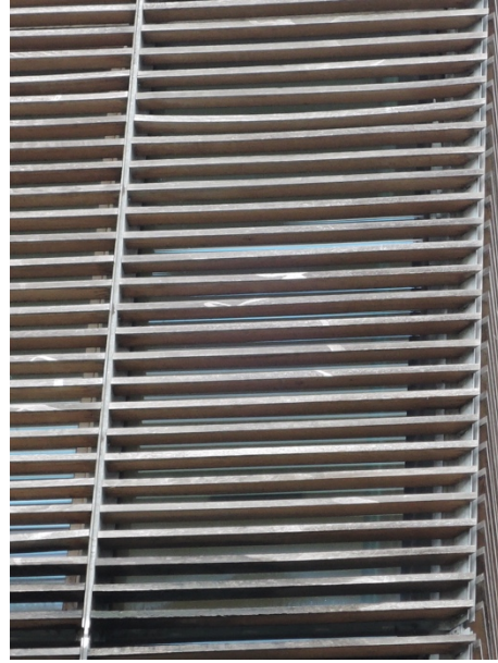
Immagine 116 (sinistra) Rivestimento esterno del bow window con doghe 'imbarcata' Immagine 117 (destra) Dettaglio dell'ombreggiamento con doghe 'imbarcato'.
