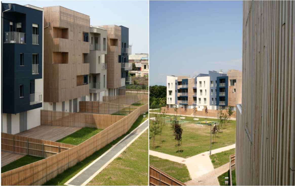
Immagine 101 Fronte della corte interna, con rivestimenti esterni alternati (intonaco-doghe di okoumè=
