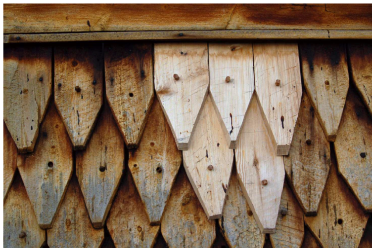
Figura 69 Fenomeno di ingrigimento superficiale, scandole esterne della chiesa di Eidsborg, Norvegia. Progettazione del XIII secolo (Palanti, 2013)
