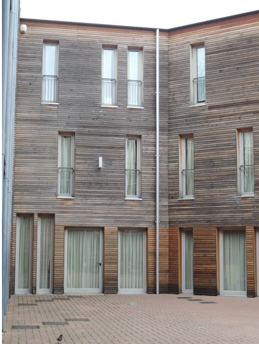
Immagine 13 (sinistra) Foto panoramica della corte interna. Nonostante il trattamento superficiale applicato sulle doghe in larice, l'ingrigimento è evidente e differente a seconda delle porzioni di fabbricato considerate e dell'esposizione alle piogge meteoriche.
