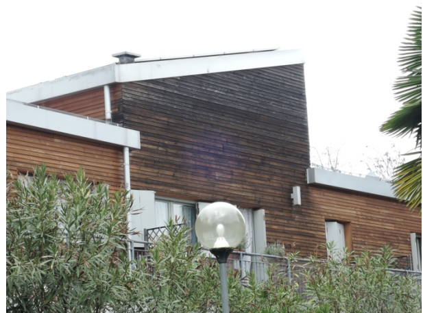
Immagine 21 Prospetto su strada. La facciata non evidenzia particolari problemi né di ingrigimento parziale né di tavole degradate.
