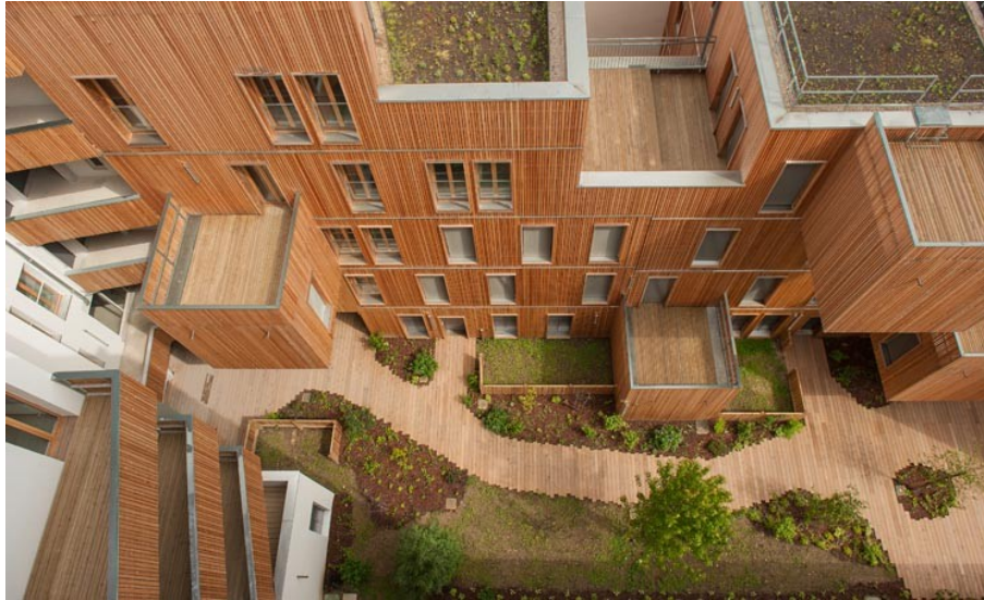
Immagine 45 Prospetto interno con elementi sbalzanti laterali
