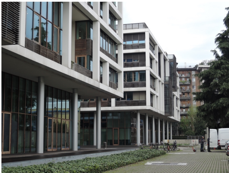
Figura 121 Caso studio 15 e l'alternanza delle tecnologie costruttive in prospetto
