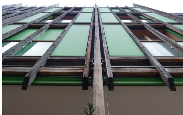
Immagine 94 (sinistra) La testa dei listelli tagliata diagonalmente permette che la faccia del listello non sia stagnante d'acqua e quindi è in un buono stato di conservazione. I balconi in legno non presentano alcun tipo di problematica. Immagine 95 (destra) I componenti verticali risultano di variazione cromatica omogenea e con fessurazioni nella norma.
