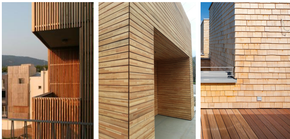
Figura 50 A sinistra livelli in legno ad andamento verticale, al centro doghe di legno ad andamento orizzontale, a destra scandole di legno
