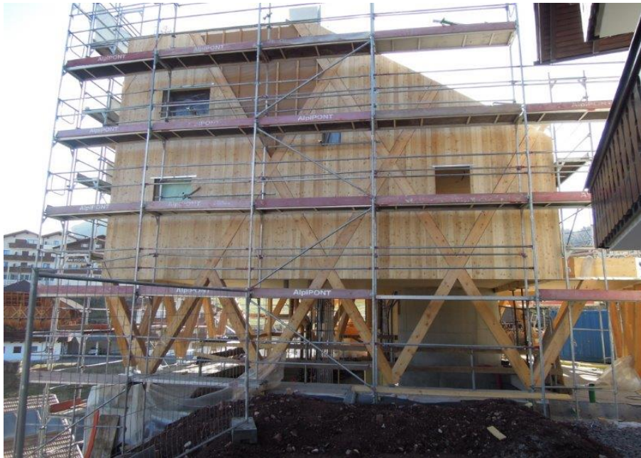
Figura 71 Casa Kostner, foto di cantiere (fornita da Modus Archiect©)
