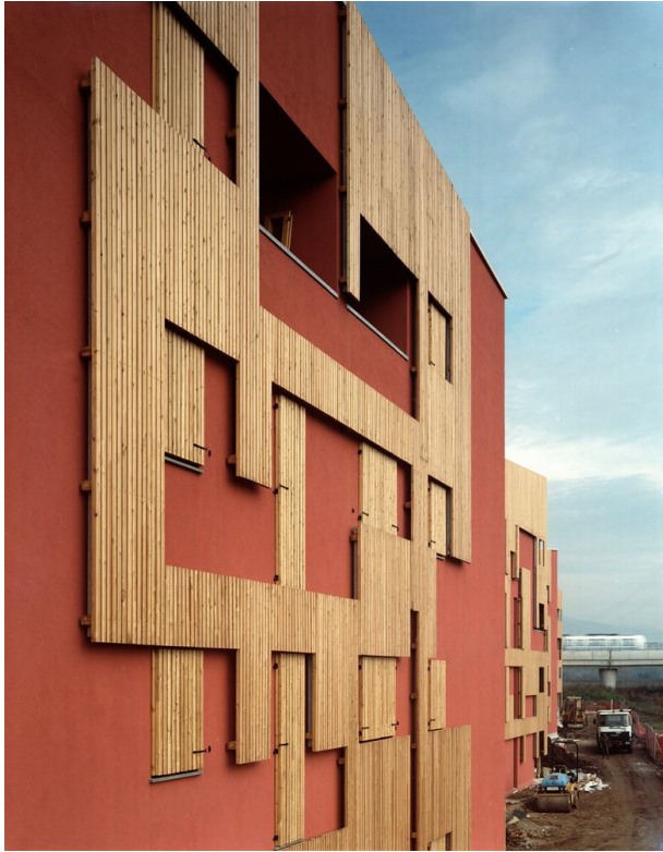
Immagine 59 Rivestimento esterno alternato tra doghe in larice e normale finitura in intonaco
