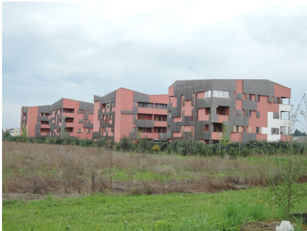
Immagine 61 (sinistra) L'intervento si inserisce in un contesto periferico rispetto alla città e le doghe ad andamento verticale in larice rappresentano un rivestimento esterno parziale verso sud per difendere l'involucro dall'eccessivo soleggiamento
