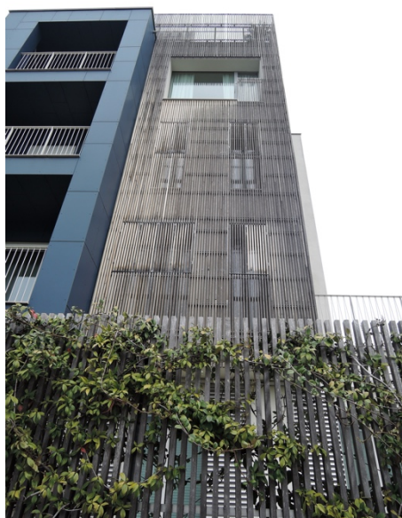
Immagine 104 (sinistra) Dettaglio di uno dei prospetti interni con diverso invecchiamento superficiale, senza alcuna conseguenza in termini di durabilità
