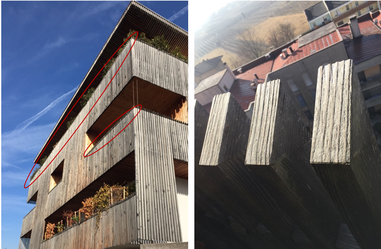
Figura 113 Facciata del caso studio 6 e dettaglio dei componenti di ombreggiamento.
