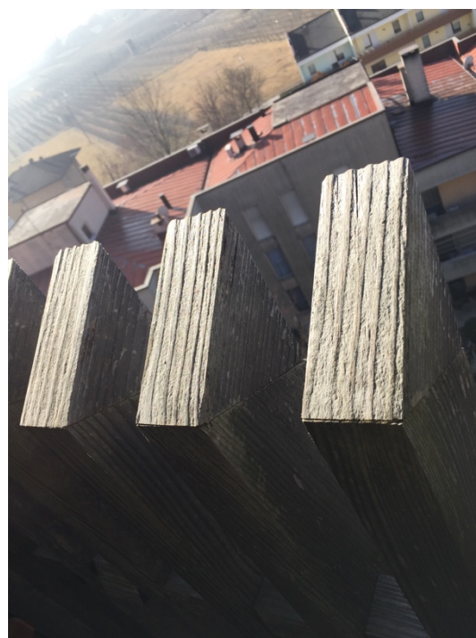
Immagine 42 (sinistra) Listelli verticali 'sospesi' mediante telaio. Non si sono riscontrati fenomeni di instabilità dimensionale o fessurazioni particolari.
