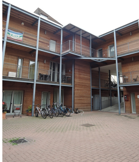
Immagine 13 (sinistra) Foto panoramica della corte interna. Nonostante il trattamento superficiale applicato sulle doghe in larice, l'ingrigimento è evidente e differente a seconda delle porzioni di fabbricato considerate e dell'esposizione alle piogge meteoriche.
