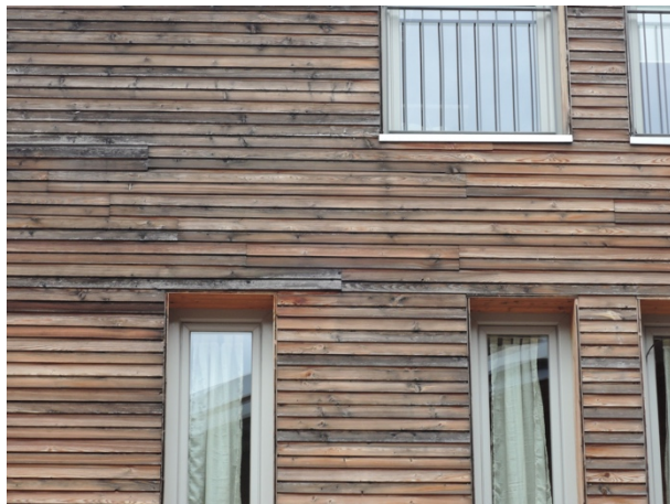
Figura 141 (sinistra) Facciata con rivestimento in doghe di larice maschiato e incollato. Alcuni componenti hanno perso la planarità originale e questo potrebbe essere un punto di degrado futuro. Figura 142 (destra) Dettaglio del rivestimento esterno e dei fissaggi.
