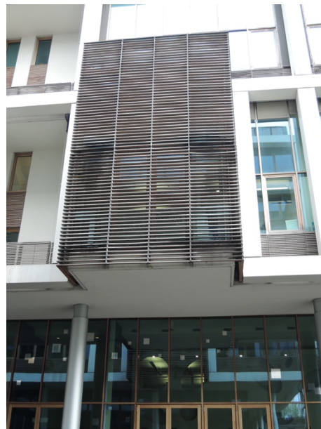
Immagine 114 (sinistra) Box Window interno alla corte. Si rileggono parti di rivestimento esterno con cromature diverse rispetto alle doghe vicine.
