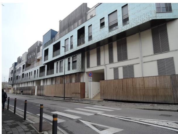
Immagine 102 (sinistra) Recinzione principale su strada- I componenti hanno una coloritura diversa di invecchiamento, dovuta in parte anche ad una diversa esposizione ai raggi UV,(in fondo alla strada non sono presenti edifici sul fronte opposto). Questa diversa sfumatura non ha finora evidenziato avarie dei componenti in legno.
