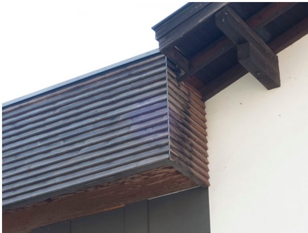
Figura 133 (sinistra) Raccordo tra due tipologie di copertura. L'elemento inclinato non indirizza correttamente le acque sulla copertura, che colano lungo il rivestimento
