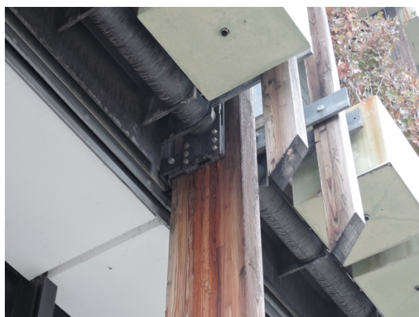
Immagine 92 (sinistra) Facciata con componenti esterni in legno. Non si rilevano particolari avarie di componenti Immagine 93 (destra) Noto di dettaglio di aggancio pareti esterne in acciaio – montanti verticali in legno. Non si rilevano problemi di dilavamento dei componenti in acciaio, che sono correttamente arretrati rispetto al filo dei montanti.
