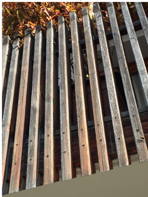
Figura 74 (sinistra) Casa PF. Listelli di larice sotto l'aggetto esterno, protetti, seppure parzialmente, dagli agenti atmosferici esterni
