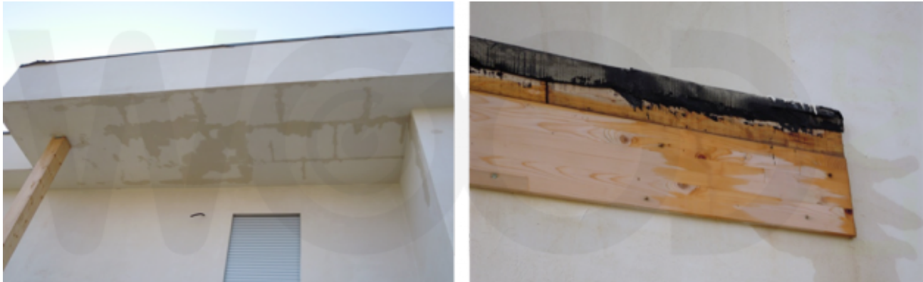
Figura 94 Marcescenza degli elementi di copertura. È necessario la rimozione del pannello ("BLOG - Durabilità degli edifici in legno: quando i danni possono essere evitati WoodLab," n.d.)
