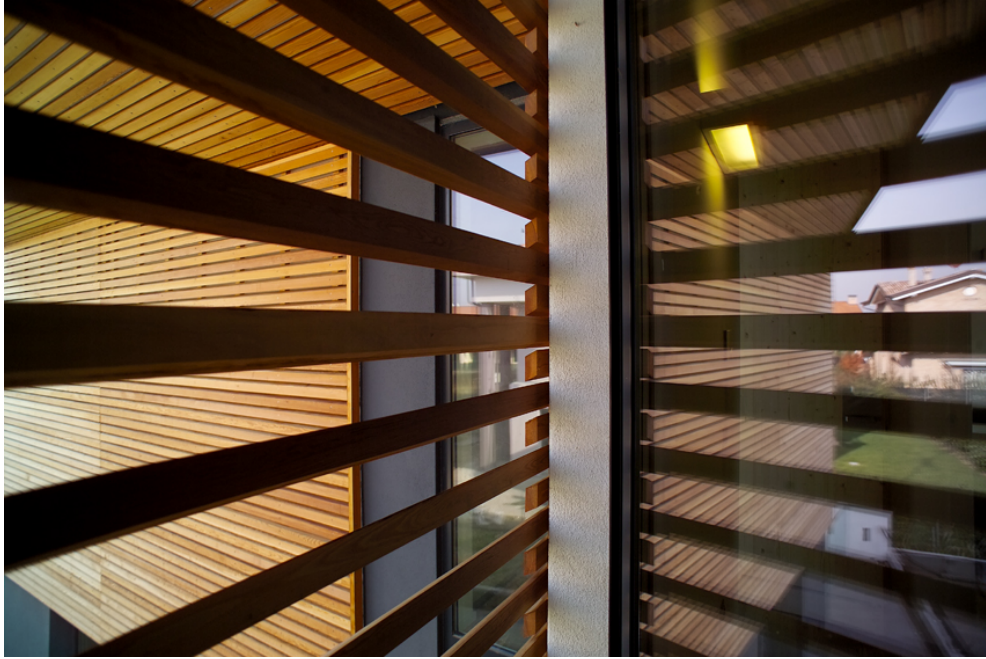
Immagine 6 Involucro con listelli in larice e soluzione di ombreggiamento
