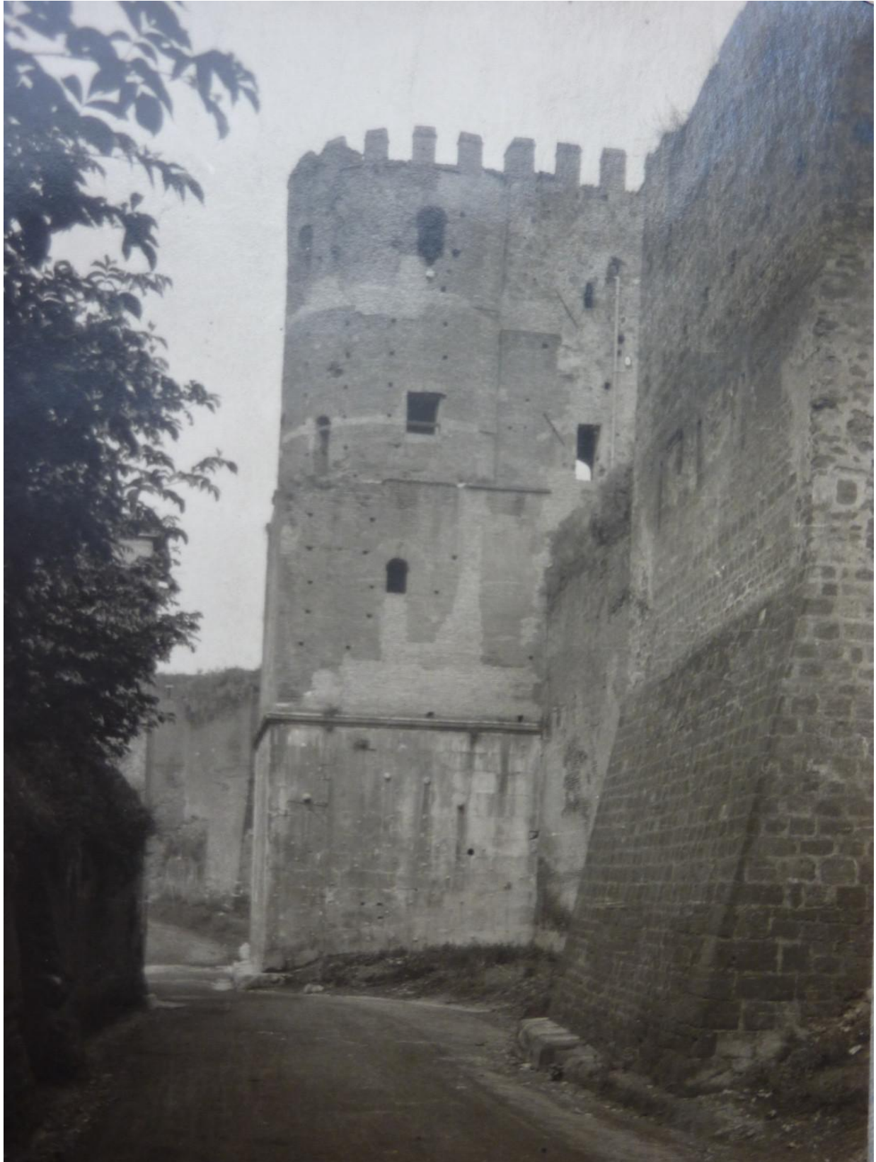
Figura 3.30 Porta Appia, torre orientale, vista da est (1911 – 1940). Nel 1911 vengono fatti i cerchiaggi mentre nel 1940 è aggiustato l'angolo dello spigolo sud-est della sommità del bastione. Si faccia anche il confronto con la figura 3.14, scattata recentemente. Foto Biblioteca di Storia e Topografia antica dell'Università La Sapienza di Roma, inv. 4532.
