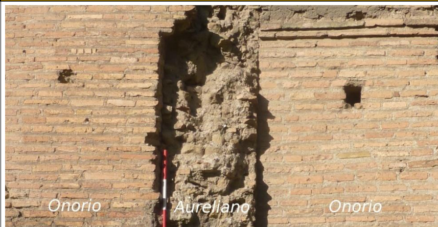
Torre M13, parete NO (interno)
