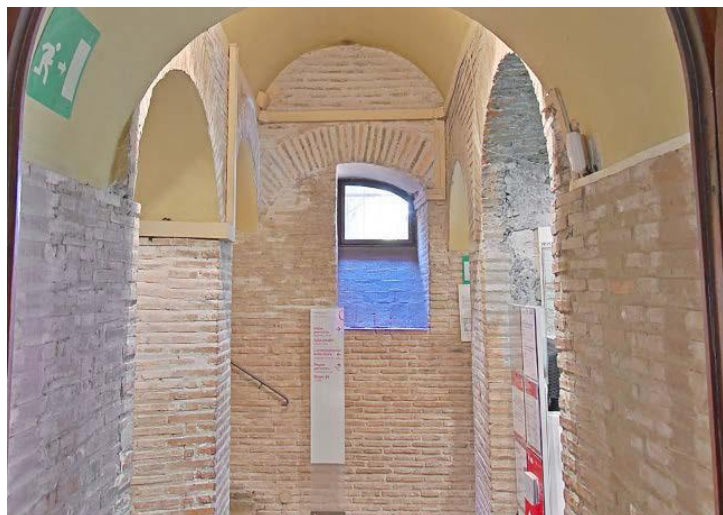
Figura 7.8 Porta Appia, primo piano, struttura corpo scale ovest, ambiente B1 inquadrato da sud verso nord. Foto da Google maps.
