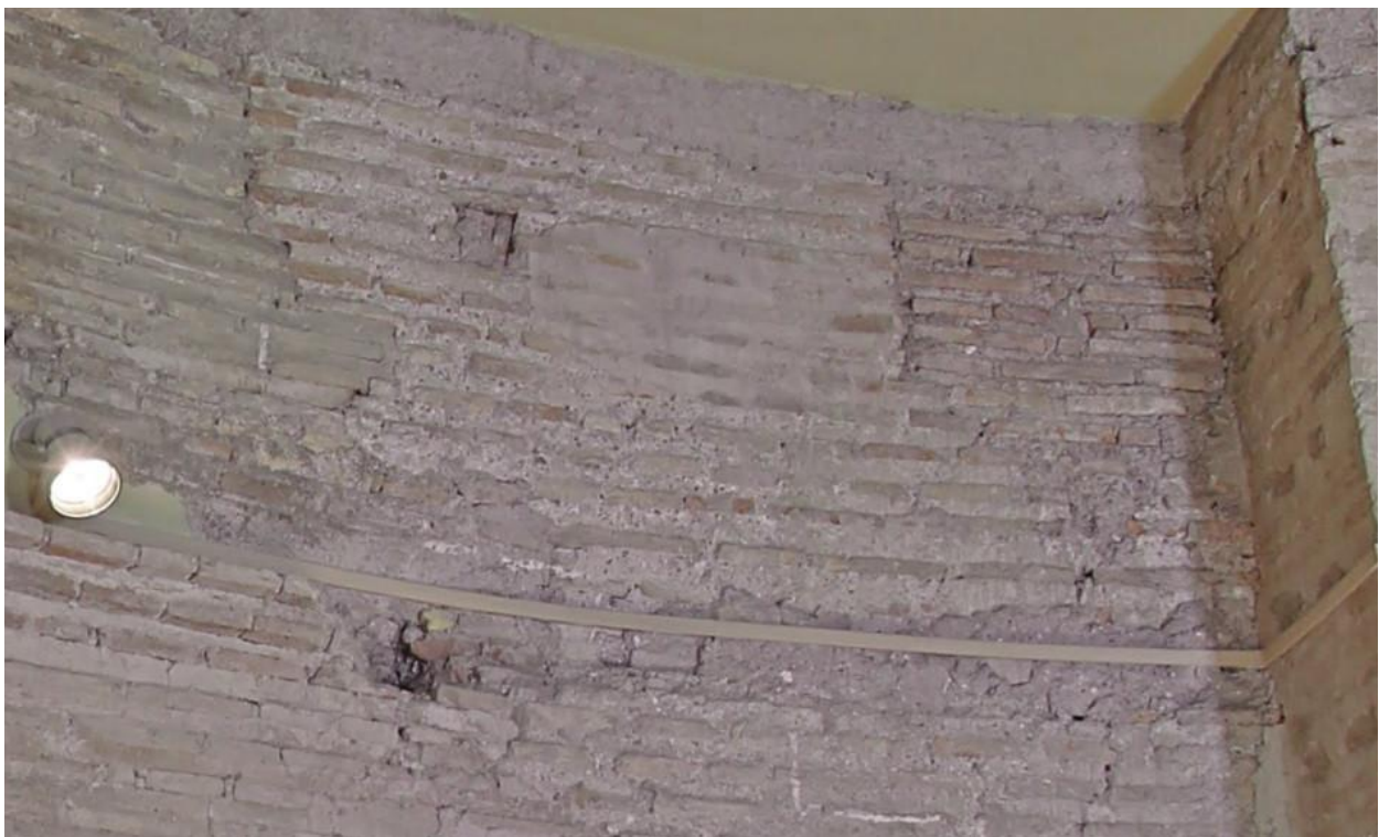
Figura 3.20 Porta Appia, torre orientale, primo piano, parete est. Particolare della foto in figura 3.19. E' inquadrata l'interruzione della falsa volta all'altezza del passaggio della scala in legno con la quale i lavori di Moretti si raggiungeva il secondo piano. Foto da Google maps.
