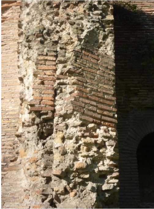
Figura 8.12 Torre M13, parete sud-ovest. Si nota lo stipite della finestra di Aureliano utilizzato come parte conclusiva della strombatura della feritoia pertinente alla muratura di Onorio. Foto D'Ippolito.
