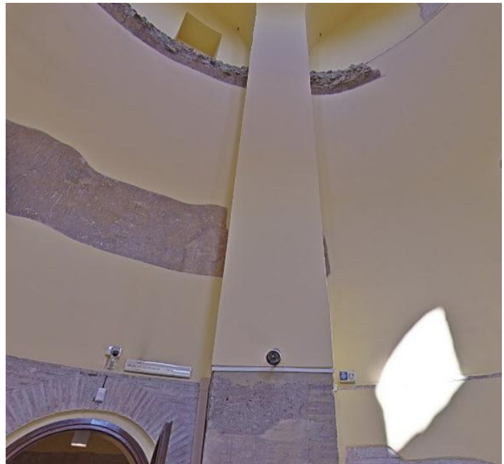
Figura 3.16 Porta Appia, torre orientale, ripresa dal secondo piano verso l'alto e verso nord-est. Si nota un tratto residuale dell'imposta della volta a calotta dell'ultimo piano. Foto da Google maps.
