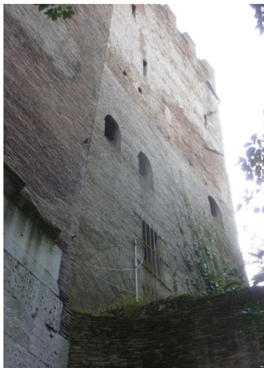
Figura 7.9 Porta Appia vista da nord, verso ovest, con l'addossamento della scarpa lievemente inclinata. In basso, l'apertura EA 251. Foto D'Ippolito.
