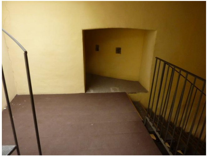
Figura 7.40 Porta Appia, torre occidentale, corpo scale, parete sud, altezza “quinto piano”. Foto D’Ippolito.
