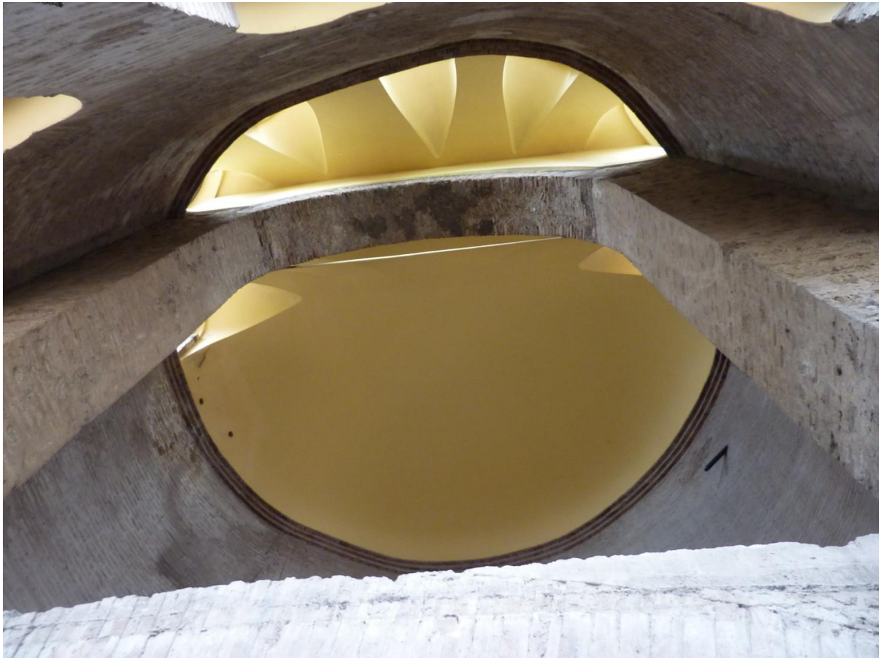
Figura 7.24 Porta Appia, torre occidentale, coperture con addossamento della finta volta. Foto D'Ippolito.
