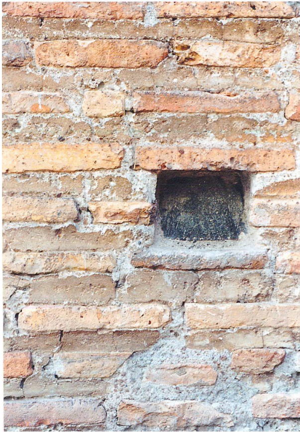
Figura 2.7 Porta Appia, torre orientale, lato est, zona centrale, all'altezza del primo piano, verso sud. Foto D'Ippolito.
