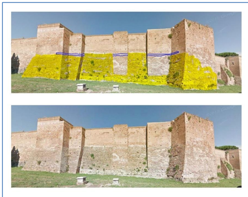
Figura 1.4 Mura Aureliane, avancorpi tra le torri J19 e J 18. In giallo è evidenziata la scarpa di XVI secolo che si addossa ai tre avancorpi occultando la continuità del filare in peperino profilato in blu che li lega al camminamento e ai fianchi delle torri. Foto da Google maps, elaborazione D’Ippolito.
