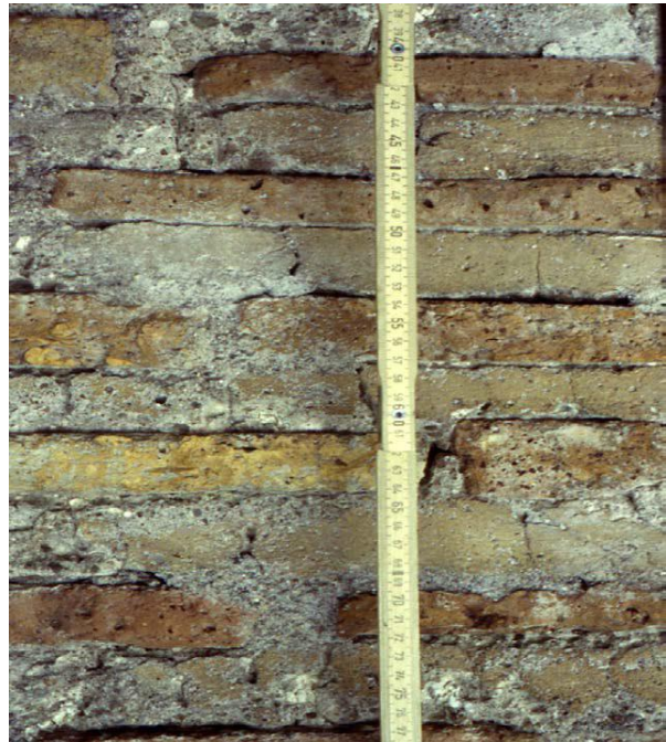
Figura 2.2 Porta Appia, torre orientale, bastione laterizio quadrangolare, lato est, zona centrale del secondo piano. Il dettaglio della muratura evidenzia l'alto modulo, la presenza dell'allisciatura a scivolo e la sopravvivenza di estesi brani di patina. Foto D'Ippolito.
