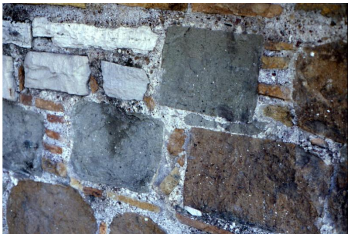
Figura 2.10 Porta Appia, torre occidentale, bastione quadrangolare, lato ovest, altezza tra primo e secondo piano verso sud. Foto D'Ippolito.
