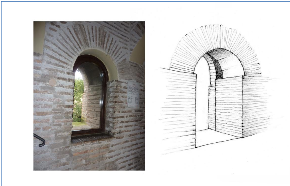
Figura 7.12 Porta Appia, secondo piano, torre occidentale, struttura corpo scale, parete nord dell'ambiente 2B con la finestra EA 254 . E' ben riconoscibile il tratto di muratura aggiunta dall'esterno ( USM 257 ). Foto e disegno D'Ippolito.
