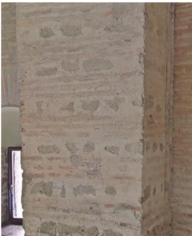
Figura 3.18 Porta Appia, torre orientale, primo piano, pilastro sud-ovest in opera listata. Foto da Google maps.
