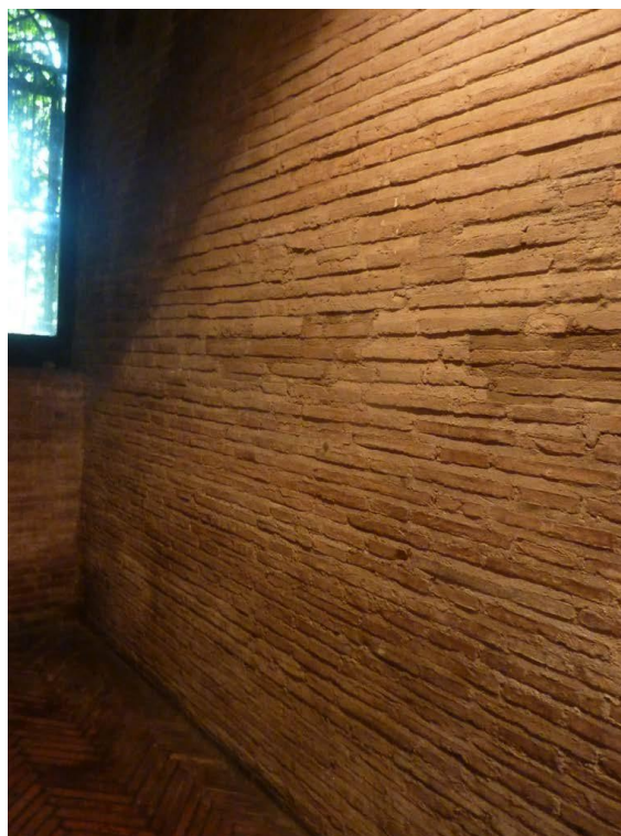
Figura 5.32 Corridoio D nel braccio ovest della controporta verso nord (parete Dx). Foto D'Ippolito.
