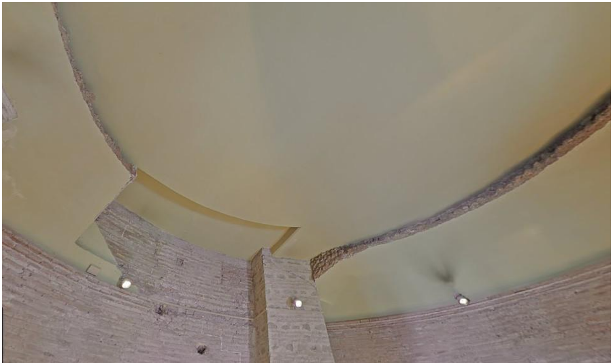
Figura 3.19 Porta Appia, torre orientale, primo piano, inquadratura verso l'alto e verso est. Si nota l'imposta della falsa volta con interruzione e soprastante solaio piano a vista. Foto da Google maps.
