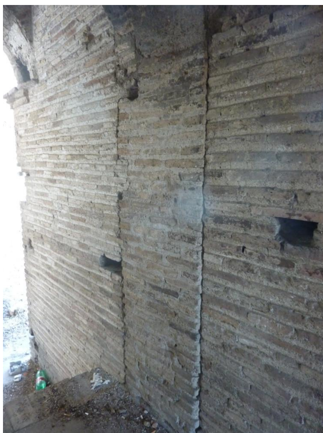
Figura 8.5 Torre L8, parete nord vista da sud-est. Verso ovest si distingue la muratura di Onorio che costituisce il primo pilastro della galleria, al centro la muratura del piedritto di ingresso di Aureliano e verso est il paramento di Onorio che riveste l'interno della torre. Foto D'Ippolito.
