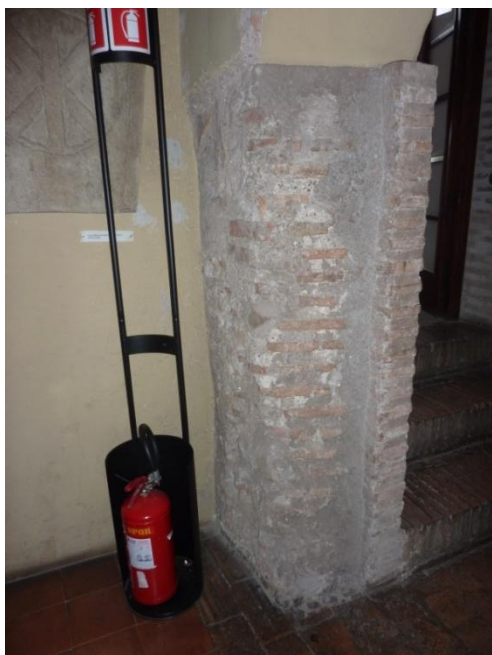
Figura 7.21 Porta Appia, secondo piano, strutture corpo scale occidentale, ambiente A2, lato sud. Foto D'Ippolito.
