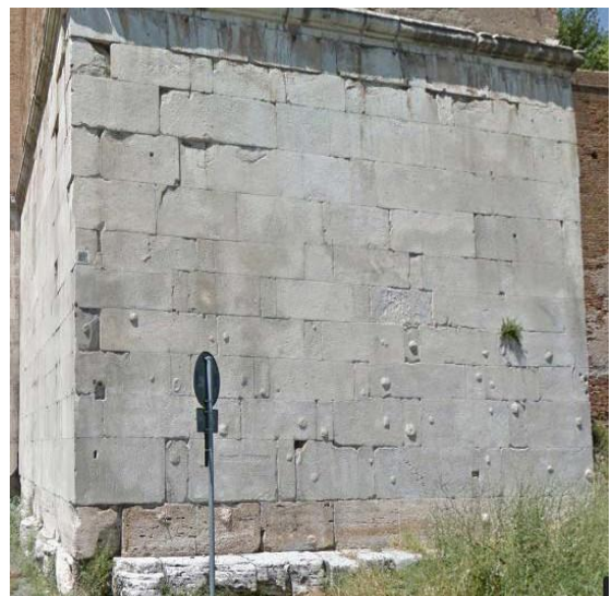
Figura 5.6 Porta Appia, bastione orientale, lato sud. Nella parte inferiore del prospetto sono ben visibili le bozze, sia nei conci in marmo che in quelli in travertino. Foto da Google maps.
