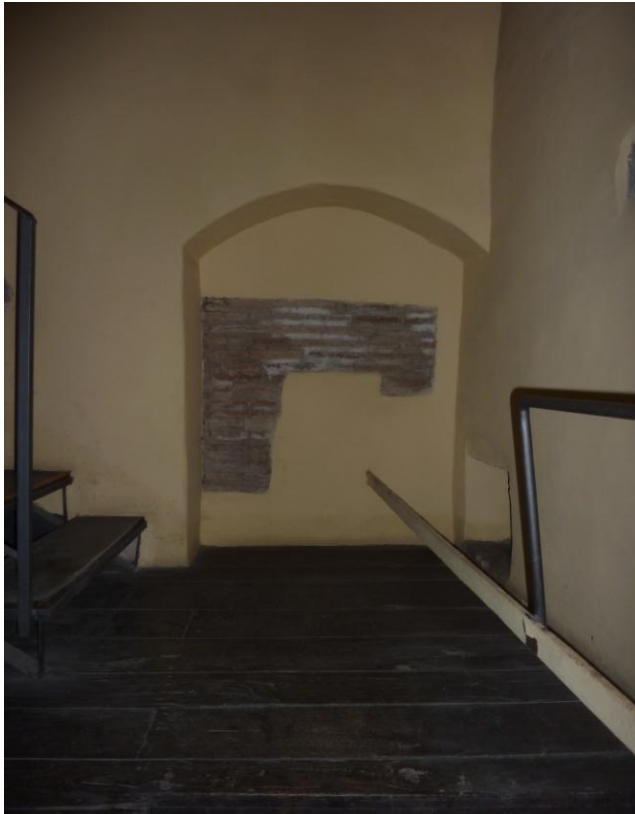
Figura 7.39 Porta Appia, strutture corpo scale occidentale, parete sud, altezza “quarto piano”. Foto D’Ippolito.
