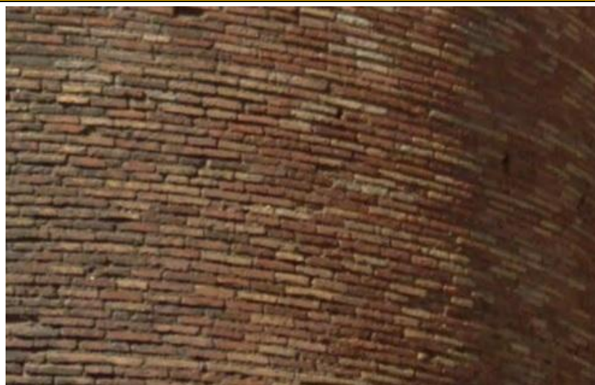
Porta Nomentana, torre N, esterno, porzione NE
