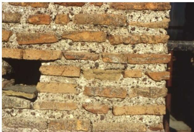
Figura 6.12 Porta Appia, torre occidentale, prospetto sud, paramento della parte circolare all'altezza del terzo piano riferibile al III periodo (VIII-IX secolo, USM 140). In corrispondenza del tratto murario tra le due finestre centrali del prospetto sud, tra i laterizi si notano un blocco di tufo e un mattone decorato allettati con malta chiara ricca di pozzolana in grani di grandi dimensioni. Foto D'Ippolito.
