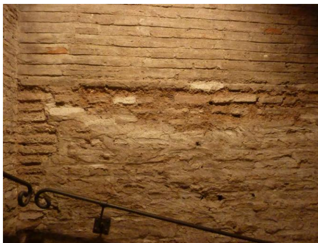
Figura 5.40 SO1e; in alto USM 5015, al centro USM 5012, in basso USM 5013 e in basso a sinistra USM 5014. Al di sotto della muratura più recente (USM 5015), depositi terrosi incoerenti. Foto D'Ippolito.
