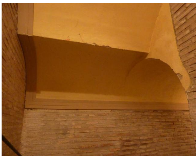
Figura 5.51 Particolare della copertura nella zona d'angolo tra la terza e la quarta rampa. Foto D'Ippolito.
