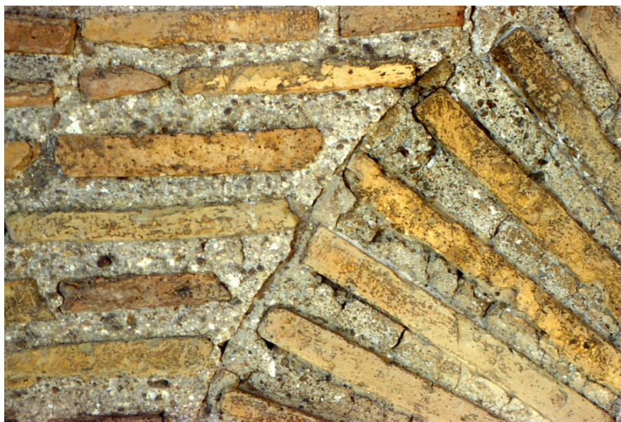
Figura 2.3 Porta Appia, torre occidentale, esposizione est, terzo piano. Ghiera della finestra EA 109 . Lungo il margine della ghiera della finestra onoriana (compresa nella USM 112), erano visibili nel 1999 debolissime tracce di un colore rossastro indicate con nota 15 negli allegati 4.1, 6.1. A sinistra, l'USM 140 di VIII-IX secolo. Foto D'Ippolito.
