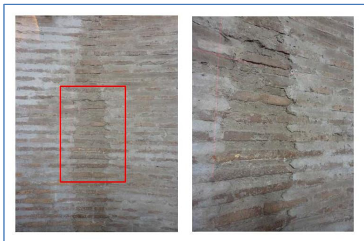
Figura 7.31 Porta Appia, torre occidentale, secondo piano, parete nord. Tratto di cortina laterizia onoriana particolarmente ben conservata priva di ristilatura dei giunti di malta. Foto D'Ippolito.
