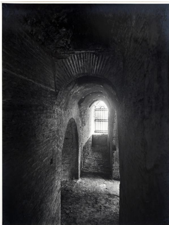
Figura 5.25 Porta Appia, corridoio di ingresso nel braccio ovest della controporta (1940). Foto Museo di Roma XC 3885.
