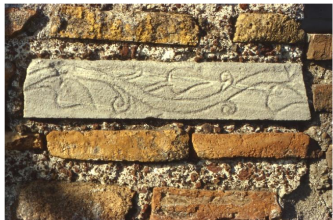
Figura 6.18 Porta Appia, torre occidentale, prospetto est, paramento della parte circolare all'altezza dell'ultimo piano, in prossimità del fianco sud della finestra EA 139 è visibile un blocco in marmo inciso con foglia a cuore che ripete lo stesso motivo del blocco alla base dello sguancio della finestra EA 142. Foto D'Ippolito.
