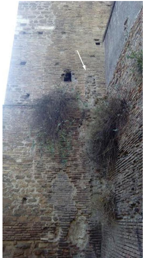
Figura 8.8 Torre M6, fianco nord-est. Sulla muratura di Aureliano si riconosce il profilo del parapetto dell'originario camminamento. Foto Marsico.
