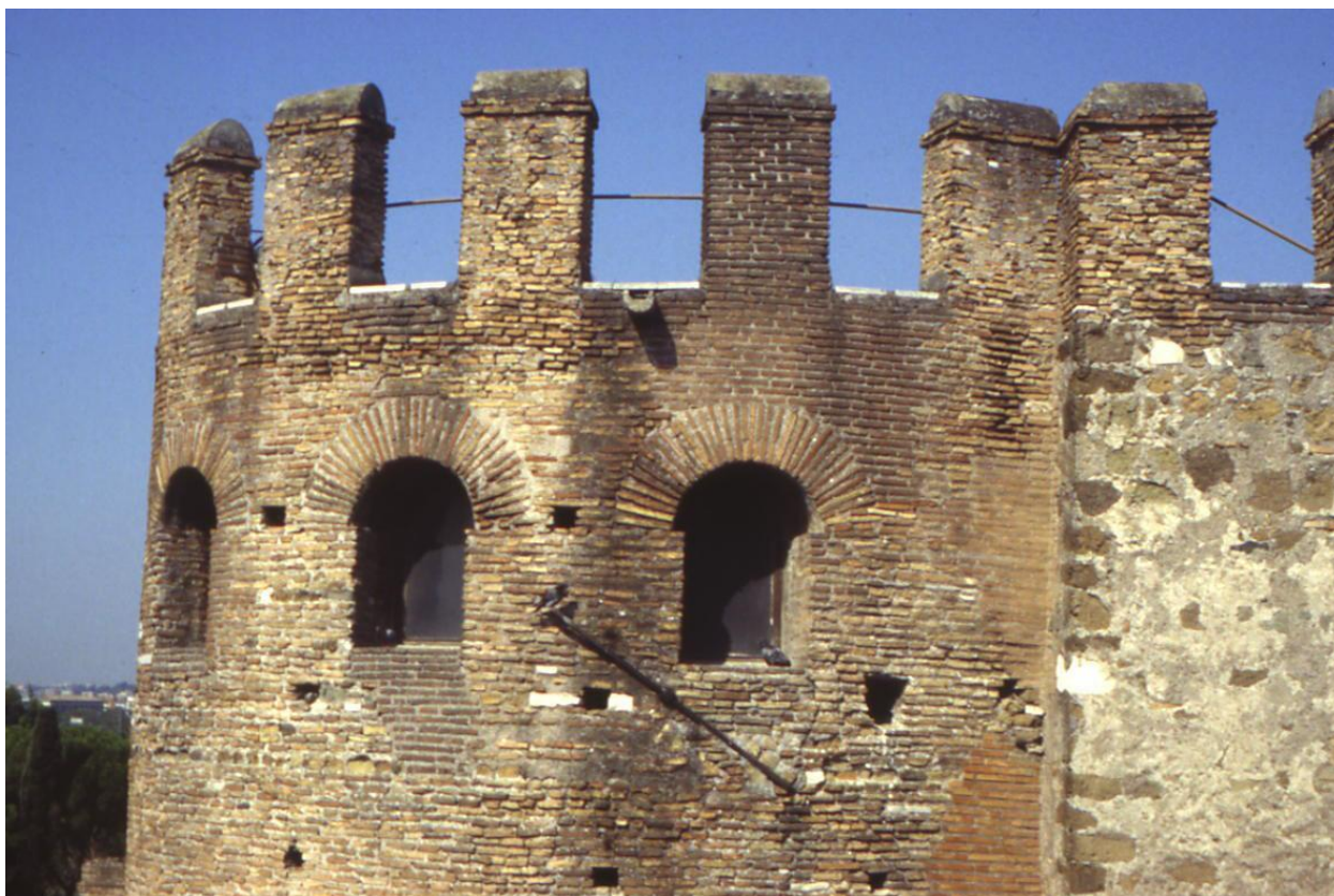
Figura 6.22 Porta Appia, torre occidentale, prospetto est, paramento della parte circolare all'altezza dell'ultimo piano e della terrazza merlata prima dell'ultimo intervento di restauro. Foto D'Ippolito.
