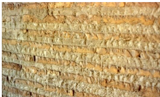
Figura 6.2 Porta Appia, torre occidentale, bastione quadrangolare laterizio, lato est, in corrispondenza del secondo piano. Foto D'Ippolito.
