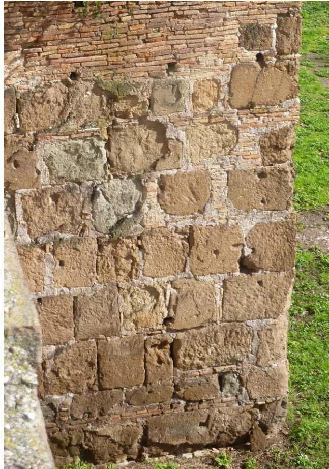
Figura 1.6 Mura Aureliane, settore da Porta Asinaria a Porta Metronia, torre H14. Nella numerazione di Colini si tratta della XIX torre a ponente di Porta Asinaria. Foto D’Ippolito.
