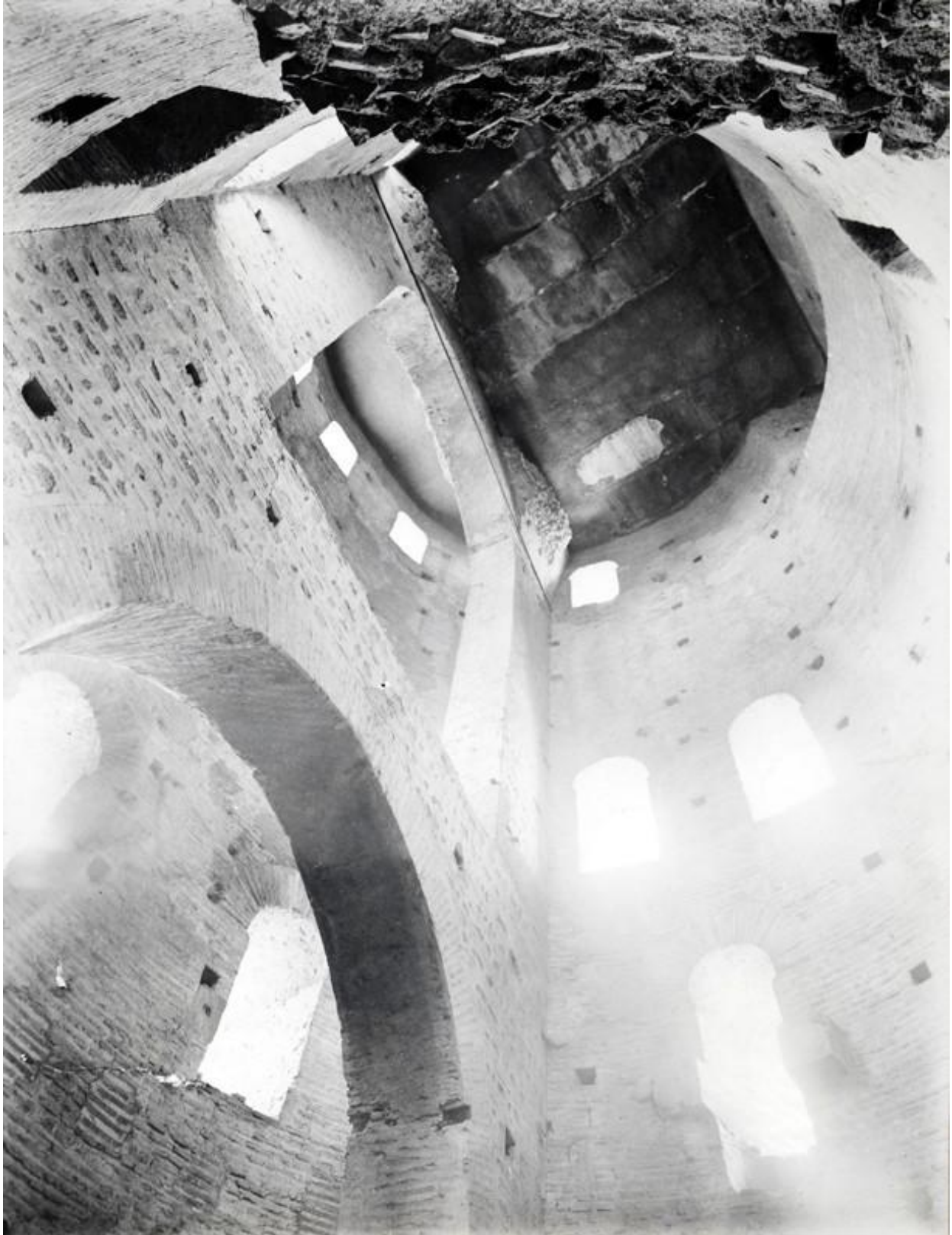
Figura 3.23 Porta Appia, torre occidentale, ripresa dal primo piano verso l'alto e verso sud-ovest (1940). La foto è stata scattata prima che venisse ripristinata la volta che ha diviso il primo dal secondo piano. Foto Palazzo Braschi XC 3886.
