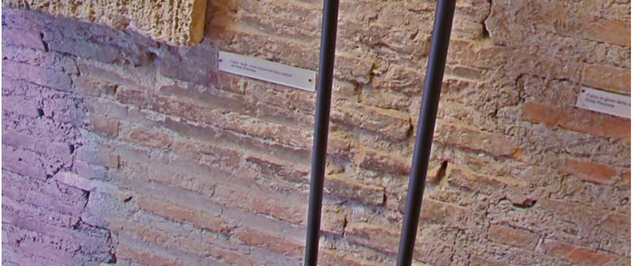
Figura 7.15 Porta Appia, secondo piano, strutture corpo scale occidentale, ambiente A2, lato nord, particolare con muratura con allisciatura a scivolo e patina ocracea (5052 nella zona centrale). Foto da Google maps.
