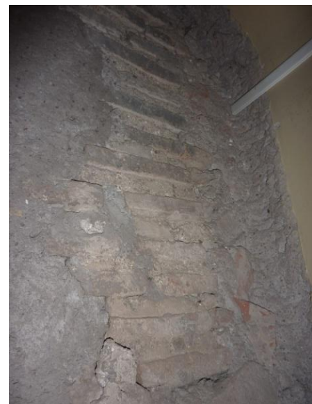
Figura 7.18 Porta Appia, secondo piano, corpo scale occidentale, ambiente A2 lato est particolare del lacerto di muratura che si trova in alto verso sud (USM 5055). Foto D'Ippolito.
