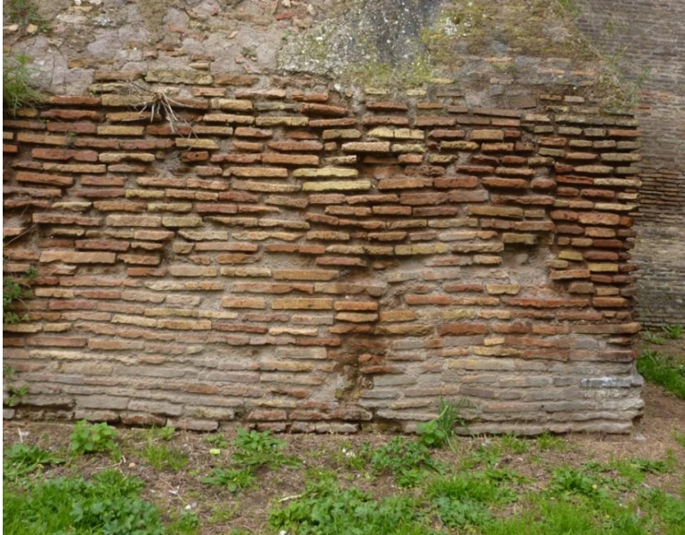
Figura 8.19 Torre M7, lato sud-est, rinforzo alla base (particolare). Foto D'Ippolito.
