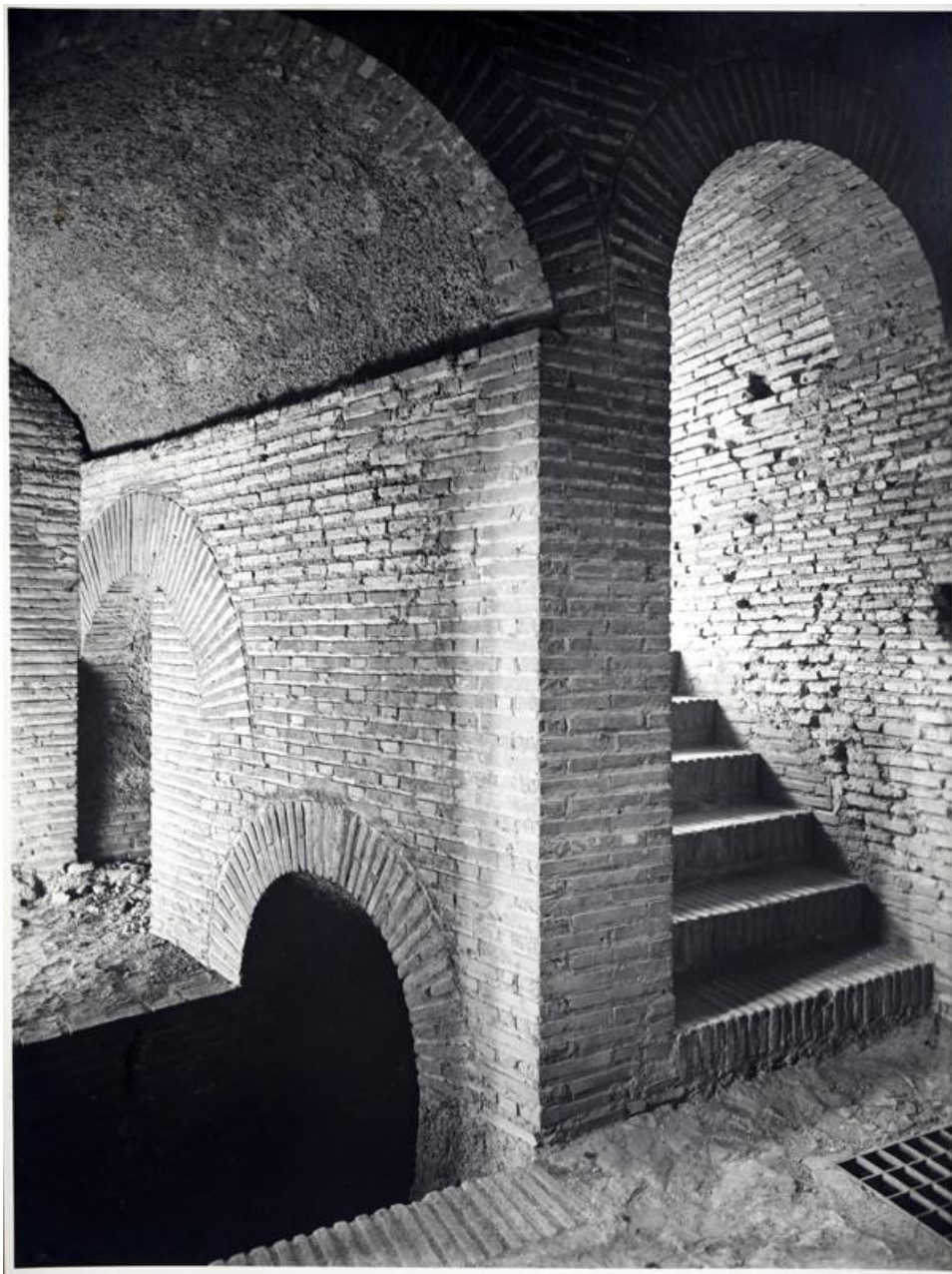
Figura 5.61 Prospetto SS6i e scorcio dell'inizio della settima rampa (1940). Foto Museo di Roma, XC 3888.
