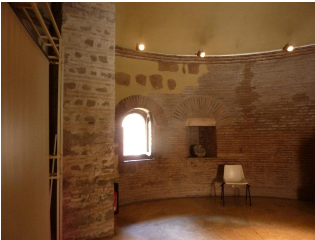
Figura 7.6 Porta Appia, primo piano, torre occidentale, parete ovest. Punto di addossamento (molto rimaneggiato) della muratura di III periodo (VIII-IX secolo, a sinistra) sulla muratura onoriana di II periodo, fase 1 (a destra). La finestra di sinistra viene rifatta nel III periodo mentre quella a destra appartiene al periodo precedente. Foto D'Ippolito.
