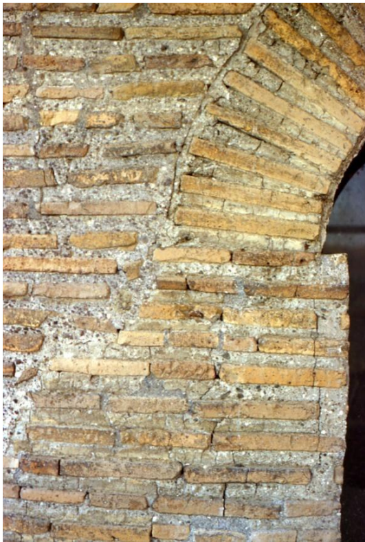
Figura 6.10 Porta Appia, torre occidentale, prospetto est, paramento della parte circolare all'altezza del terzo piano, in corrispondenza dello stipite sud della finestra EA 109 nel punto dell'addossamento della USM 140 sulla USM 112. Foto D'Ippolito.
