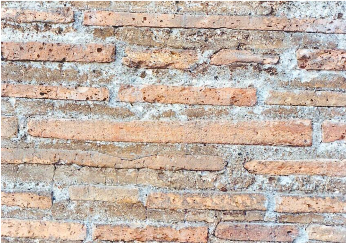
Figura 3.10 Porta Appia, torre orientale, bastione laterizio quadrangolare, lato est, esterno. La muratura è in corrispondenza del primo piano, verso sud. La foto evidenzia la tipica muratura onoriana con allisciatura inclinata verso il basso ( a scivolo) e presenza di patina ocrea. Foto D’Ippolito.
