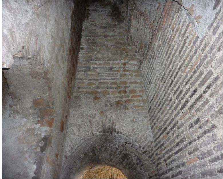
Figura 8.18 Torre M8, tratto di muratura in listato pertinente alla parete C (interno), sopra l'ingresso sud-ovest della torre. Foto D'Ippolito.
