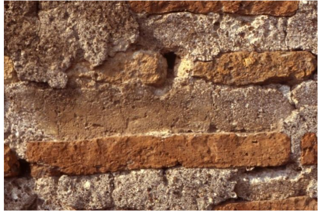
Figura 2.6 Porta Appia: Torre orientale, lato sud verso estremità ovest, in corrispondenza del II piano. Foto D'Ippolito.
