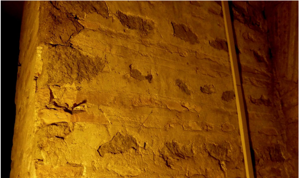
Figura 2.11 Porta Appia, torre occidentale, pilastro orientale, lato sud, primo piano. La malta di finitura mostra una caratteristica incisione che sottolinea la sottostante presenza dei doppi ricorsi di mattoni tra i filari di peperino. Foto D'Ippolito.
