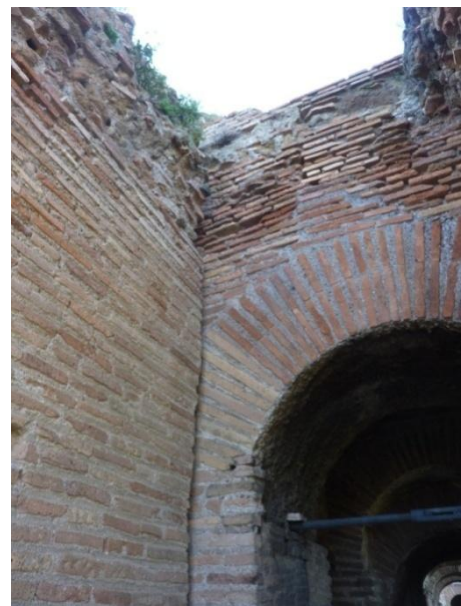
Figura 8.9 Torre L8, addossamento della parete del camminamento al fianco est della torre. Da nord-est. Foto D'Ippolito.
