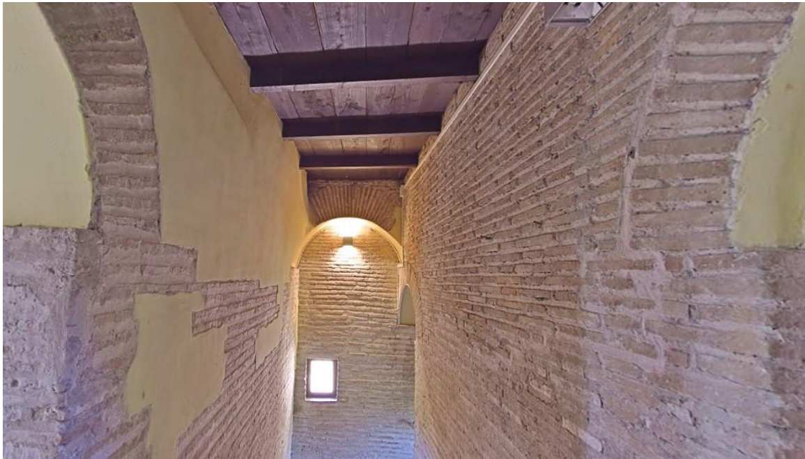
Figura 7.32 Porta Appia, strutture corpo scale occidentale, tra secondo e terzo piano, parete ovest, dodicesima rampa. Foto da Google maps.
