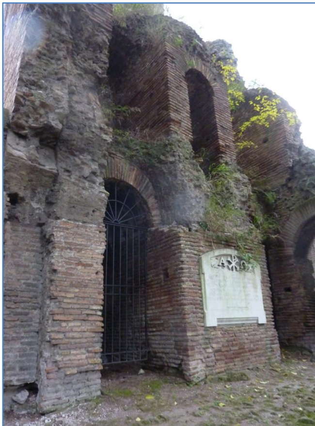
Figura 8.7 Torre M6, interno con corpo scale centrale visto da nord-ovest. Foto D'Ippolito
