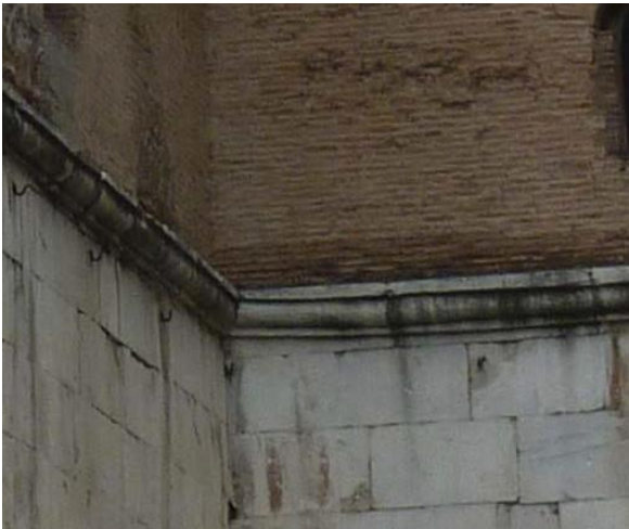
Figura 5.5 Porta Appia, prospetto sud. Blocco speciale che raccorda la cornice della cortina centrale con quella del bastione ovest. Foto D'Ippolito.
