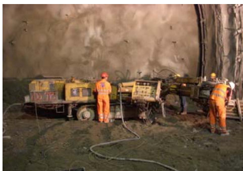
Figura 1: Perforatrice utilizzata per l'esecuzione del DAC test .
