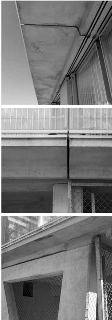
Veduta di dettaglio delle soluzioni tecniche adottate nella giunzione degli elementi modulari prefabbricati.
