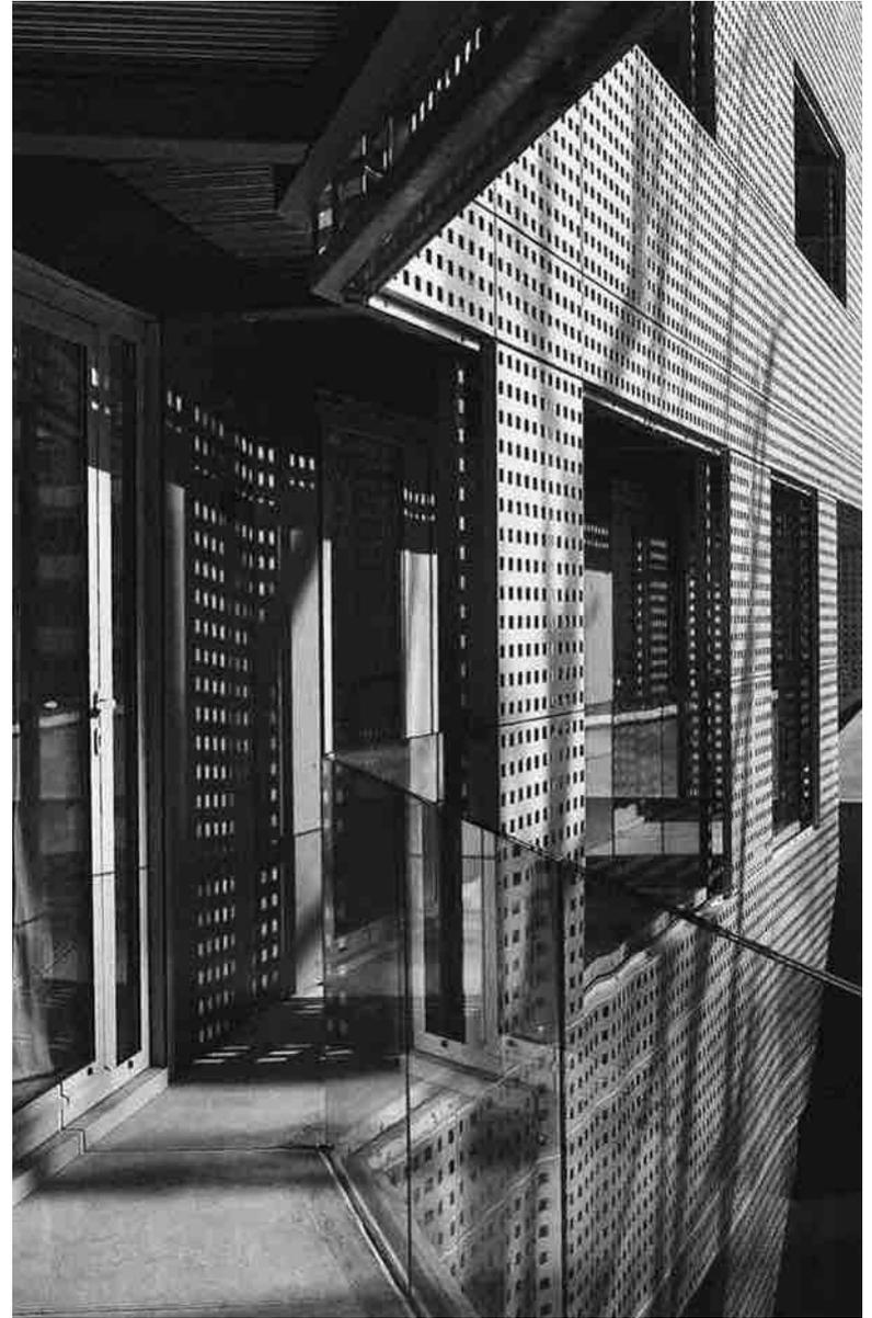
Veduta parziale del ballatoio esterno e del nuovo rivestimento in pannelli in lamiera metallica forata.
