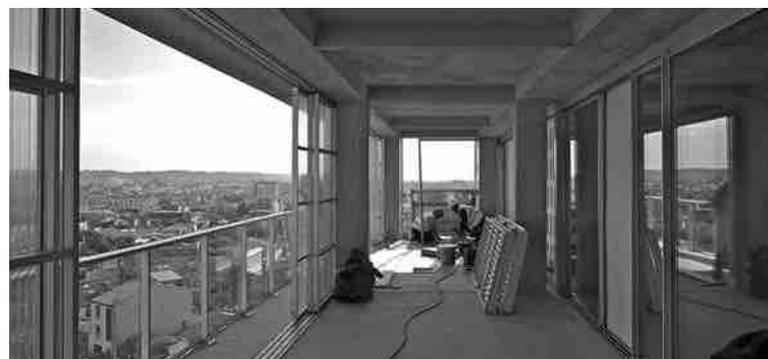
Veduta dell'intervento effettuato sulla facciata dell'edificio in tre successive fasi di realizzazione: posa in opera dei nuovi balconi prefabbricati; ampliamento delle bucaure; montaggio dei nuovi infissi e dei sistemi di schermatura.
