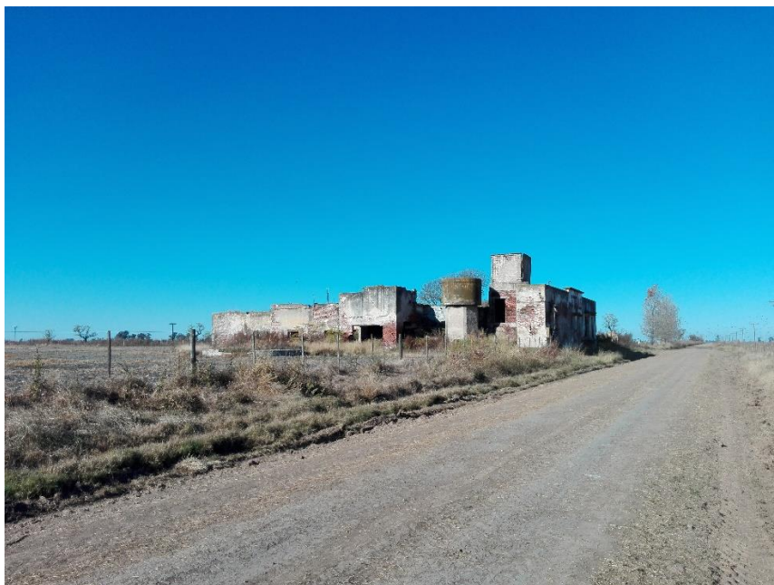
Ruderi di un caseificio abbandonato in una zona agricola (Sastre, 2017)
