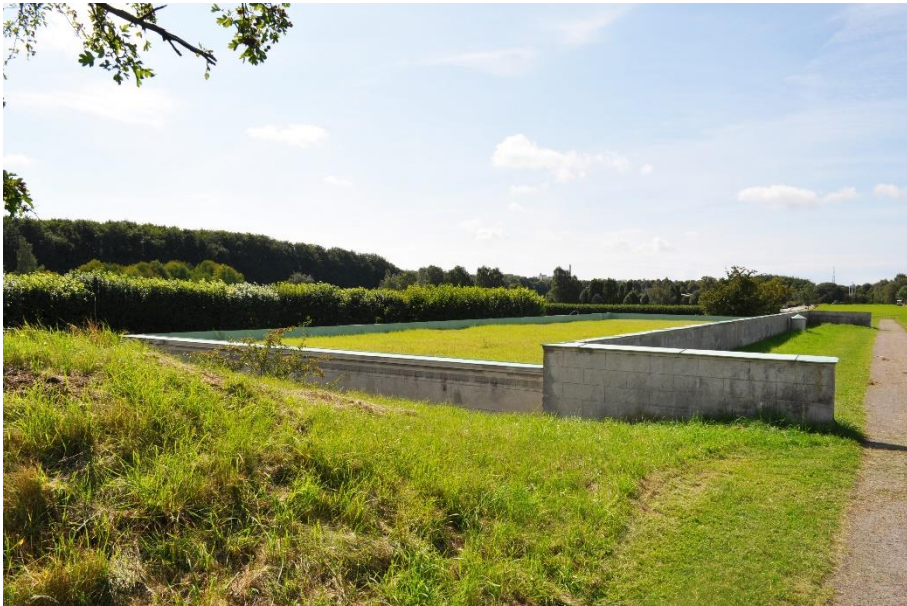
10_ La copertura della cappella funeraria.
