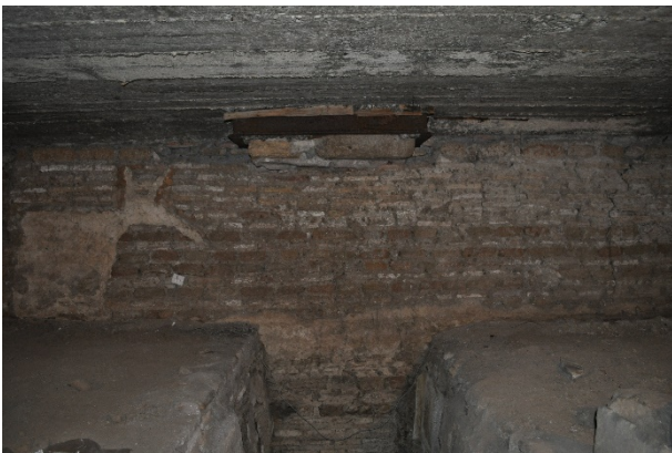
Figura 18. Oratorio di San Saba, vista del muro settentrionale e particolare della base di colonna parzialmente inglobata nel solaio
