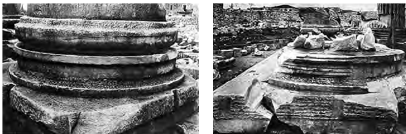
Fig. 5.8. Didyma, tempio di Apollo, basi non ultimate della terza e della quinta colonna da est della fila esterna nella peristasi settentrionale (da H. Knackfuss, Didyma. Erster Teil: Die Baubeschreibung, Fotografien , Berlin 1941, tav. 147).
