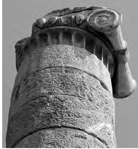
Fig. 5.7. Didyma, tempio di Apollo, dettaglio del fusto e capitello della quarta colonna non ultimata da est della fila interna nella peristasi meridionale.
