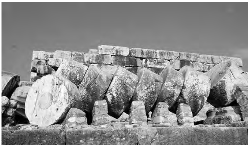
Fig. 5.6. Rocchi delle colonne della peristasi occidentale in posizione di crollo.
