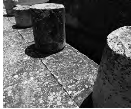
Fig. 2.12. Ramnunte, tempio di Nemesi, dettaglio dello stilobate.
