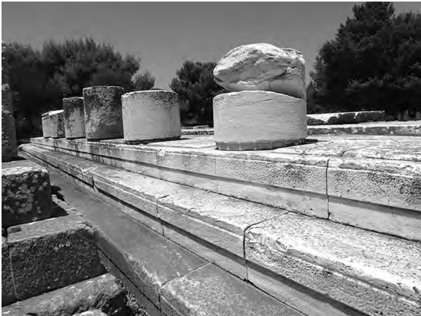
Fig. 2.11. Ramnunte, tempio di Nemesi, vista da est del lato sud del tempio con differenti stadi di lavorazione dei gradini e delle colonne.
