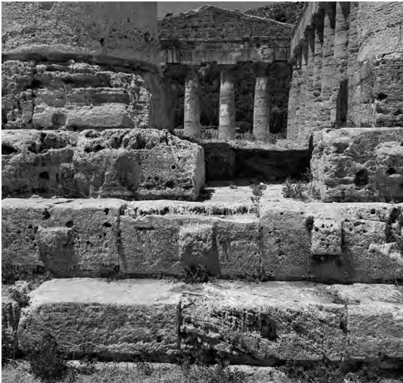
Fig. 4.7. Segesta vista del tempio da est, dettaglio della crepidine.
