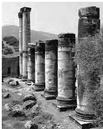
Fig. 5.14. Sardi, tempio di Artemide, fronte orientale, vista da nord, con indicazione della colonna n. 4 (da Yegül 2014, p. 205, fig. 2).
