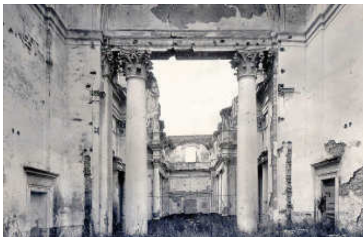
Fig. 2. Chiesa di S. Maria in Gradi a Viterbo come appare in una vista post bellica, successiva alla demolizione della copertura conseguente ai danni alla volta causati dai bombardamenti del 1944 ma realizzata solo nel 1951 (da < http://www.beniculturali.it/mibac/export/MiBAC/sito-MiBAC > [07/12/2016]).
