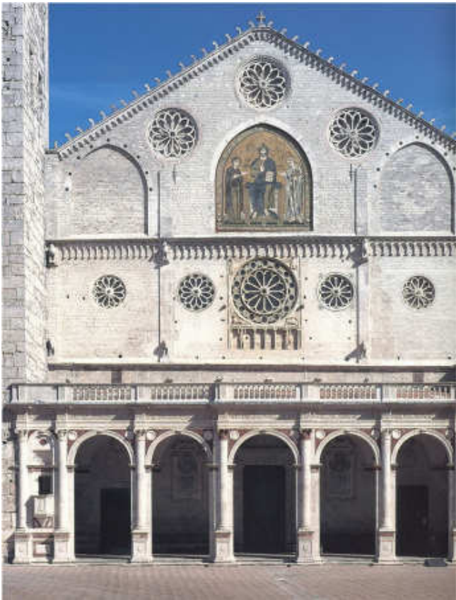
Fig. 7. Duomo di Spoleto, sorto nel XII secolo su una chiesa precedente, venne fortemente modificato alla fine del Seicento con il rifacimento delle navate e delle volte; alla fine del XVIII furono realizzate le cappelle laterali che contribuiscono attivamente alla stabilità del complesso. Tra gli interventi recenti si evidenzia, per la minimalità e l'efficacia, l'introduzione di due catene longitudinali su progetto di Antonino Gallo Curcio, appena visibili in facciata (da BENAZZI, CARBONARA 2002).
