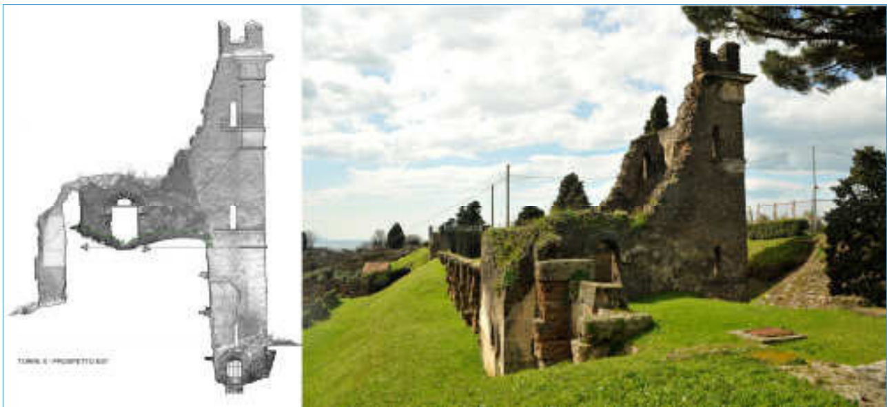
Fig. 10. Torre X del perimetro difensivo di Pompei, un esempio di intervento ricavato dall'analisi della costruzione e della sua storia attraverso i documenti. Mediante foto storiche si è evidenziata la vulnerabilità del fronte, collassato con rotazione verso l'esterno, a seguito degli scuotimenti sismici connessi alle attività vulcaniche precedenti al seppellimento della città. La ricostruzione archeologica che ha seguito lo scavo, ormai storicizzata, ha evidentemente riproposto la stessa vulnerabilità, aggravata dalla parzialità del rifacimento. Sono stati dunque ipotizzati interventi di miglioramento mediante l'inserimento di strallature e tiranti metallici, reversibili, esterni alla muratura ma poco visibili perché posizionati all'interno del volume.
