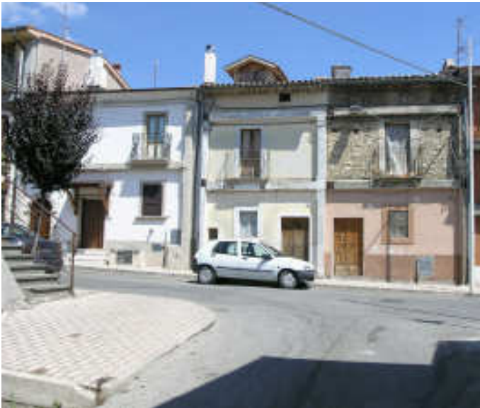
Fig. 5. Le opere di rinforzo delle strutture murarie di Aielli (L'Aquila), a seguito del terremoto di Avezzano, furono condotte con una certa omogeneità nell'intero centro; si adottò una metodologia che incornicia le facciate con un telaio di c.a. ancorato con tiranti trasversali metallici (foto G. Palmerio).
