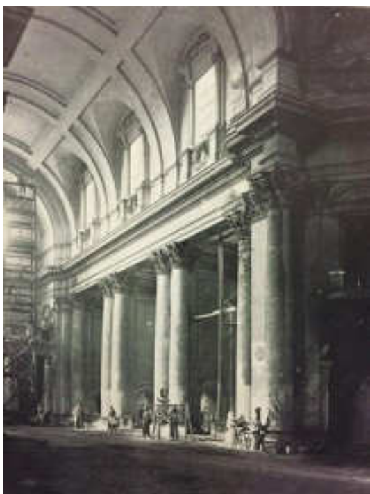
Fig. 2. Chiesa di S. Maria in Gradi a Viterbo come appare in una vista post bellica, successiva alla demolizione della copertura conseguente ai danni alla volta causati dai bombardamenti del 1944 ma realizzata solo nel 1951 (da < http://www.beniculturali.it/mibac/export/MiBAC/sito-MiBAC > [07/12/2016]).
