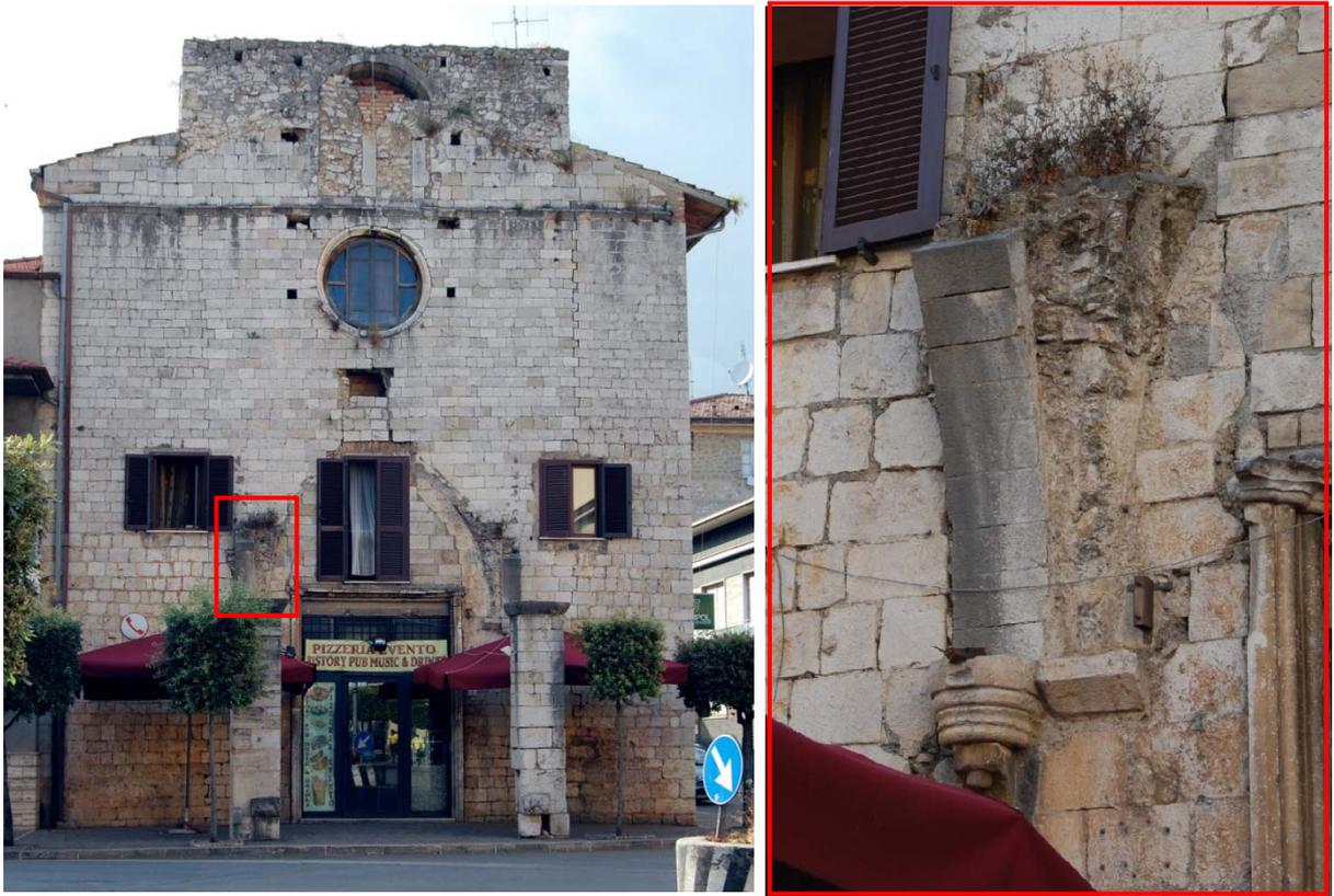
**Fig. 14 - 2014 - Facciata principale. Particolare dell'imposta dell'arco che sosteneva il protiro a crociera**
