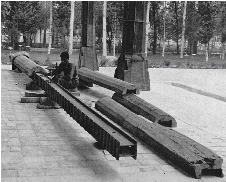
**Fig. 74** - Palazzo Cehel Sotun, inserimento di un sostegno in ferro all'interno della colonna, smontata e segata, al fine di far assorbire al ferro il carico di punta (ZANDER G. 1970, fig. 20)
