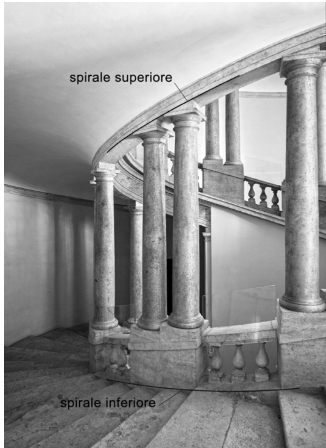
Fig. 14/ Roma. Palazzo del Quirinale. Scala elicoidale di Mascarino. Individuazione delle due eliche.
