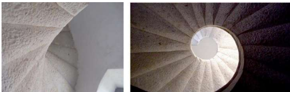
Figura 5. Scala elicoidale della Certosa di Padula. A sinistra osservata dal basso, a destra dall'alto. Elicità sinistrorsa in entrambi i casi.
