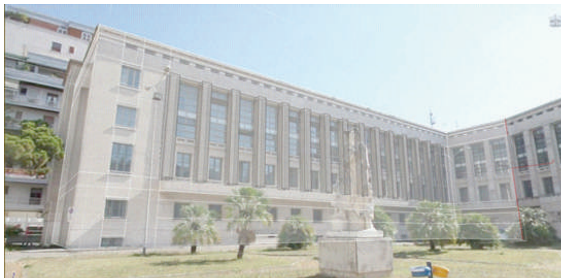
11. Ricostruzione Geometrica del modello utilizzando l'immagine panoramica dal corile interno al Palazzo M.
