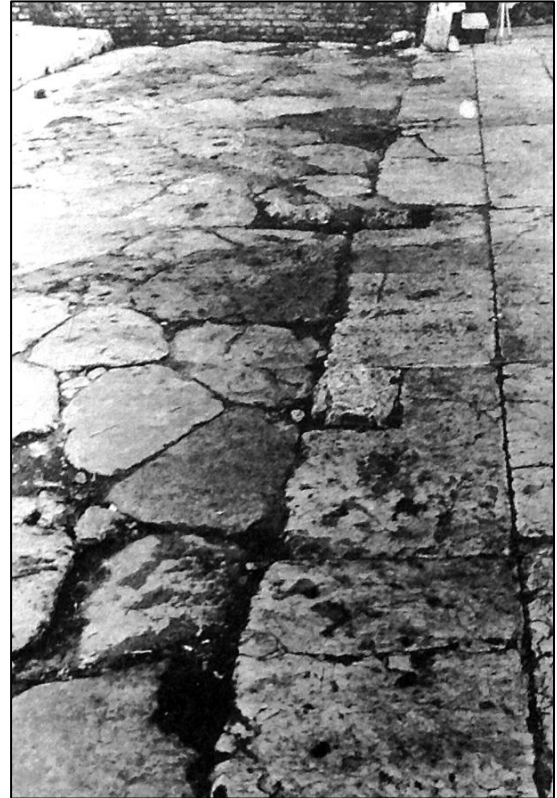
Figura 8. Tratto di basolato della via Appia con resti dei paracarri posti ai imiti della piazza forense (da COPPOLA 1984).
