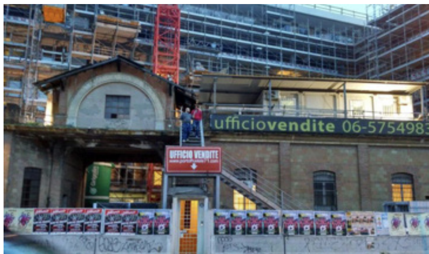
Figura 4 | Il portale degli Ex Consorzi Agrari, unica testimonianza mantenuta nell'intervento di demolizione e ricostruzione del progetto residenziale Porto Fluviale 71 (ETTCity).
