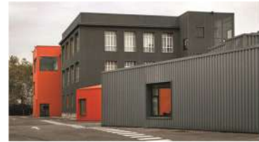
[BARAGAÑO], Ristrutturazione e ampliamento della sede ArcelorMittal's R&D Center ad Aviles in Spagna (2012)
