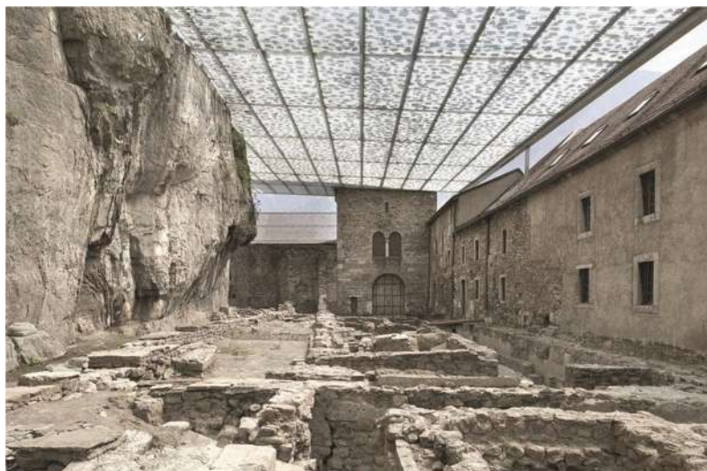
Savioz Fabrizi, Copertura delle rovine dell'Abbazia di St. Maurice, Svizzera
