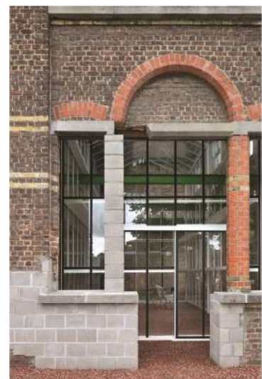
De Vylder, Vinck, Taillieu. Caritas. Centro psichiatrico, Melle, Belgio (2017)
