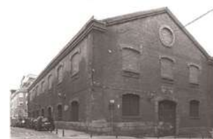
STATO INIZIALE “A” : Central Eléctrica del Mediodía
