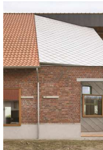
De Vylder, Vinck, Taillieu, Pepingen , Gent, Belgio (2016) Foto: Pilip Dujardin
