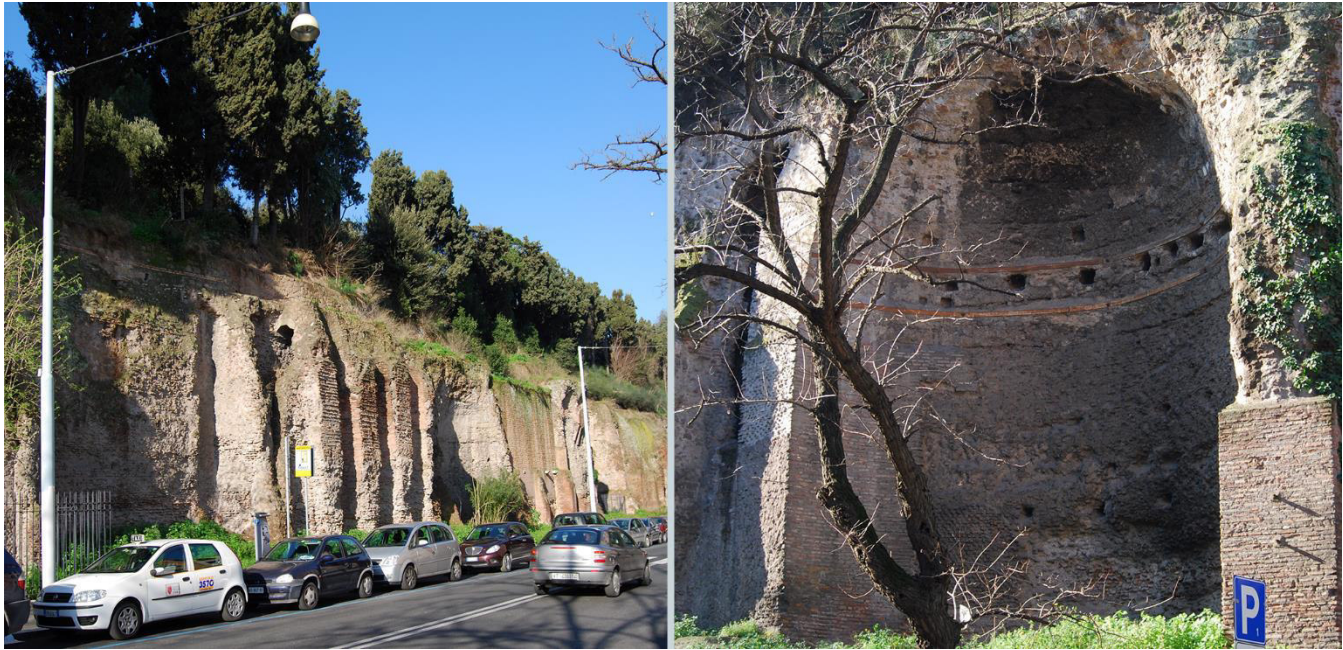
Fig. 4.29. Il Tempio del divo Claudio. Facciata del basamento (a sinistra) e dettaglio di pilastro del primo livello (a destra)..
