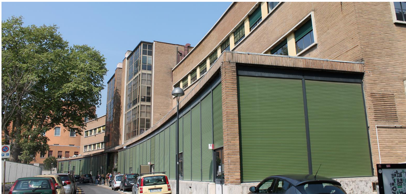
Fig. 4.5 L'Istituto di Botanica. Vista del prospetto posteriore.
