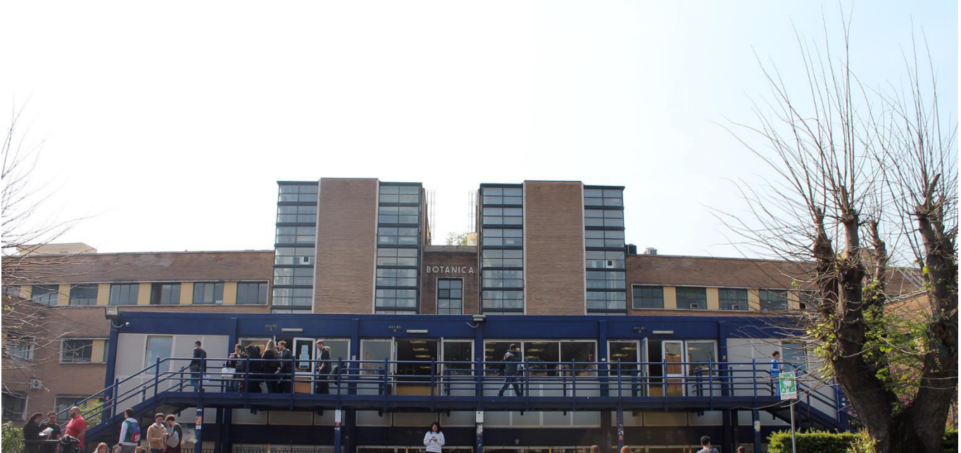
Fig. 4.9 L'Istituto di Botanica. Dettaglio del prospetto principale.
