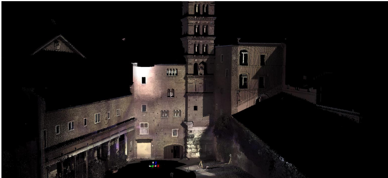
Fig. 4.30. Il complesso della chiesa dei Santi Giovanni e Paolo e i resti del Tempio del divo Claudio. Modello numerico, visualizzazione RGB colore.
