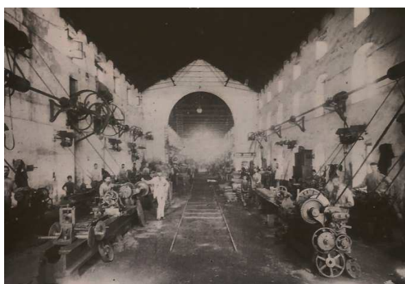
Fig. 2. Impresa Industriale Italiana di Costruzioni Metalliche. Veduta interna dell'opificio per la tornitura (CARUGHI 2003, p.27)
