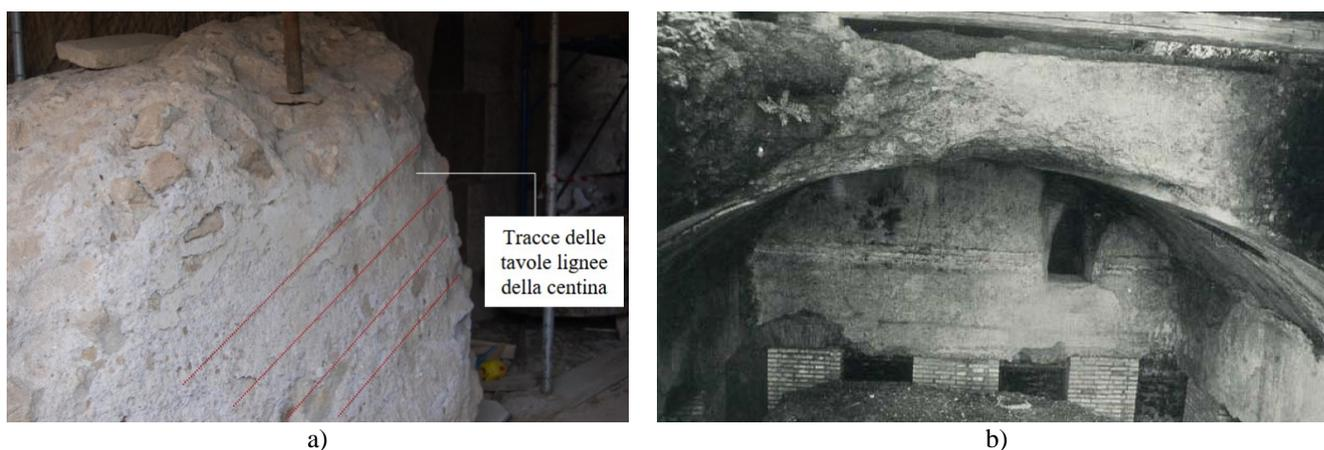
Figura 4.23 Porzione di volta in cui sono ancora visibili le tracce delle tavole della centina (a); volta ribassata di uno degli ambienti prospiciente il “Cortile delle Biblioteche” (b).
