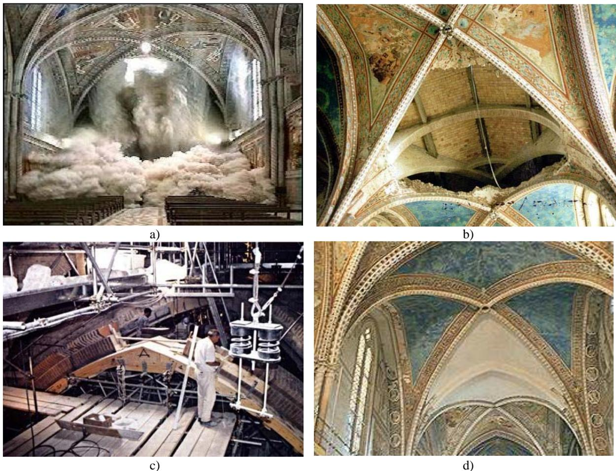
Figura 2.14 Basilica di San Francesco d'Assisi: fotogramma del momento del crollo a seguito del sisma del '97 (a); porzione di volta crollata (b); fase di restauro della volta con la posa della centina (c); ricostruzione della volta (d).
