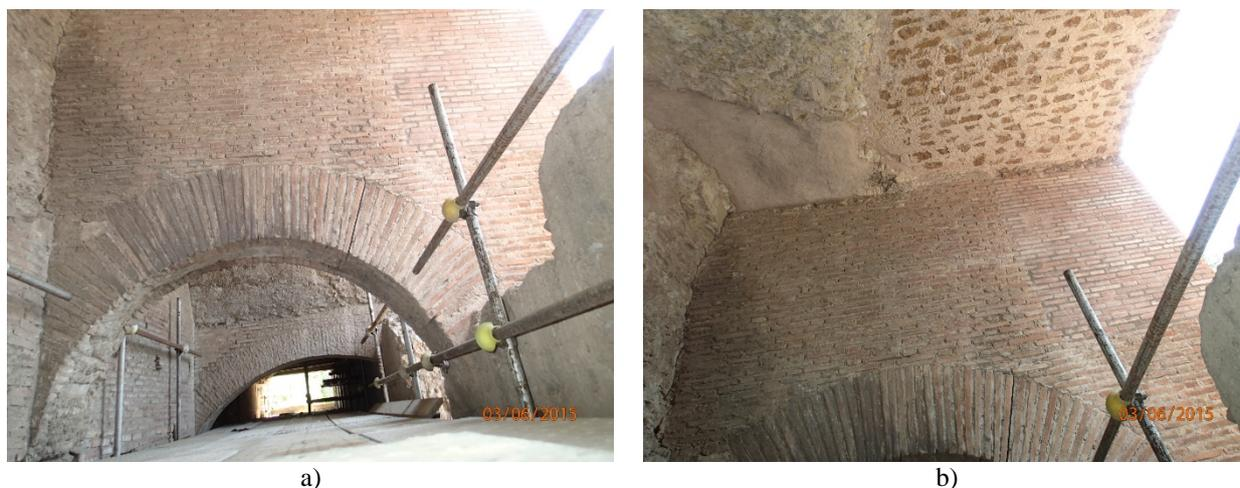
Figura 4.4 Secondo tratto della Galleria: muri laterizi con aperture ad arco perpendicolari allo sviluppo longitudinale del camminamento (a); andamento della volta in questo tratto (b).
