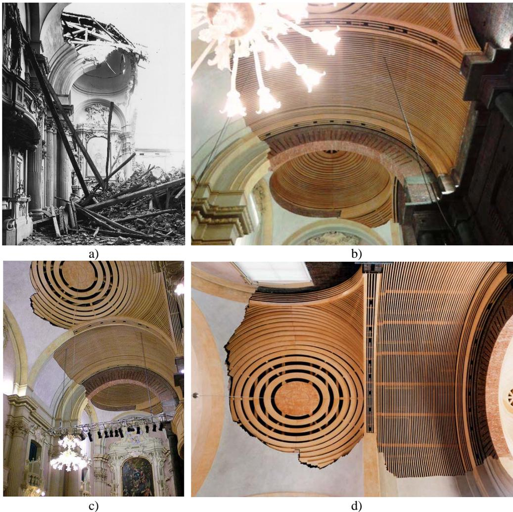
Figura 2.13 Oratorio di San Filippo Neri: situazione dopo il bombardamento (a); restauro delle coperture voltate (b-d).
