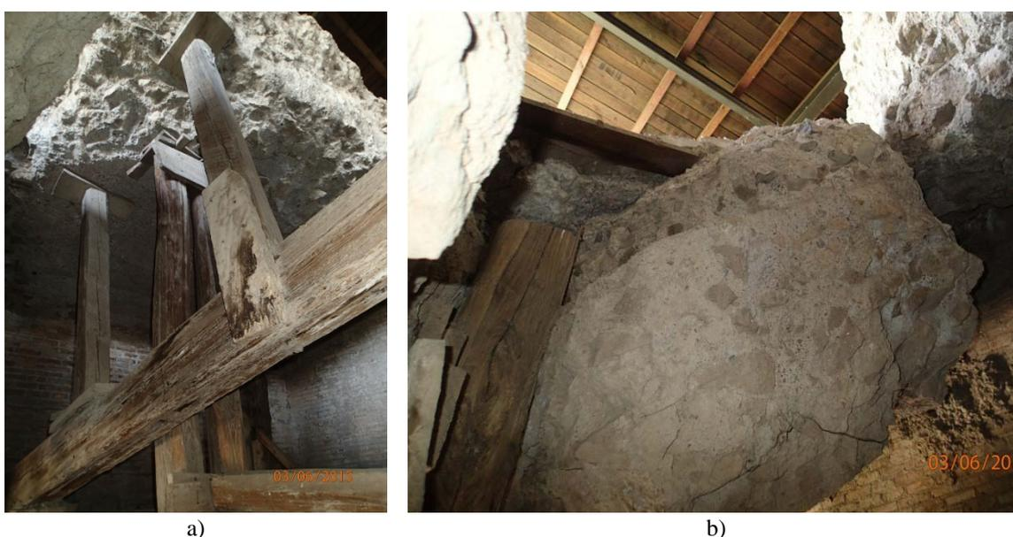
Figura 4.3 Particolare dei diversi puntelli lignei utilizzati a sostegno dei blocchi (a); porzioni di volta poste a reciproco contrasto anche con l'ausilio di un puntello ligneo (b).
