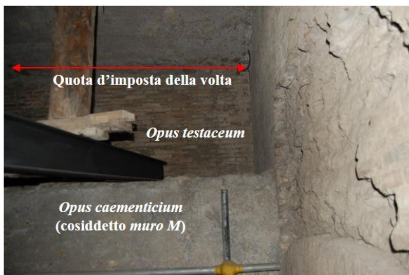
Figura 4.22 Porzione di volta della *Galleria* ancora alla quota d'imposta d'origine che scavalca il muro *M*.
