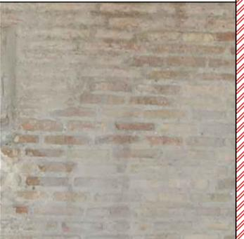
Muratura costituita da **mattoni in laterizio** allestiti con malta o con laterizi di forma triangolare con la punta inserita nel *caementicium*.
