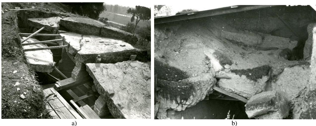
Figura 4.17 Foto storiche degli scavi Carettoni: estradosso della volta della “prima metà” della *Galleria* (a); volta della “terza metà” con l’estradosso ancora colmo di terra (b).
