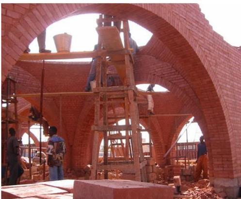
*La partecipazione della fondazione Aga Kahn al progetto ha previsto che la Swiss Agency for Development producesse un fitto reportage sulle modalità costruttive impiegate durante l'intera fase di cantiere. E' osservabile come per l'intera struttura sia stato limitato al massimo l'utilizzo di materiali differenti da quelli presenti in loco, e come le tecnologie utilizzate siano inquadrabili nell'ambito della tradizione vernacolare.*
