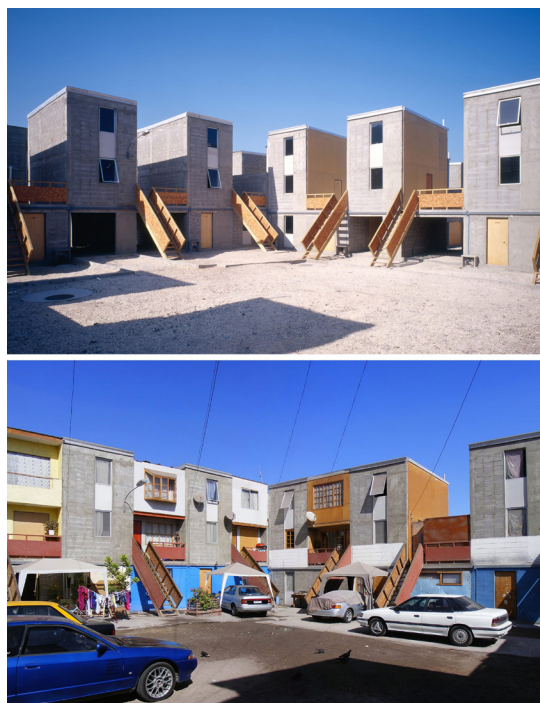
▲ Vista del complesso prima e dopo l'insediamento degli abitanti. Fonte: elementalchile.cl
