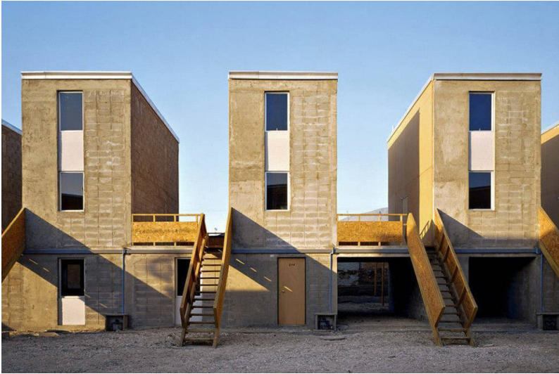
▲ Le abitazioni prima del processo di 'occupazione' degli abitanti. Fonte: elementalchile.cl
