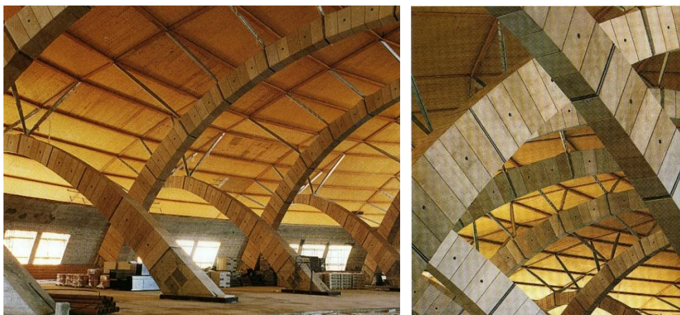
Fig. 14 Vista dell'interno dell'Aula Liturgia Padre Pio durante la costruzione e dettaglio degli archi in pietra armata progettati da Renzo Piano [Dernie, 2003, pp. 159, 162]
