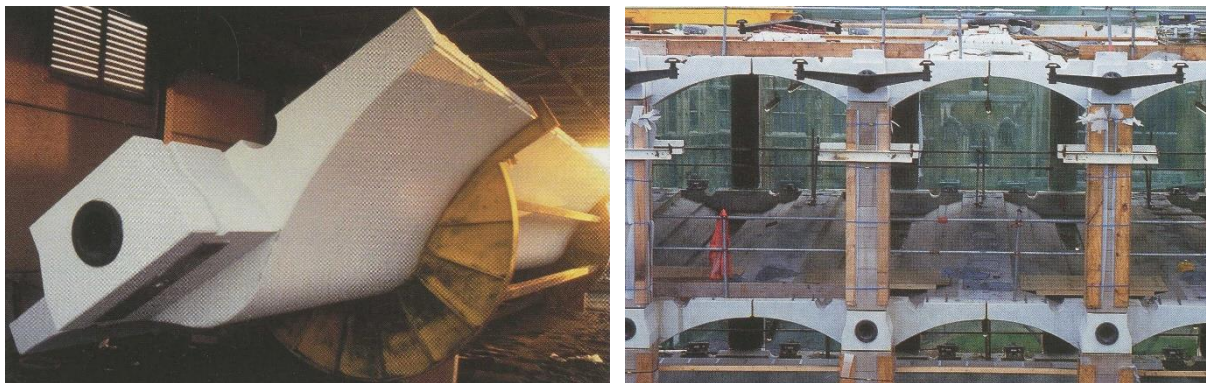
Una delle solette ad ala di gabbiano e il cantiere dell'edificio [Donati, 2001, p. 48]
