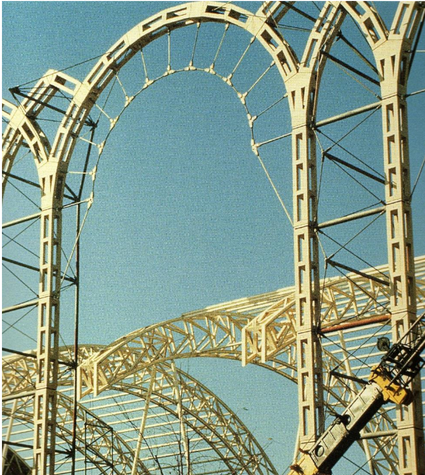
Fig. 62 Particolare degli archi in pietra armata del Padiglione del Futuro progettati da Rice [Dernie, 2003, p. 65]
