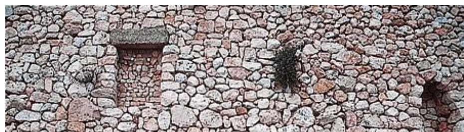
Fig. 138 Apparecchiatura muraria irregolare in pietre grezze [Acocella, 2012, su http://www.architetturadi pietra.it]
