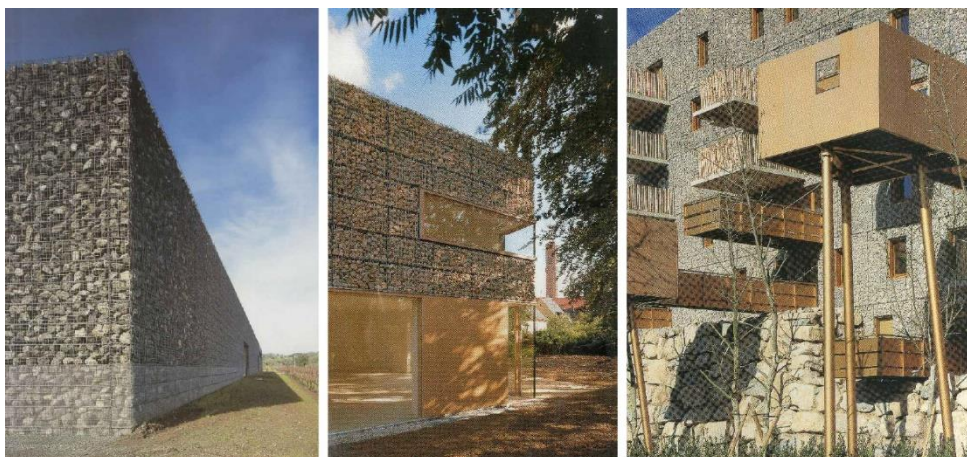
Fig. 17 Vista dell'esterno della Dominus Winery progettata da Herzog & de Meuron caratterizzata da una muratura in gabbioni; particolari dei prospetti della casa privata Haus 9x9 progettata da Titus Bernhard e dell'edificio residenziale Château-Le-Lez progettato da Edouard François and Associates caratterizzati da un involucro a gabbioni [Betsky, 1998, p. 12; Redazionale, 2003b, p. 1275; Pousse, 2000, p. 75]
