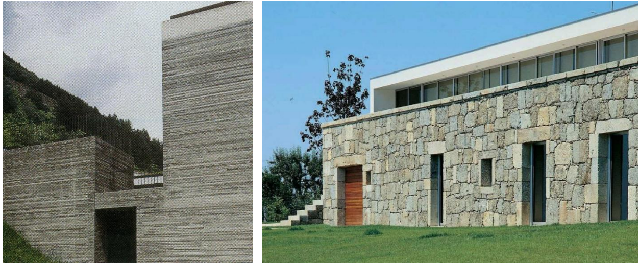
Fig. 11 Particolare del prospetto laterale delle terme di Vals progettate da Zumthor; il prospetto principale della Casa a Bom Jesus progettata da Souto de Moura [Acocella, 2004, p. 166; Angelillo, 2017, su http://www.architetturadi Pietra.it ]
