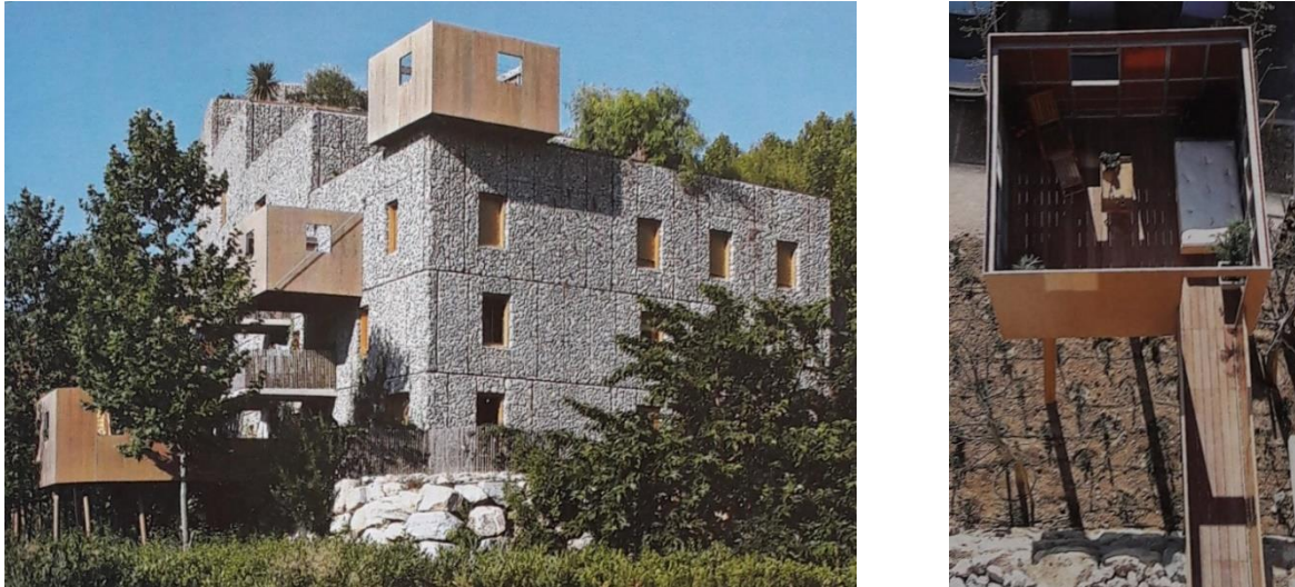
Fig. 152 Vista dell'esterno dell'edificio Château-le-lez e vista dall'alto di una delle logge [Redazionale, 2007, p. 71; Pousse, 2000, p. 74]
