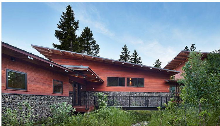
Fig. 103 Vista dell'esterno della residenza Base Camp [ http://www.architecturelab.net ]
