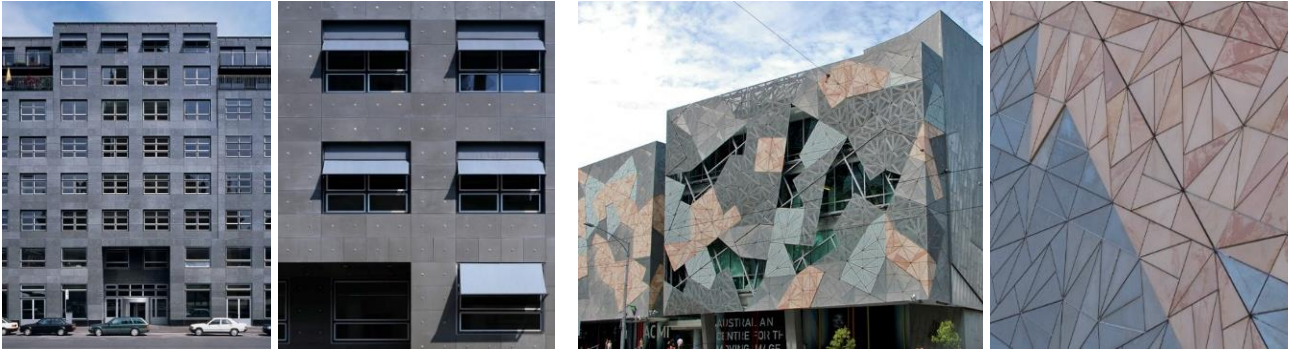
Fig. 5 L'edificio per appartamenti ed uffici Bewag progettato da Max Dudler e vista di dettaglio della facciata ventilata con rivestimento in lastre sottili di arenaria grigia e ancoraggi a vista; il centro culturale di Federation Square progettato da Lab architecture studio e vista di dettaglio della facciata con rivestimento in arenaria, vetro e acciaio zincato [https://www.maxdudler.de; https://en.wikipedia.org]
