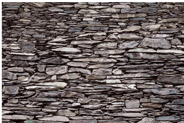
Fig. 147 Muro ad elementi stratificati [Acocella, 2012, su http://www.architetturadi pietra.it ]
