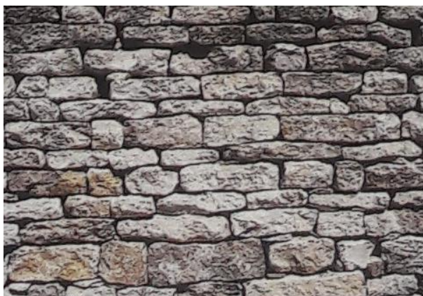
Fig. 146 Apparecchiatura muraria ad elementi sbazzati [Acocella, 2004, p. 103]
