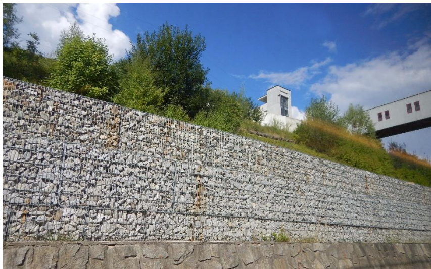
Fig. 63 Muro in gabbioni realizzato nella stazione ferroviaria di Perca-Plan de Coronas (Bz) [foto Silvia Mariani]
