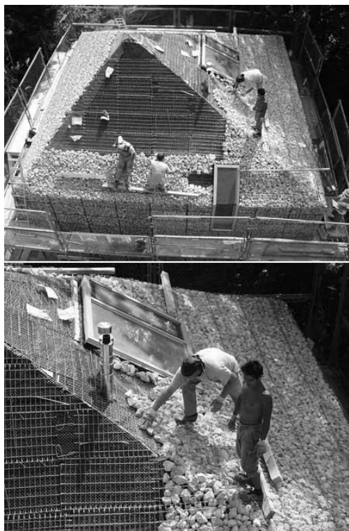
Immagini delle fasi esecutive dell'involucro in gabbioni; sezione [Turrini, 2007b, su http://www.architetturadi pietra.it ; Pongratz, Perbellini, 2009, p. 37]
