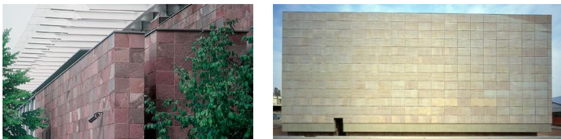
Fig. 4 Vista di un setto del Museo della Fondazione Beyeler Riehen progettato da Renzo Piano; la facciata della sede del Laboratorio Prove Materiali dello IUAV progettata da Francesco Venezia [Acocella, 2004, p. 434; http://www.iuav.it ]
