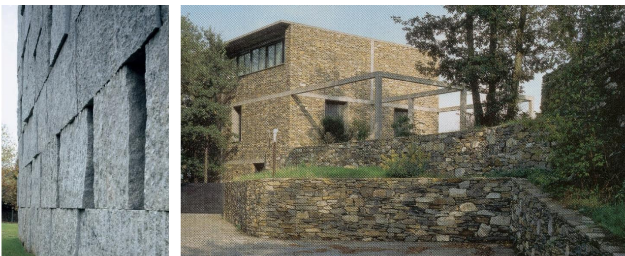
Fig. 13 Dettaglio della muratura lapidea del Scuola di Alti Studi Musicali della Galizia progettata da Abril; vista dell'esterno della Stone House progettata da Herzog & de Meuron [Pavan, 2013, p. 133; Mack, 1997, p. 65]
