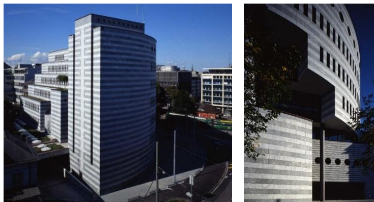
Fig. 6 L'edificio sede dell'Unione delle Banche Svizzere progettato da Mario Botta [http://www.botta.ch]
