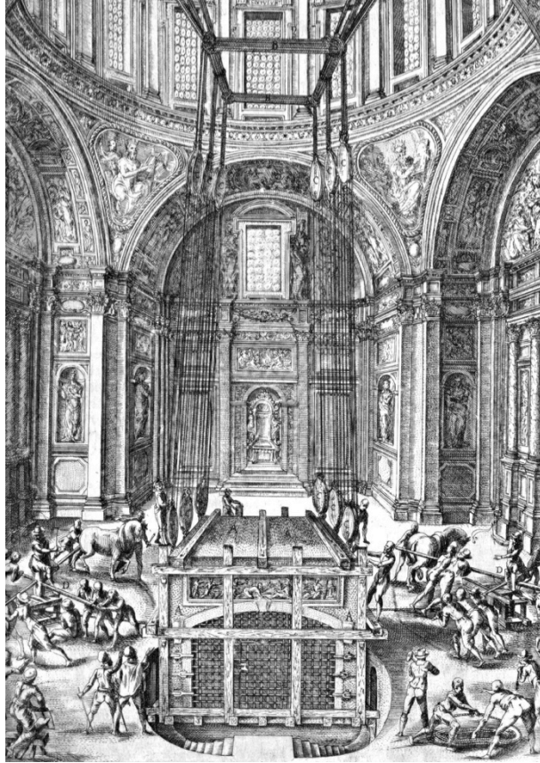
fig. 13: Inserimento della Cappella del Presepe nella nuova Cappella Sistina. Da FONTANA, Della Trasportatione dell'Obelisco Vaticano cit., p. 53.
