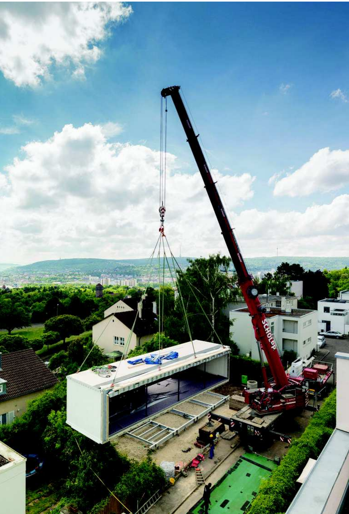
▷ Werner Sobek - B10 (2014) Stoccarda (Germania) - Aktivhaus - assemblaggio - Fonte: © Zooney Braun
