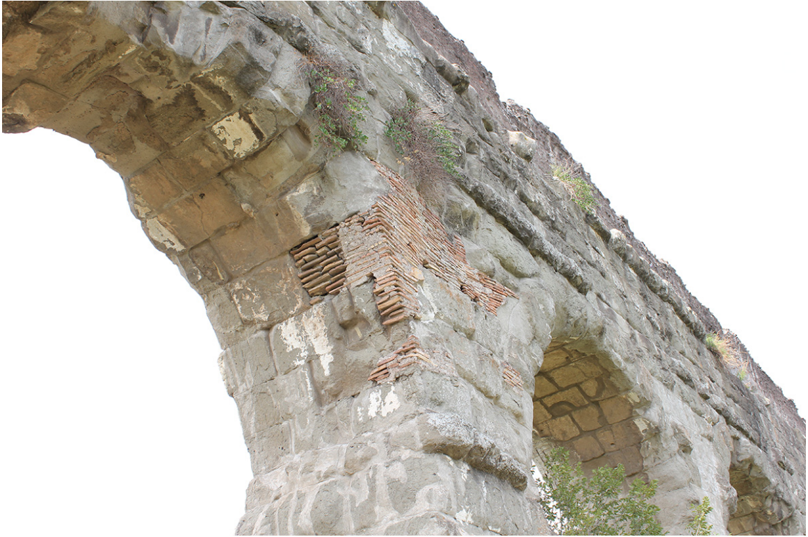
Fig. 37 – Particolare di risarcitura di blocchi con muratura laterizia (Foto L. Radicioni).
