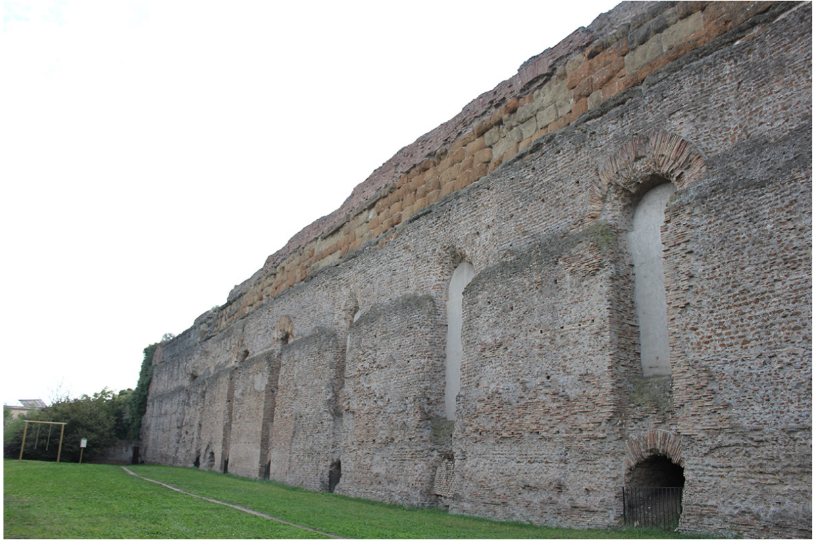
Fig. 35 – Muratura di ispessimento dell'acquedotto, area della Banca d'Italia (Foto L. Radicioni).
