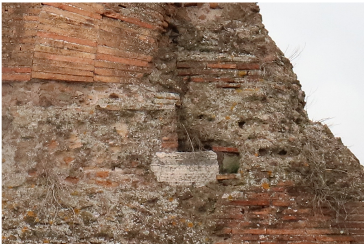
Fig. 45 – Particolare della cornice in laterizio, sottarco del fornice I (Foto L. Radicioni).
