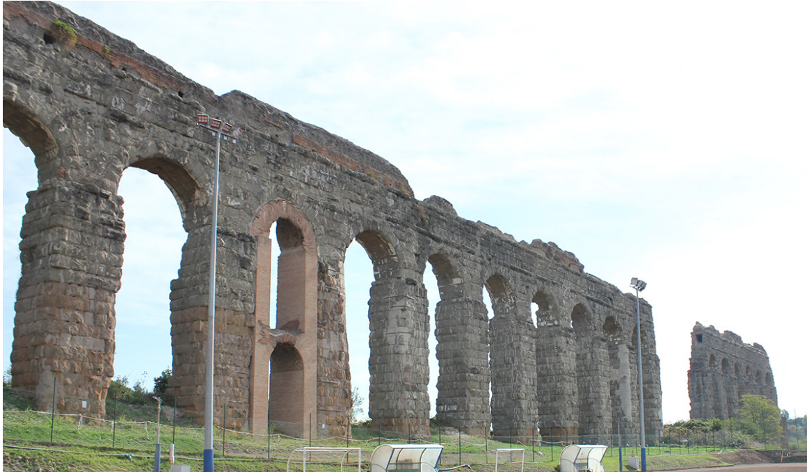
Fig. 24 – Esempio di piloni composti da materiale misto, nel tratto presso Via del Quadraro (Foto L. Radicioni).
