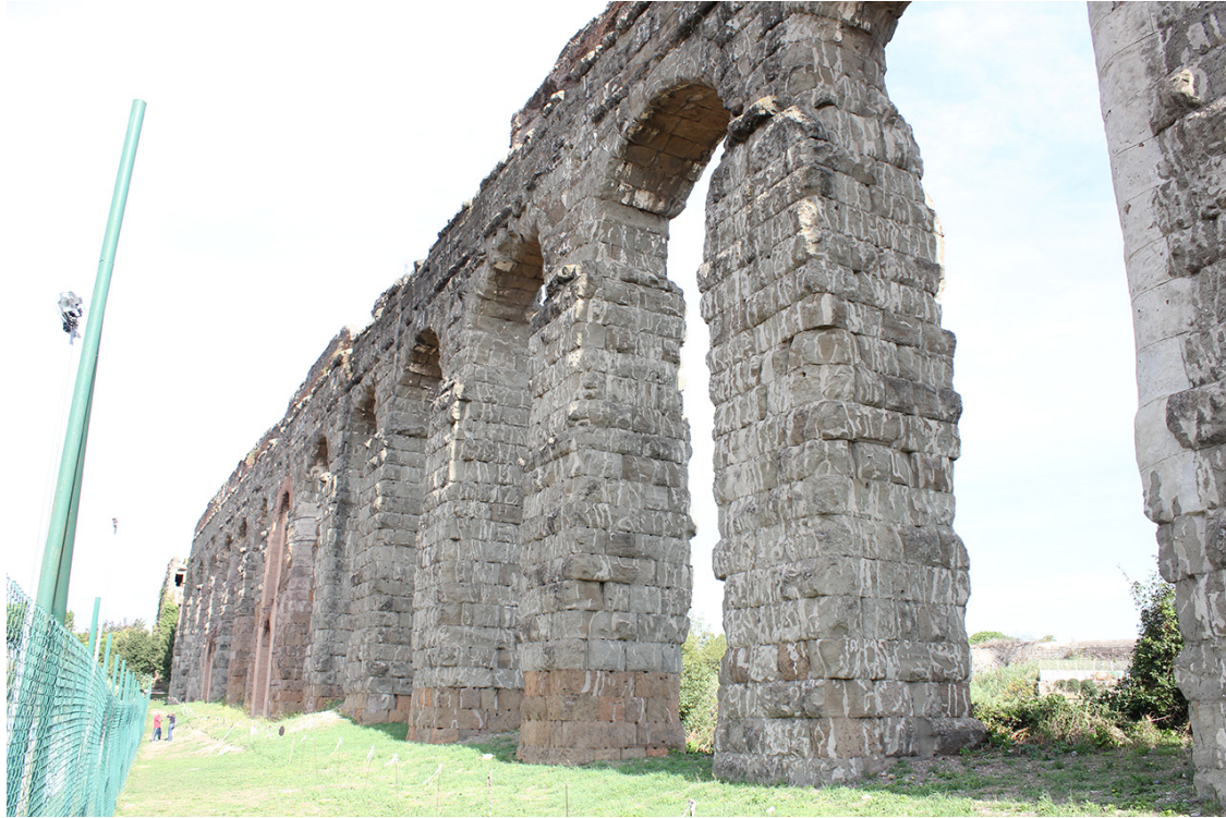
Fig. 39 – Uso di materiali diversi negli stessi piloni, Via del Quadraro (Foto L. Radicioni).
