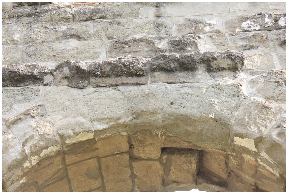
Fig. 29 – Lastre solo in parte lavorate a cornice aggettante, Via del Quadraro (Foto L. Radicioni).
