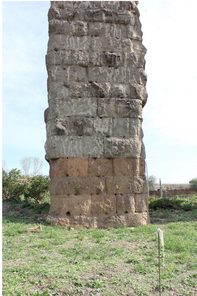
Fig. 40 – Particolare della maggiore erosione del tufo dell’Aniene rispetto al peperino (Foto L. Radicioni).
