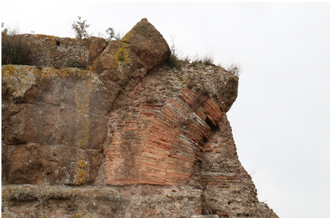
Fig. 44 – Doppia ghiera del sottarco nel fornice I (Foto L. Radicioni).
