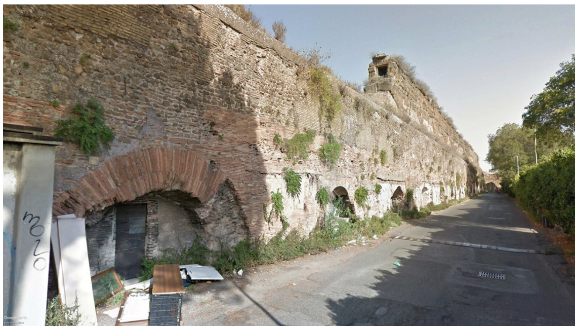
Fig. 1 – Ispessimento del lato E dell'acquedotto in Via del Mandrione (Fonte: Google).
