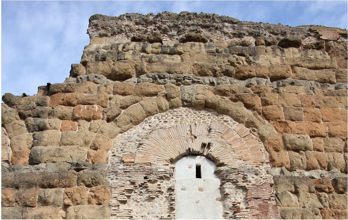
Fig. 26 – Arco in blocchi del tratto presso Banca d'Italia (Foto L. Radicioni).
