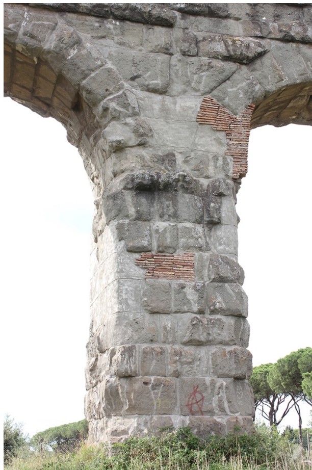
Fig. 38 – Particolare di risarcitura di blocchi con muratura laterizia (Foto L. Radicioni).
