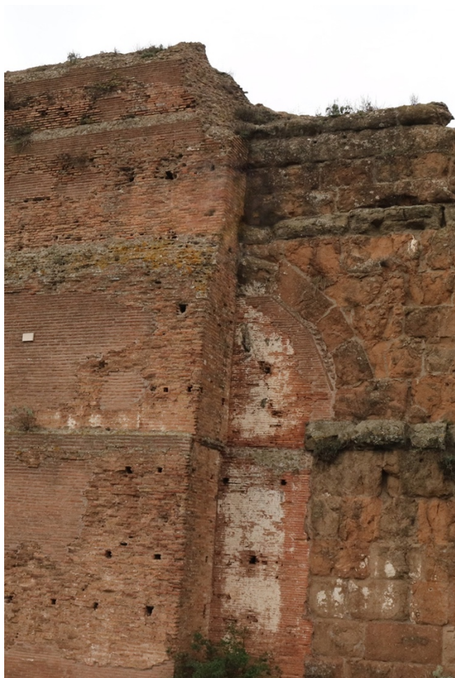
Fig. 56 – Fianco destro della muratura tarda sul lato O (Foto L. Radicioni).
