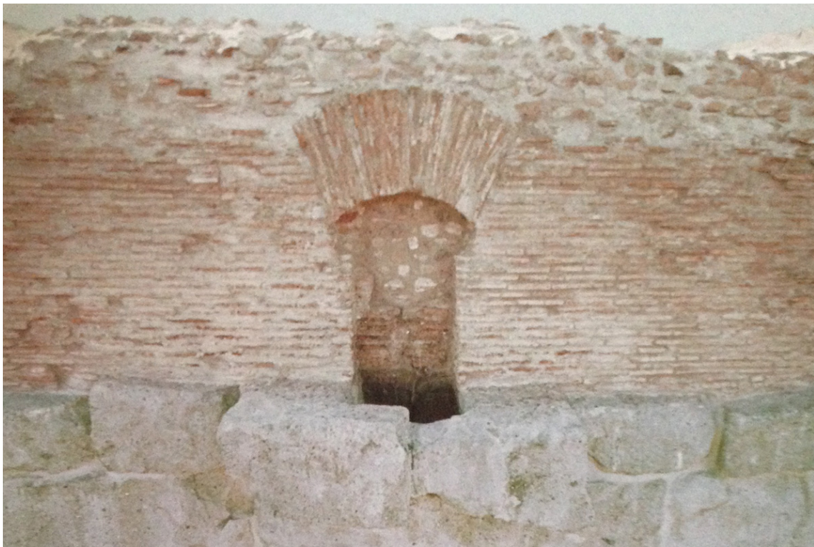
Fig. 63 - Apertura sulla sommità dello speco della Claudia rispettata dallo speco dell' Anio Novus (MANCIOLI-PISANI SARTORIO 2001, p. 175 fig. 9).
