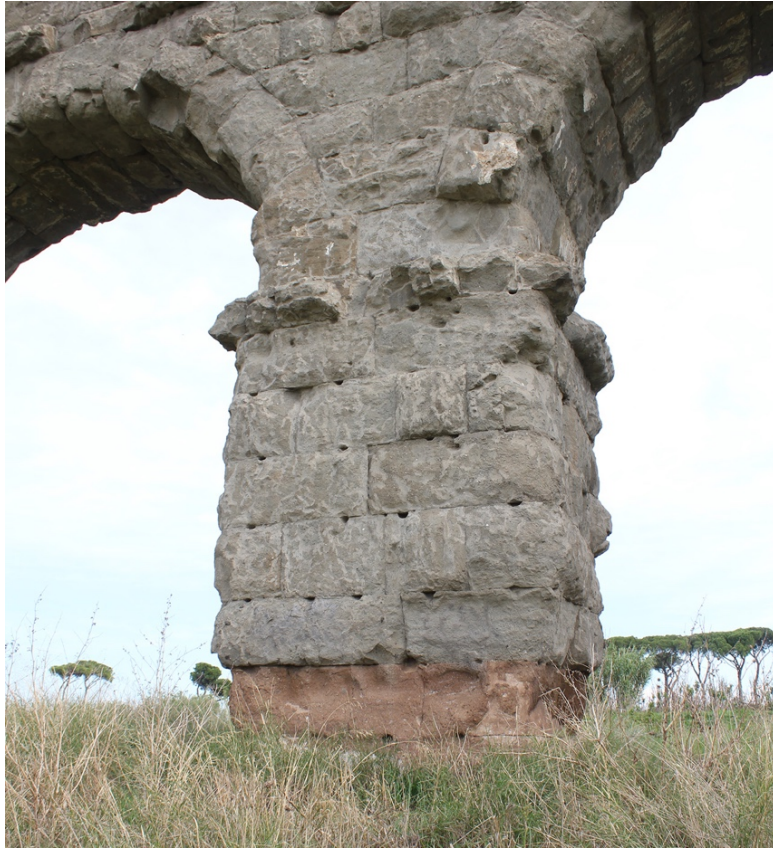
Fig. 67 – Maggiore erosione del tufo lionato rispetto al peperino (Foto L. Radicioni).
