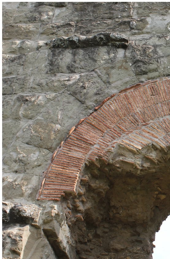
Fig. 31 – Particolare della cornice in bipedali aggettante dal filo dell'arco in laterizio, Parco degli Acquedotti, pressi del casale di Roma Vecchia (Foto L. Radicioni).
