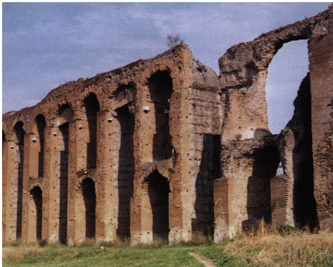
Fig. 34 – Sottarchi dei fornici congiunti da archi, Parco di Tor Fiscale (MANCIOLI-PISANI SARTORIO 2001, p. 41 fig. 15).
