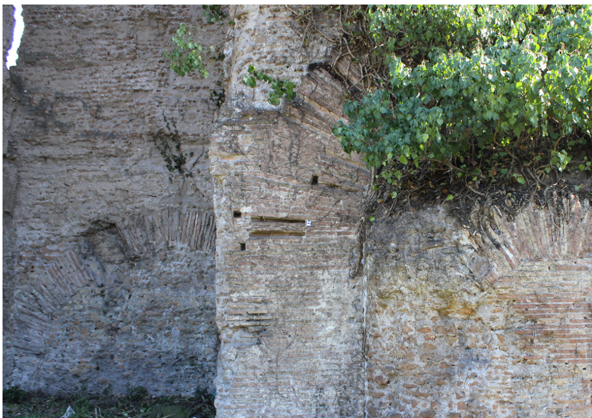
Fig. 48 – Arco in laterizio inferiore, fornice XVI (Foto L. Radicioni).
