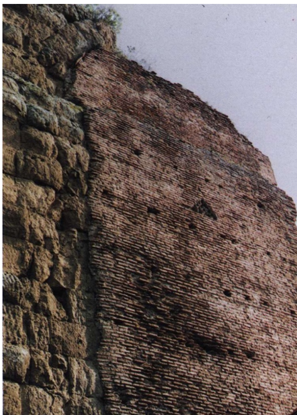
Fig. 60 – Specchiatura triangolare di opera reticolata su tamponatura presso Via di Torre Branca (MANCIOLI-PISANI SARTORIO 2001, p. 41 fig. 16).
