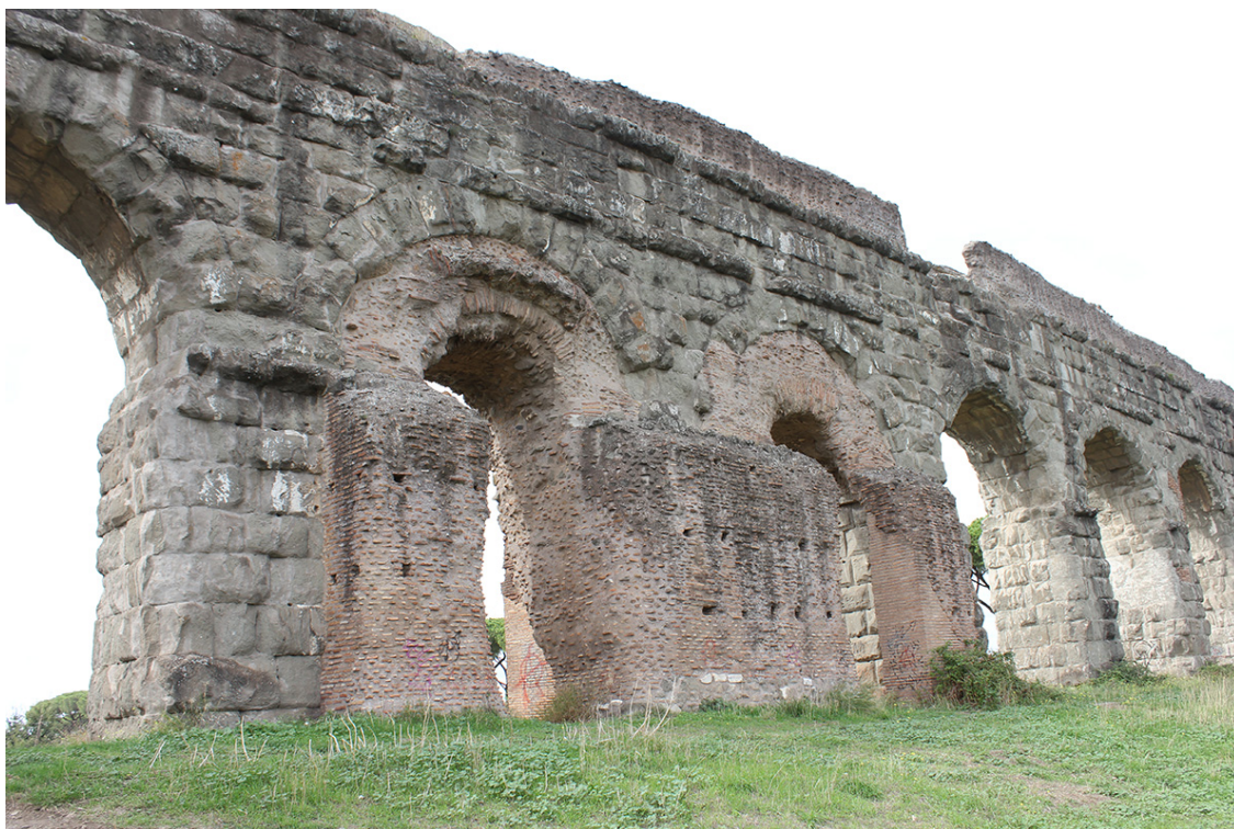
Fig. 33 – Intervento di sottarcatura congiunto a ispessimento su tutti i lati del pilone, Roma Vecchia (Foto L. Radicioni).
