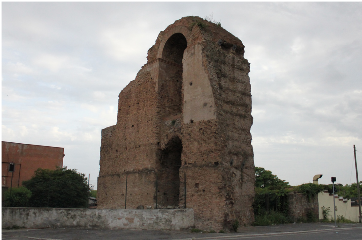
Fig. 50 – Sottarco isolato, Via Frascati (Foto L. Radicioni).
