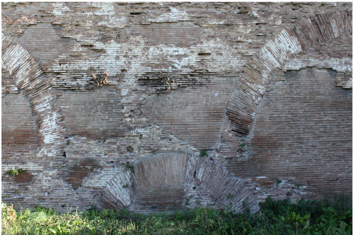
Fig. 52 - Piccolo arco di scarico in corrispondenza del fornice IV (Foto L. Radicioni).
