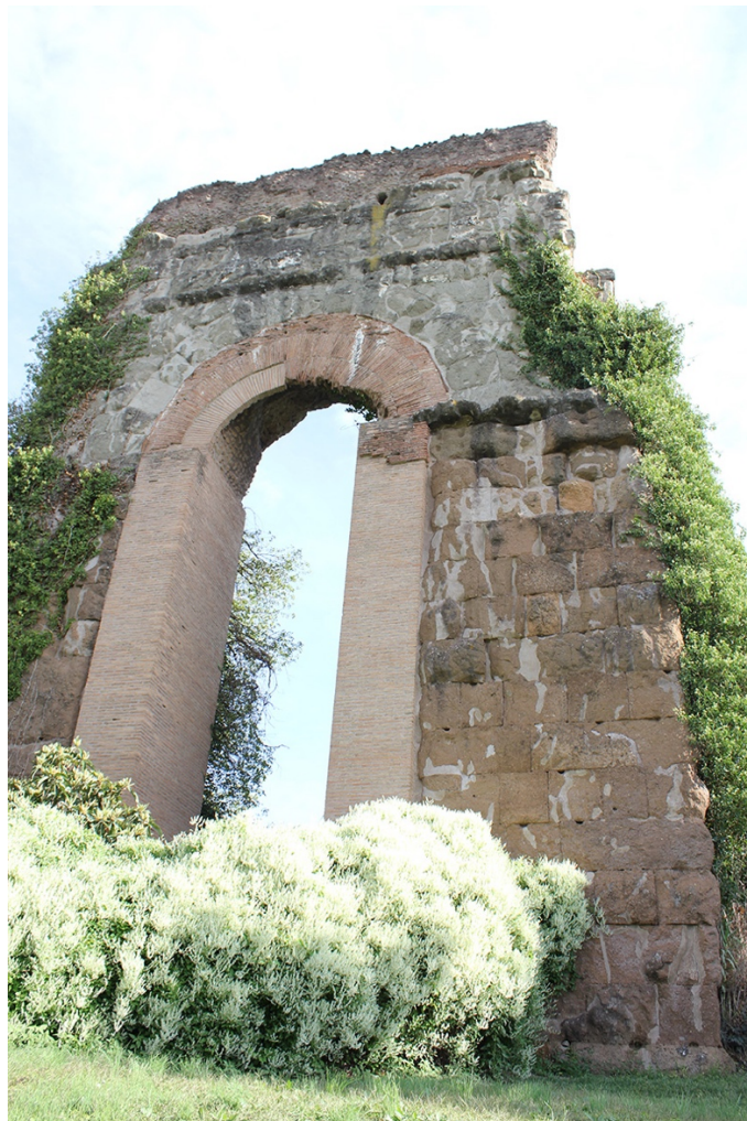
Fig. 25 – Pilone completamente in tufo marrone, Via del Quadraro (Foto L. Radicioni).
