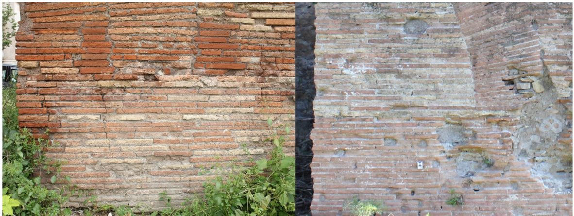
Fig. 70 – Confronto fra le cortine laterizie di Aqua Alexandriana a sinistra e muratura di ispessimento dell' Aqua Claudia a Porta Furba a destra (Foto L. Radicioni).
