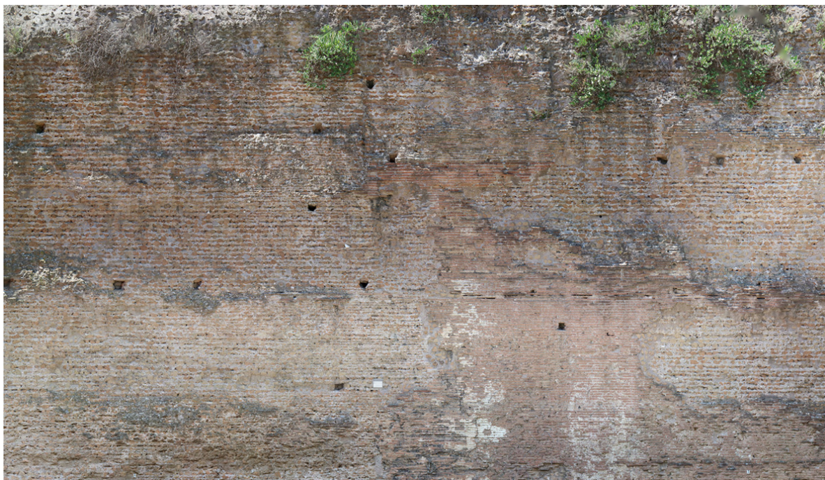
Fig. 54 – Sfalsamento dei filari di fori da ponte, Lato E (Foto L. Radicioni).
