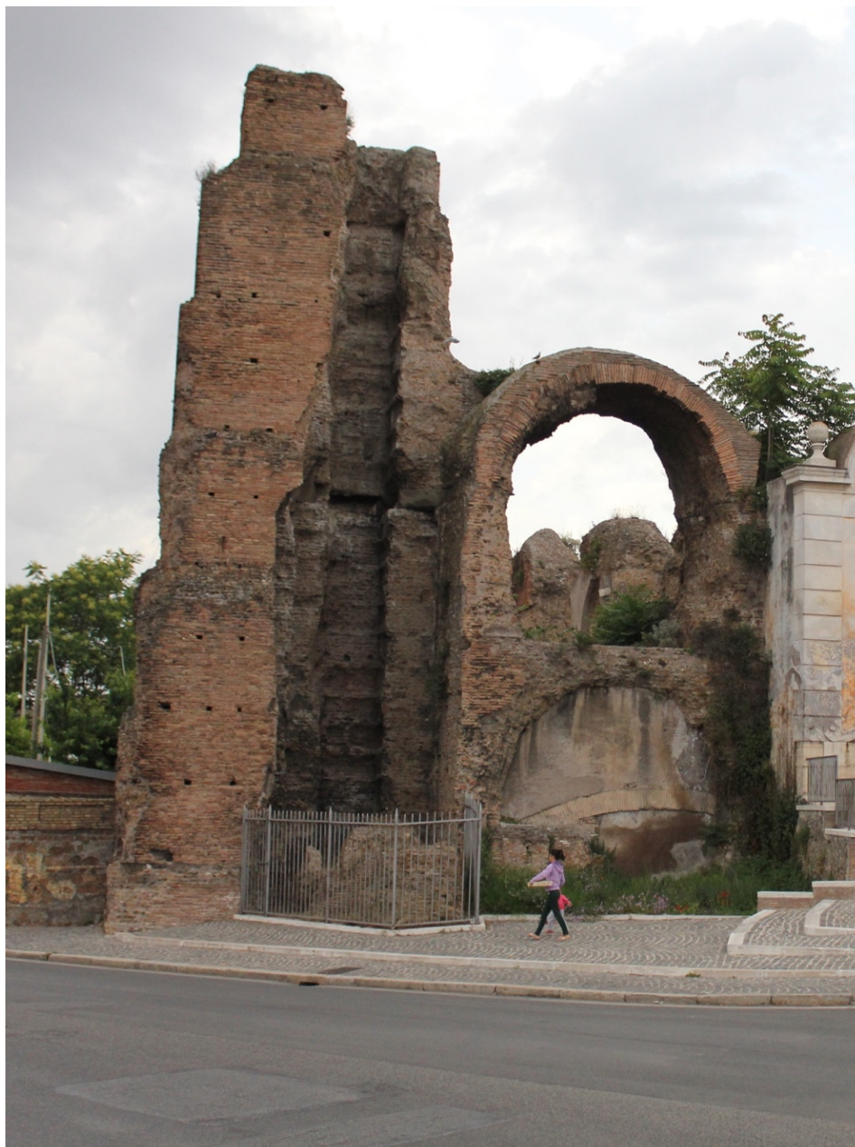
Fig. 64 – Strutture di rinforzo del pilone d'angolo, completamente asportato, dell'Acquedotto di Claudio a Porta Furba (Foto L. Radicioni)
