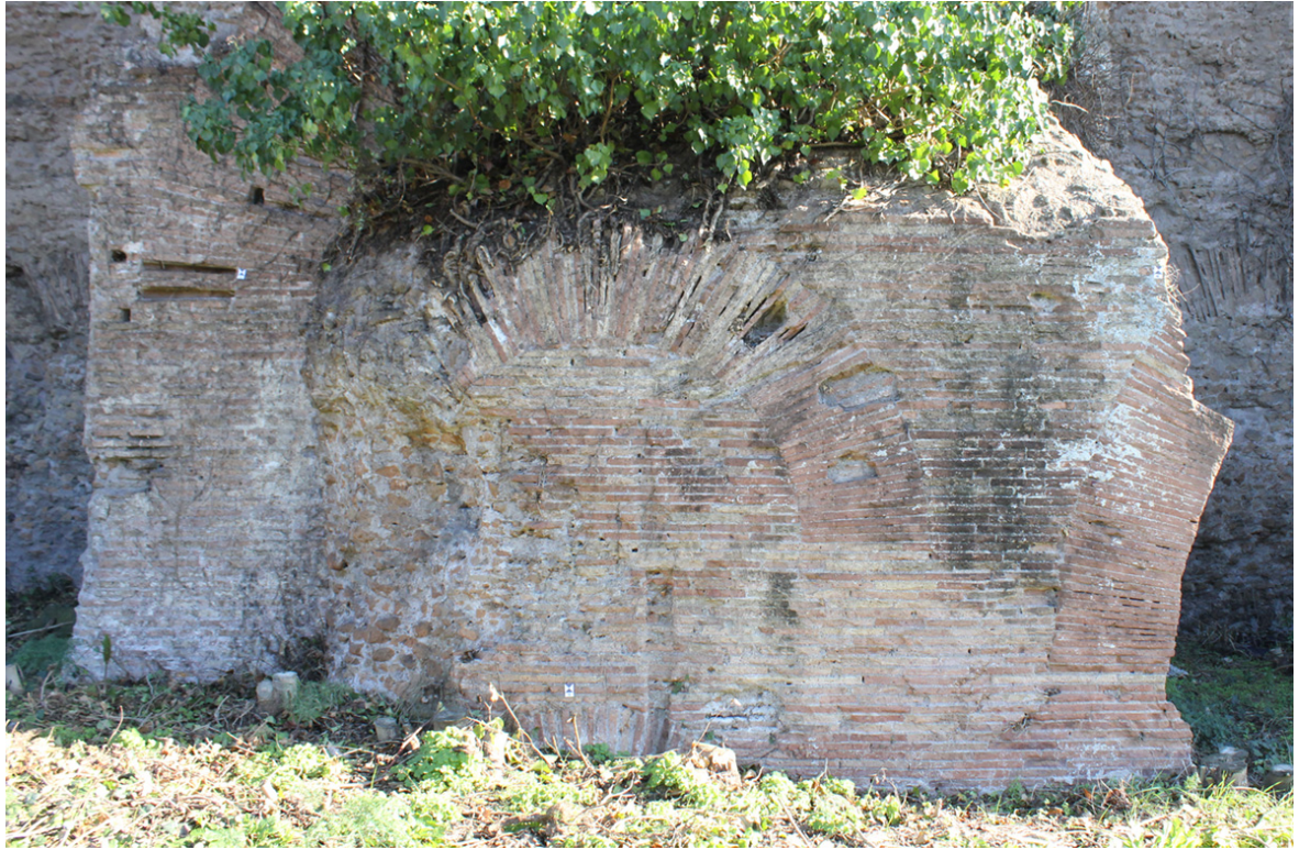
Fig. 53 – Piccoli archi di scarico sovrapposti in corrispondenza del fornice XVI (Foto L. Radicioni).
