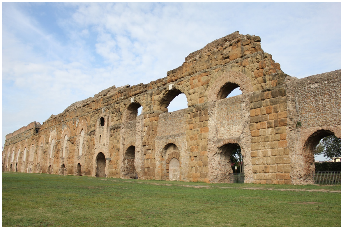
Fig. 21 – Acquedotto Felice alla Banca d’Italia: il condotto cinquecentesco passa attraverso i piloni dell’acquedotto di Claudio (Foto L. Radicioni).
