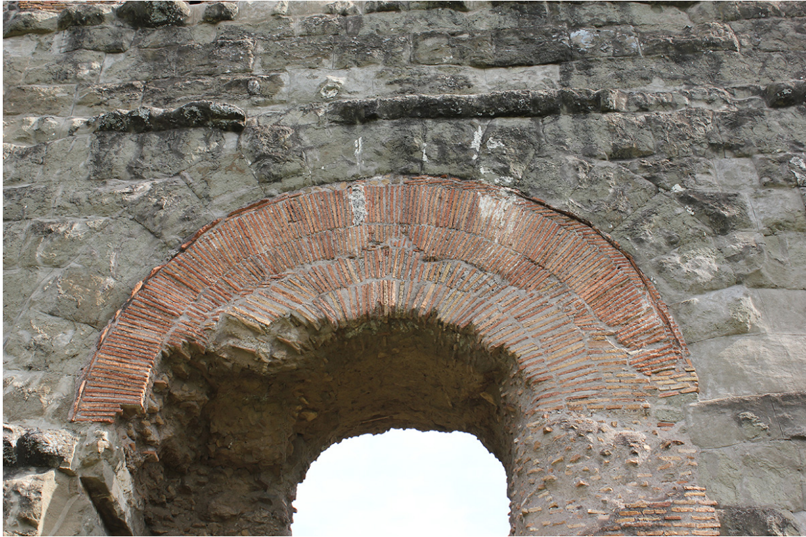
Fig. 32 – Sottarco con lunetta in laterizio di raccordo minima ed ulteriore arco che lo restringe a sua volta, Parco degli Acquedotti, pressi del casale di Roma Vecchia (Foto L. Radicioni).
