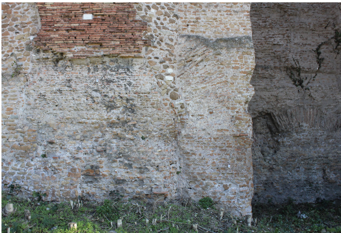
Fig. 47 - Traccia nel conglomerato dell'arco inferiore, fornice XVII (Foto L. Radicioni).
