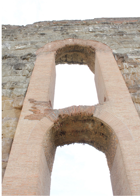
Fig. 30 – Sottarchi su due ordini, Via del Quadraro (Foto L. Radicioni).
