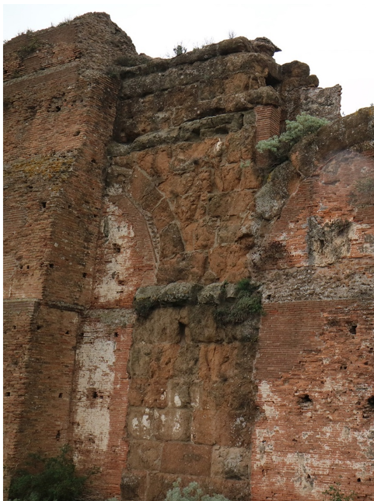
Fig. 41 – Cornici in tufo peperino all'imposta delle arcate (Foto L. Radicioni).
