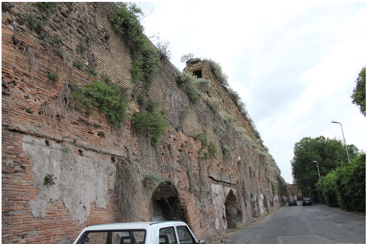
Fig. 36 – Muratura di ispessimento con nicchie, inizio di Via del Mandrione a Porta Furba (Foto L. Radicioni).
