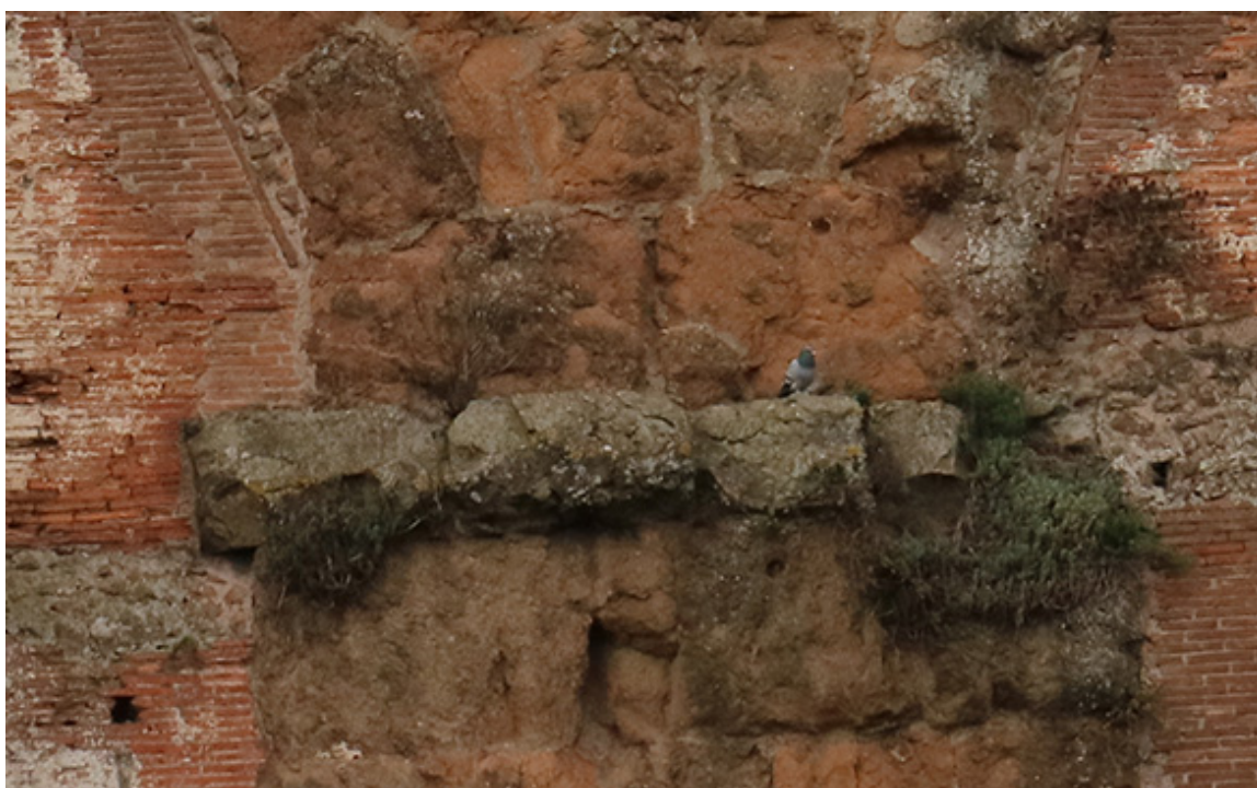
Fig. 42 - Particolare dei peducci delle arcate (Foto L. Radicioni).
