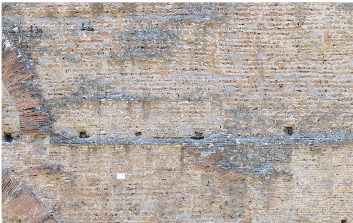
Fig. 55 – Interruzione del quinto ricorso in bipedali, Lato E a destra del fornice IX (Foto L. Radicioni).
