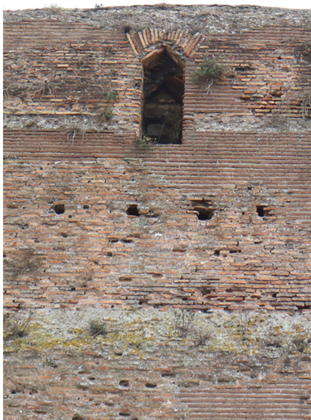
Fig. 61 – Canale a cappuccina su muratura tarda, Lato O (Foto L. Radicioni).
