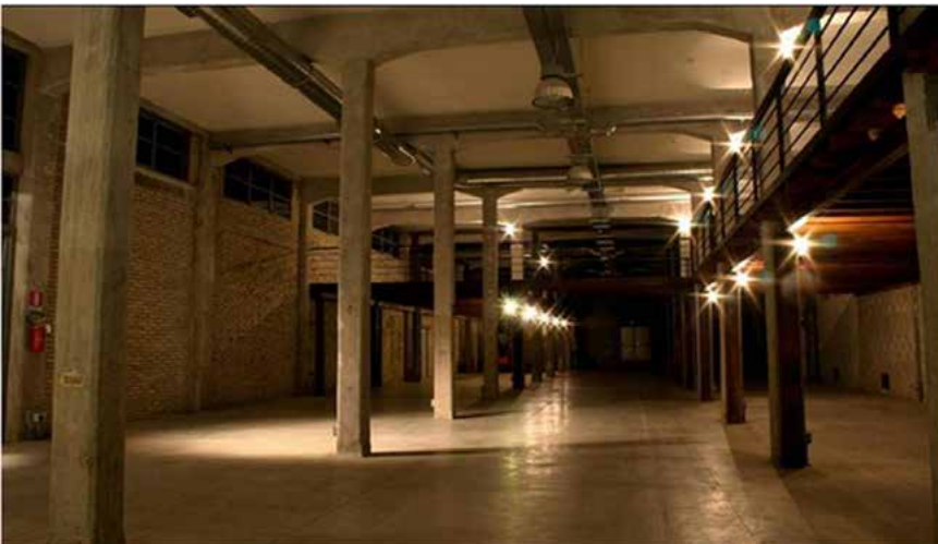
Figura 2a. L'attuale sistema di illuminazione crea fenomeni di abbagliamento tali da compromettere la visibilità delle attuali segnaletiche, sia in condizioni normali che di massimo affollamento.
